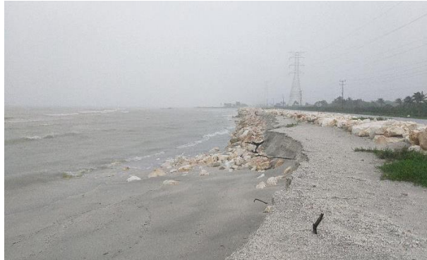
Foto 21. Carretera Ciudad del Carmen – Campeche en el Estado de Campeche, junio 2020.
