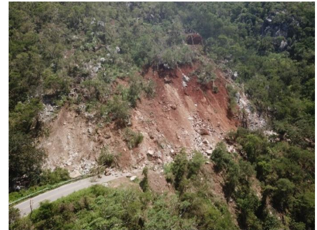
Foto 3. Carretera Guadalajara – Barra de Navidad en el Estado de Jalisco, septiembre 2021.
