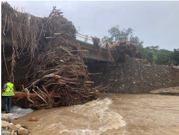
Foto 15. Puente “Las juntas”, Carretera Carapan – Playa Azul en el Estado de Michoacán, agosto 2021.
