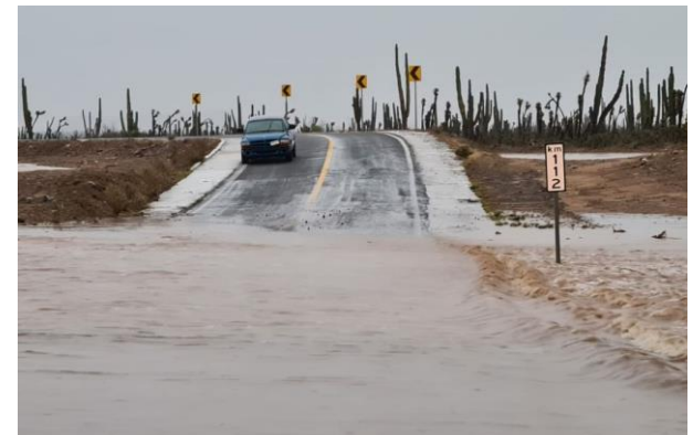
Foto 24. Carretera Loreto – Santa Rosalía en el Estado de Baja California Sur, agosto 2021.
