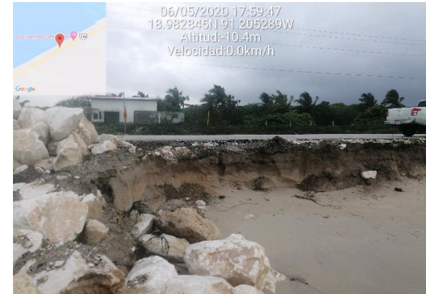
Foto 10. Carretera Ciudad del Carmen – Campeche en el Estado de Campeche, junio 2020.
