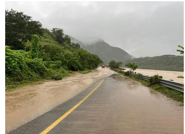
Foto 7. Carretera Chilpancingo - Acapulco – Estado de Guerrero, octubre 2023
