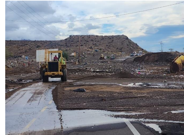
Foto 13. Carretera Santa Rosalía – Paralelo 28°, Estado de Baja California Sur, agosto 2023
