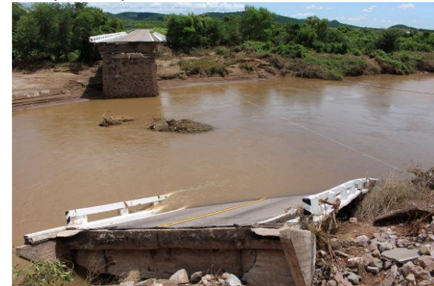
Foto 14. Puente “Quelite” en la carretera Mazatlán – Culiacán en el Estado de Sinaloa, agosto 2021.
