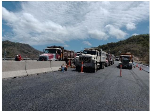
Figura 6. Prueba de carga sobre el puente Las Truchas
