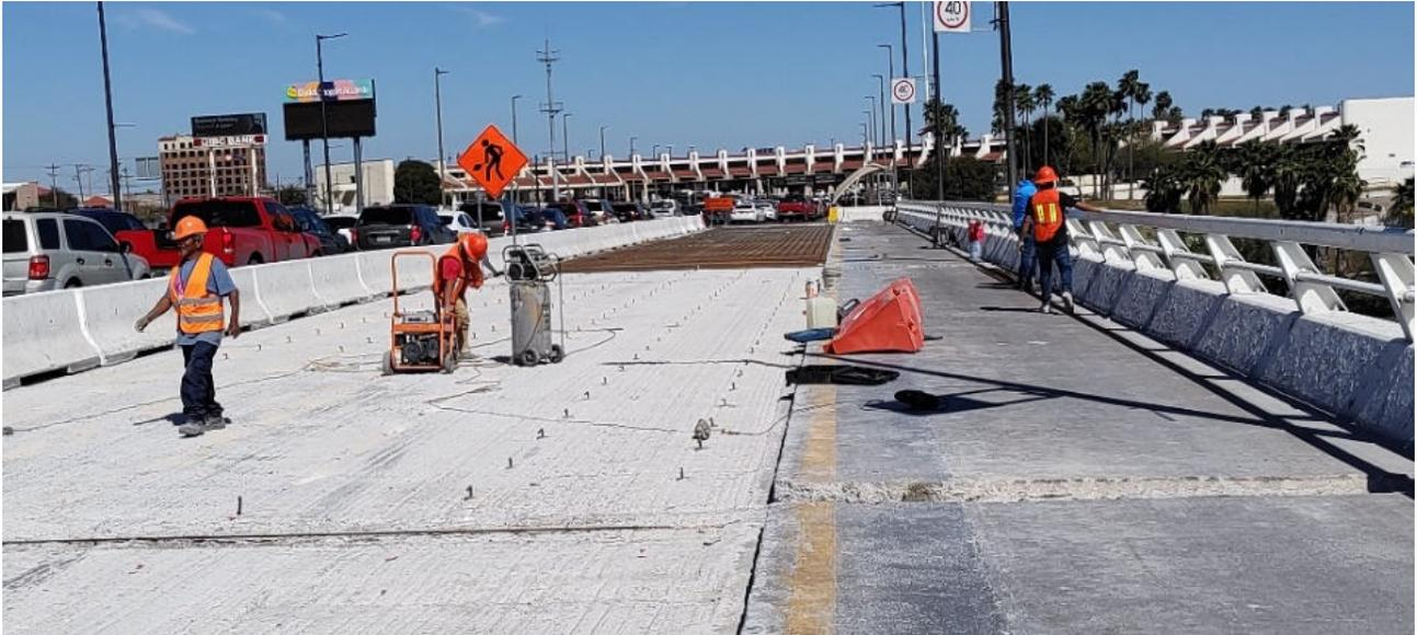
Perforaciones para fijación de anclaje con cementante de alta resistencias que mejoran las propiedades de adherencia, para una mayor seguridad del armado de acero de refuerzo en sobre losa de superficie de rodamiento. Puente Internacional Juárez-Lincoln, Nuevo Laredo, Tamaulipas.
