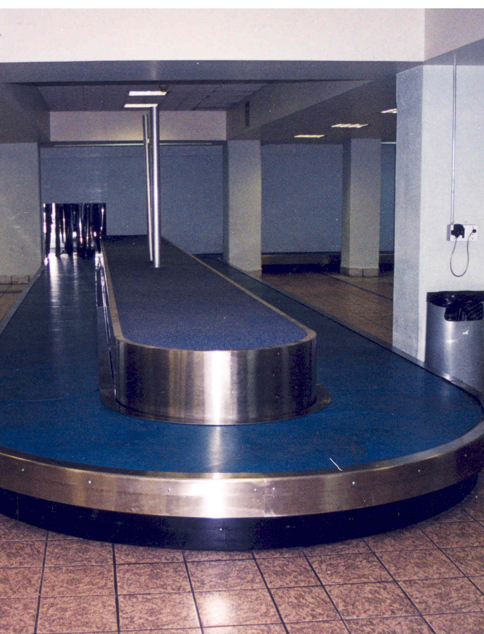
Aeropuerto Internacional de la Ciudad de México Sustitución de bandas en zona de reclamo de equipaje nacional
