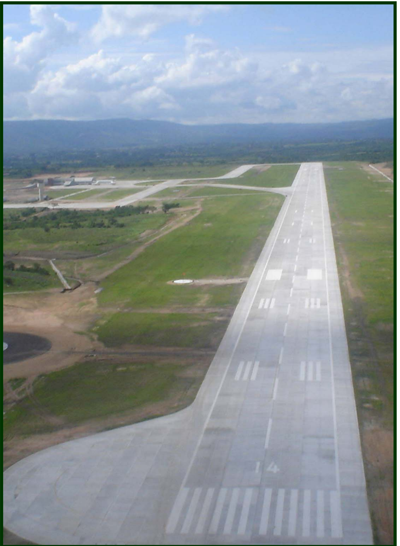
Aeropuerto Ángel Albino Corzo, Chiapas. Construcción de losas de concreto hidráulico en pista, plataforma, rodajes y caminos.
