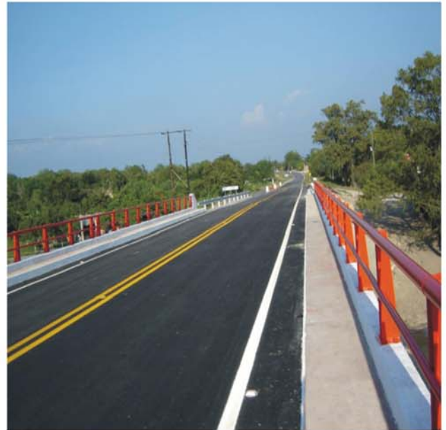
Carretera: Valles - Victoria, Tamps. Puente Guayalejos.
