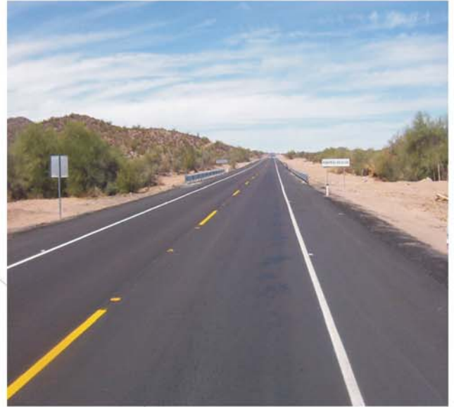
Carretera: Playa General Lauro de Villar - Tijuana, Son. Tramo: Caborca - Sonoyta.
