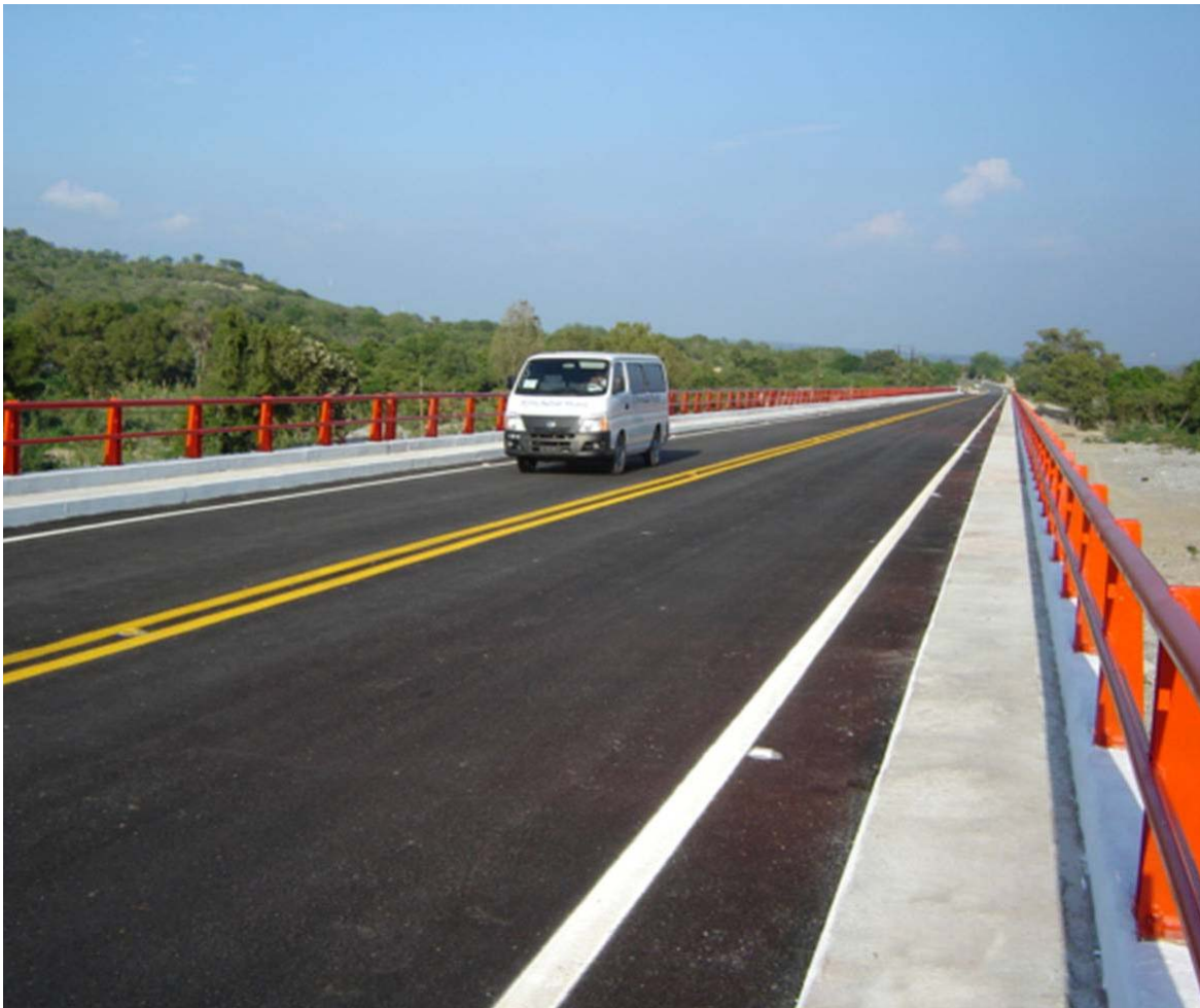
Carretera: Valles-Victoria, Tamaulipas. Puente Guayalejo.
