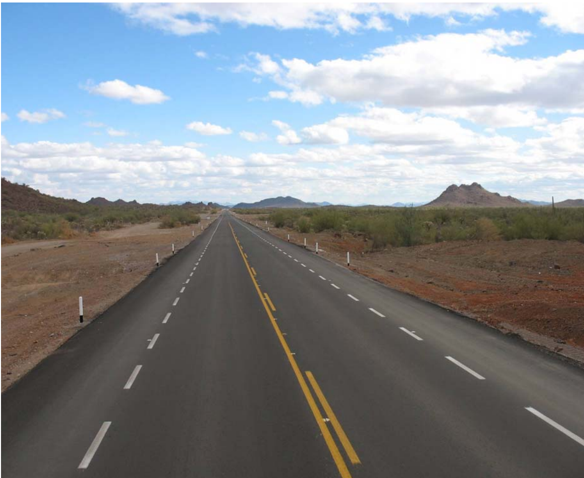
Carretera: Playa General Lauro del Villar-Tijuana, Sonora. Tramo: Caborca-Sonoyta.
