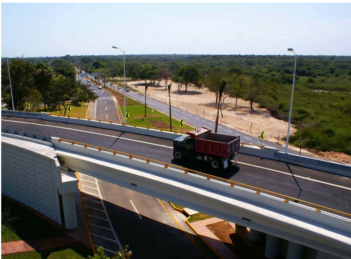
Carretera: Escárcega-Chetumal, Quintana Roo. Entronque a desnivel "Insurgentes".
