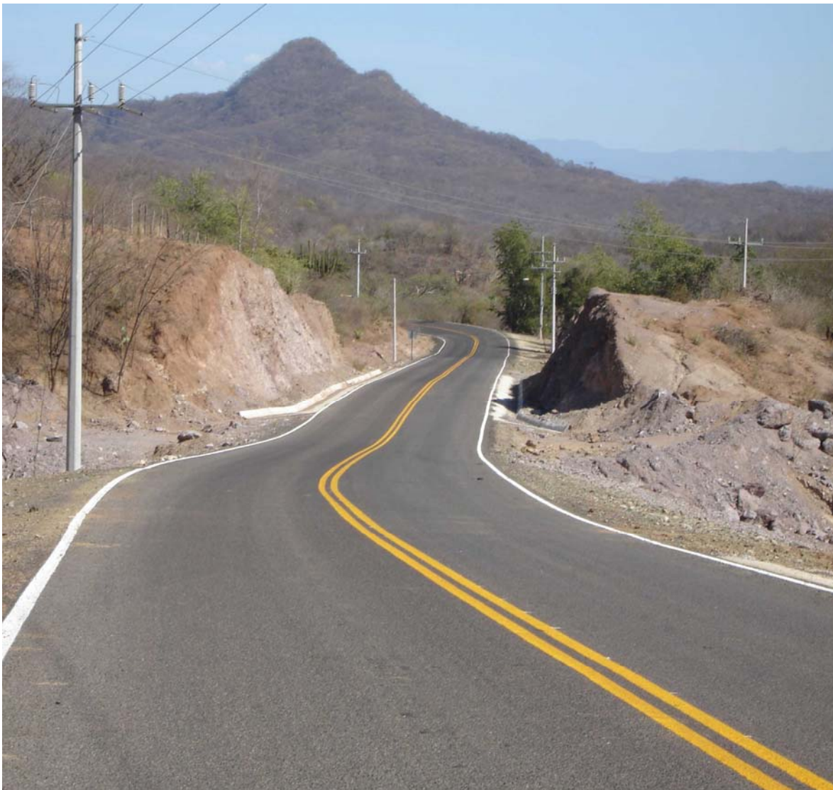
Carretera: Durango-Mazatlán, Sinaloa. Entronque Concordia-Copala.
