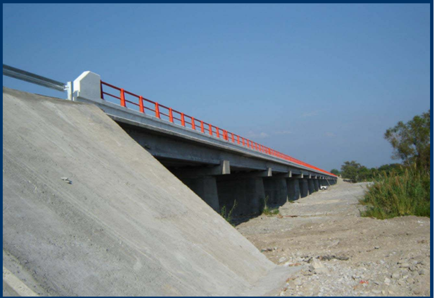
Carretera: Valles-Victoria, Tamaulipas. Puente Guayalejo.
