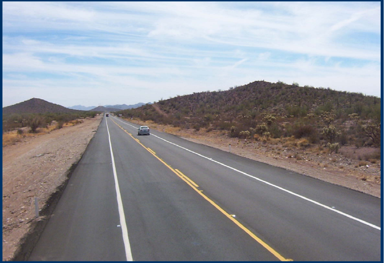
Carretera: Playa General Lauro del Villar-Tijuana, Sonora. Tramo: Caborca-Sonoyta.
