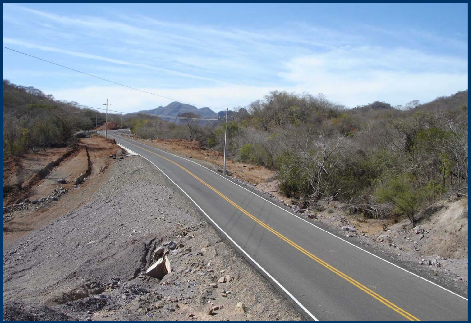
Carretera: Durango-Mazatlán, Sinaloa. Entronque Concordia-Copala.
