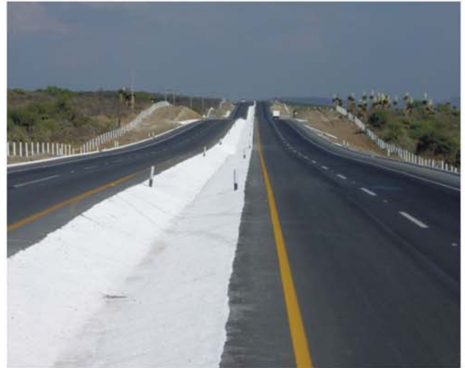
Carretera: San Luis Potosí - Zacatecas, S.L.P. Tramo: San Luis Potosí - Ahualulco.
