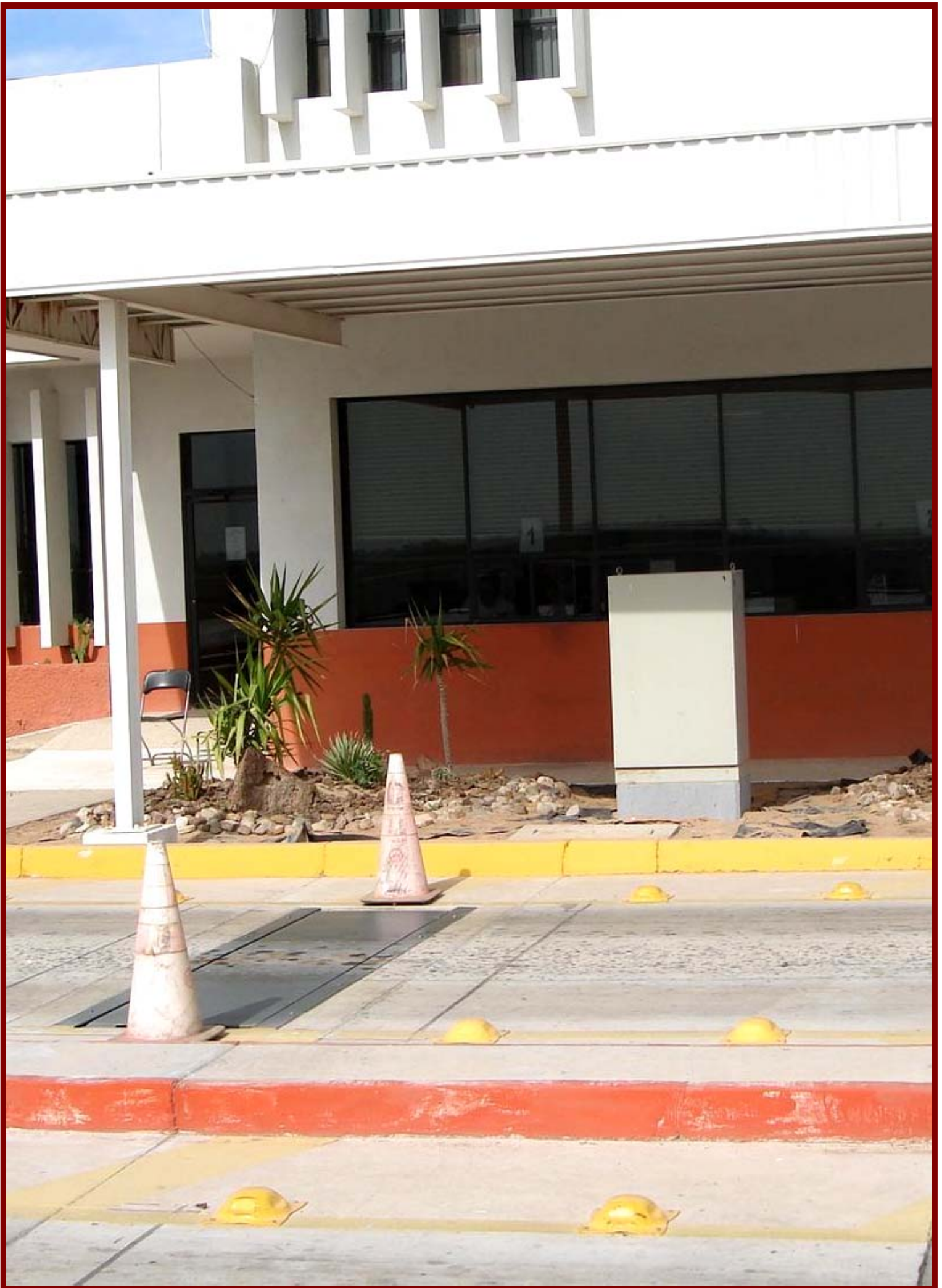
Adecuación del Centro de Peso y Dimensiones, Mexicali, Baja California.
