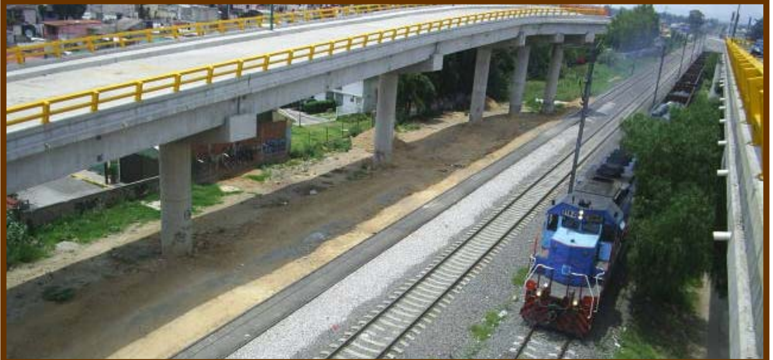
Tren Suburbano de la Zona Metropolitana del Valle de México. Construcción del puente “Los Fresnos”, Cuautitlán, Estado de México.
