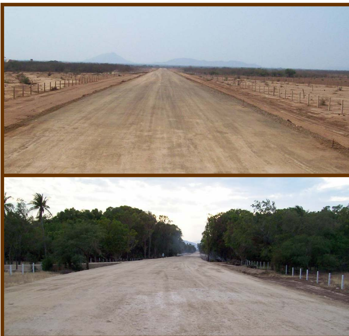
Ferrocarril del Istmo de Tehuantepec (FIT). Construcción de terracerías para el libramiento ferroviario de Santo Domingo Tehuantepec, Oaxaca.
