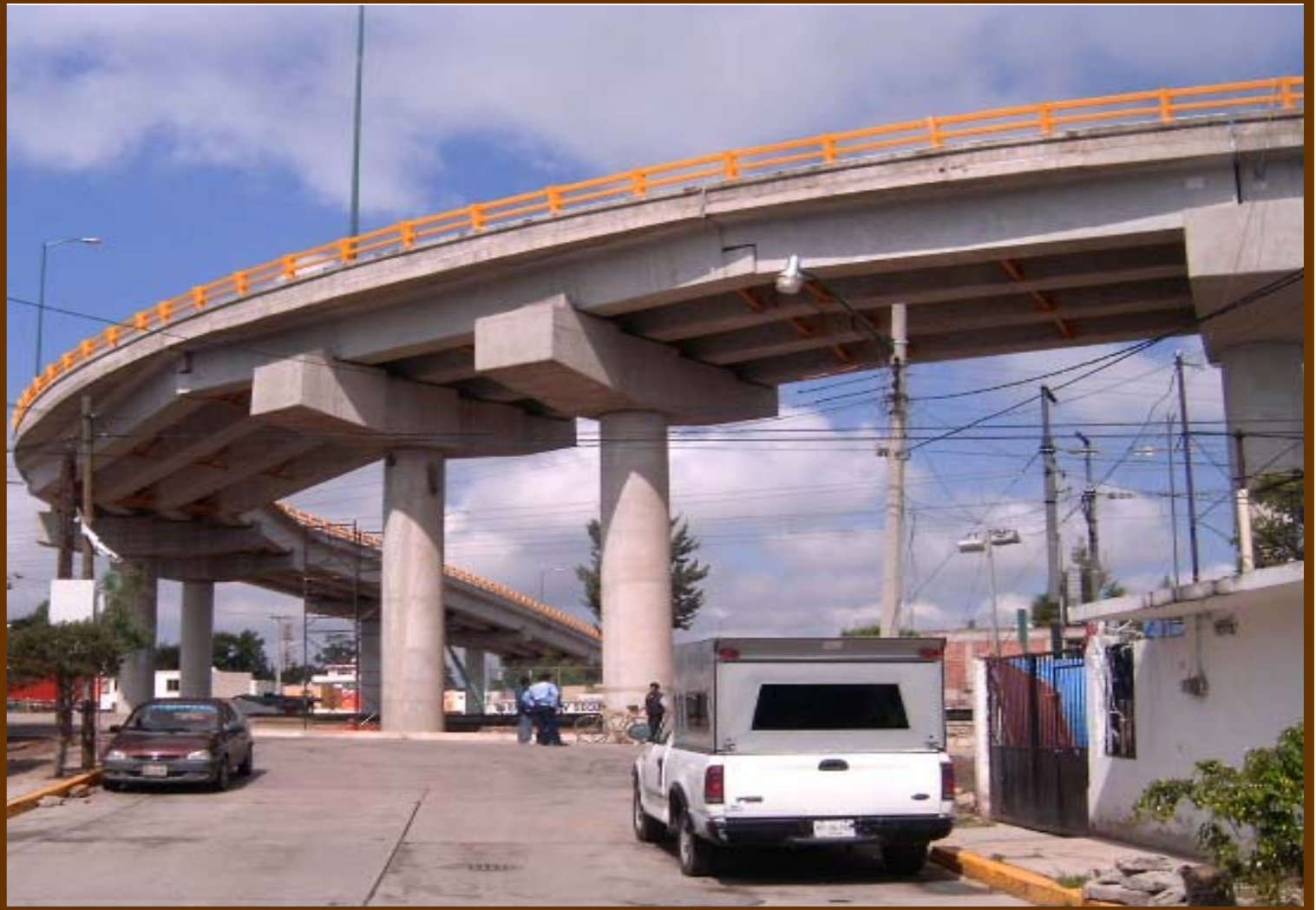
Puente vehicular "Los Fresnos". Tren Suburbano de la Zona Metropolitana de la Ciudad de México.
