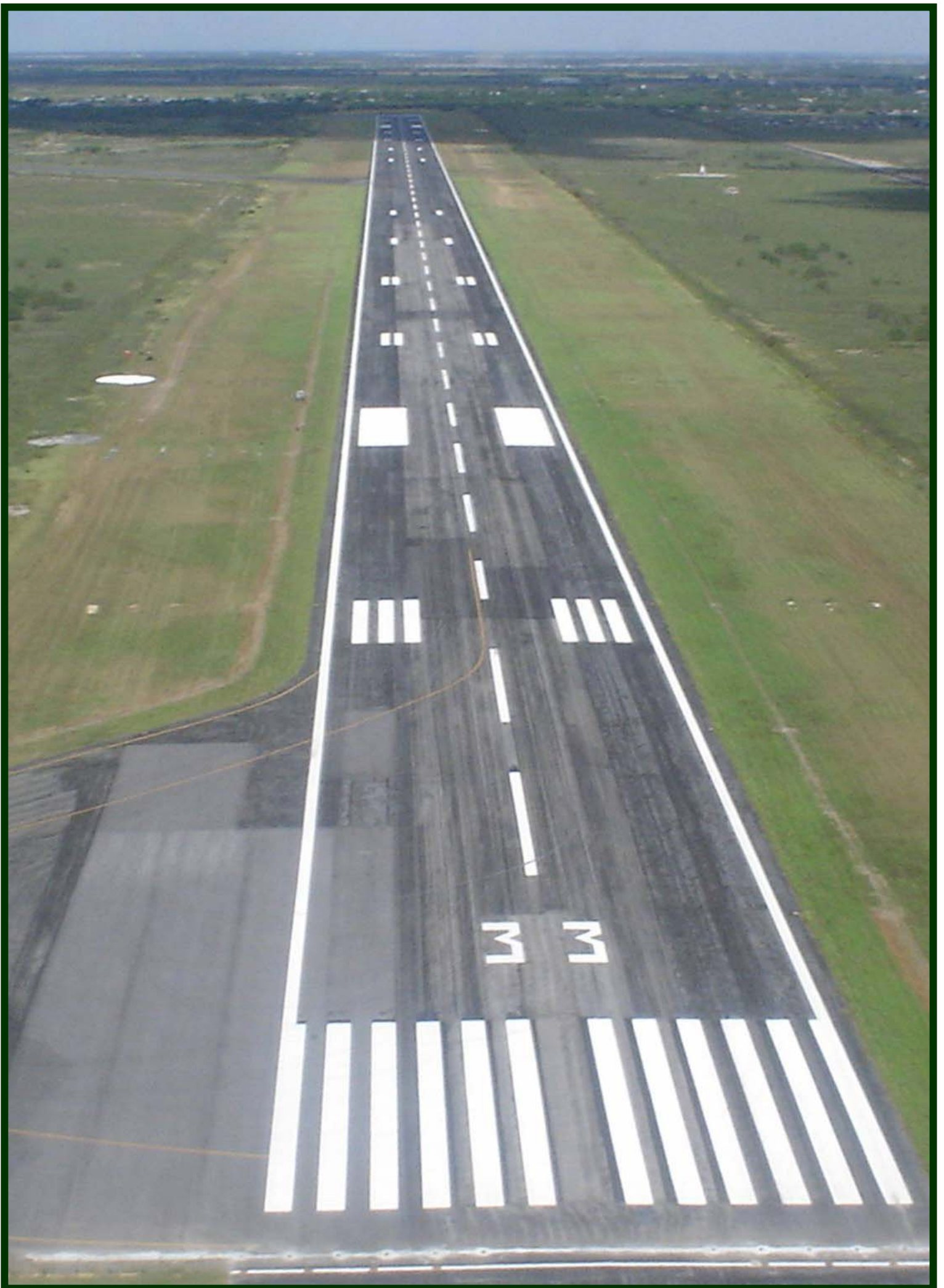
Aeropuerto de Matamoros, Tamaulipas. Corte y reposición de carpeta asfáltica en la pista y señalamiento horizontal.
