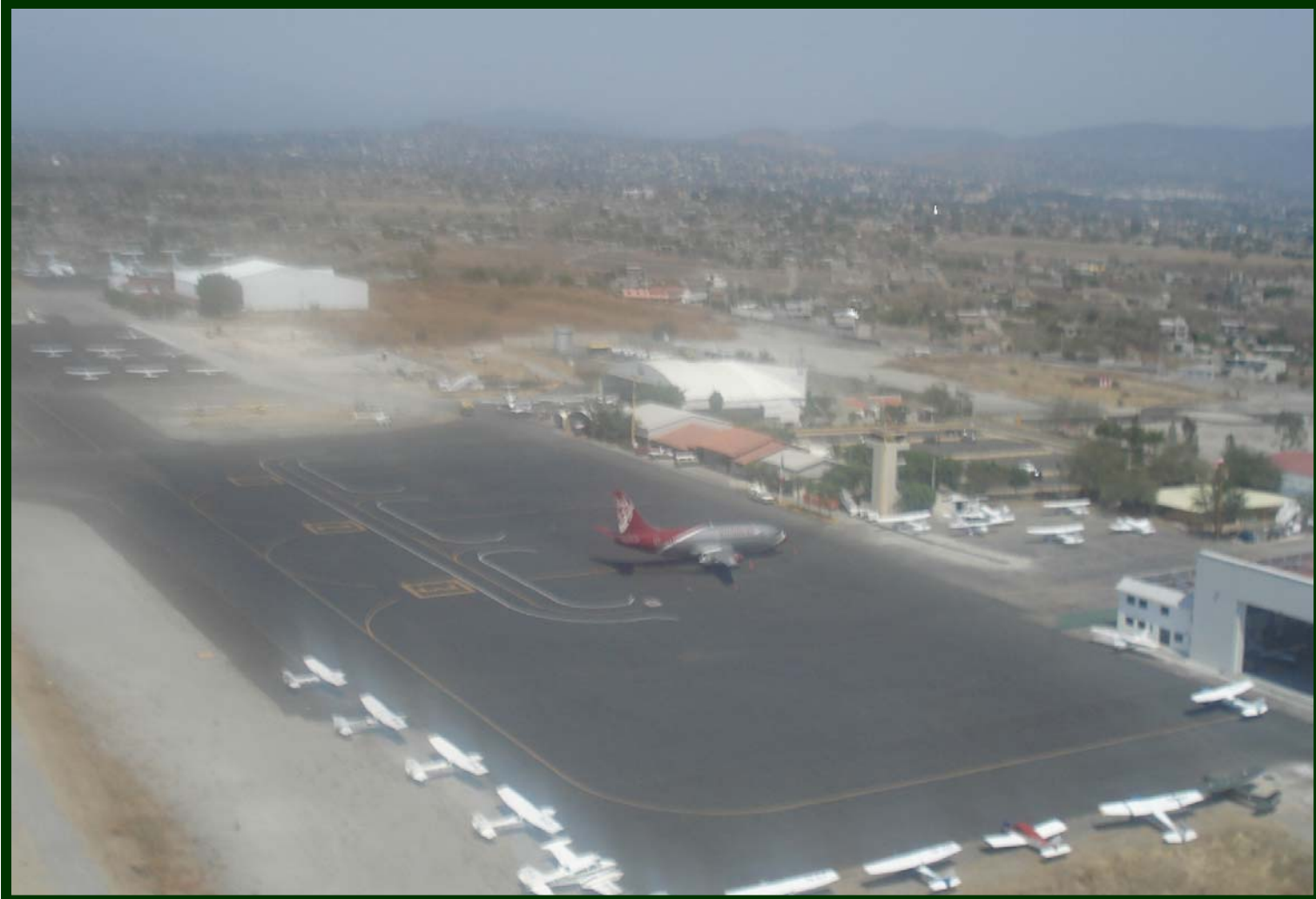
Aeropuerto de Uruapan, Michoacán. Ampliación y remodelación de edificio Terminal, 2ª etapa (arriba). Aeropuerto de Cuernavaca, Morelos. Reencarpetado de pista 02-20, rodaje Alfa, plataforma comercial y obras complementarias. (abajo)
