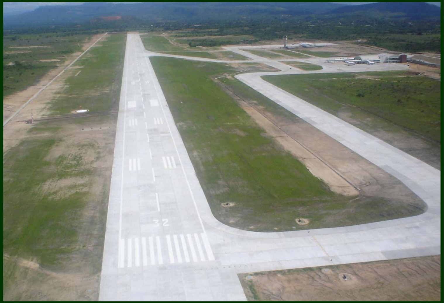
Aeropuerto Ángel Albino Corzo, Chiapas. Construcción de losas de concreto hidráulico en pista, plataforma, rodajes y caminos de servicios.
