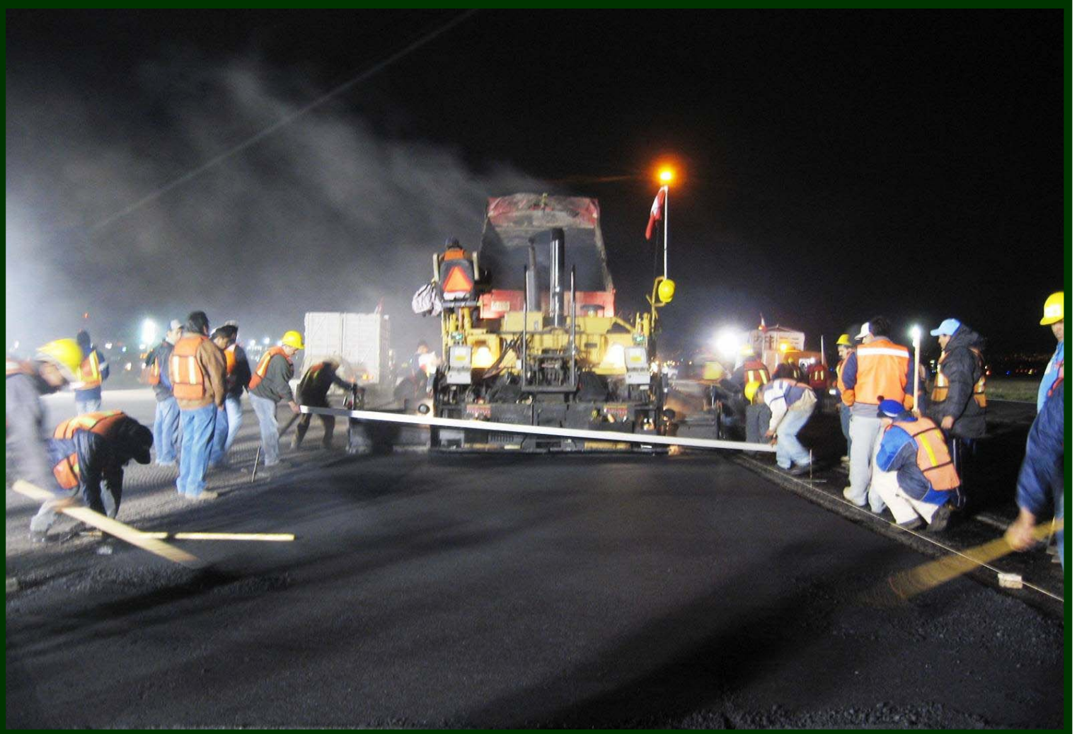
Aeropuerto Internacional de la Ciudad de México (AICM). Rehabilitación de la pista 05 Derecha /23 Izquierda y ampliación de acotamiento en la pista 05 Izquierda /23 Derecha.
