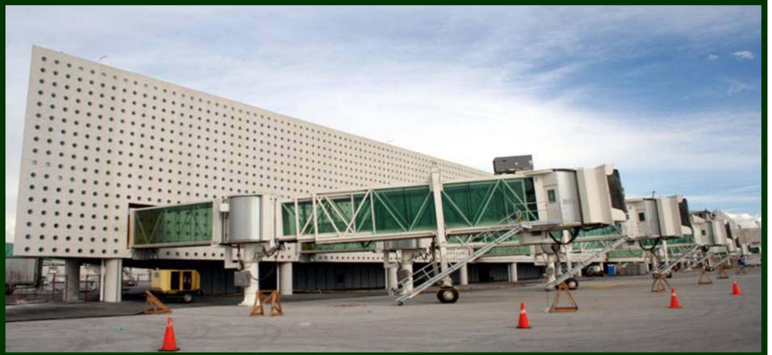
Aeropuerto Internacional de la Ciudad de México (AICM). Construcción de la Terminal 2, Dedo Norte (arriba), terracerías y pavimentos de concreto hidráulico en plataforma de aviación comercial (centro) y Dedo Sur (abajo).
