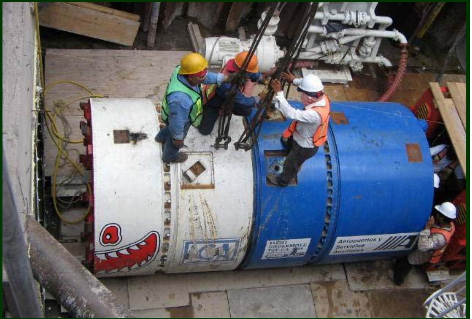
Aeropuerto Internacional de la Ciudad de México (AICM). Construcción de colector de drenaje profundo en plataforma de aviación comercial para la T2 (arriba). Construcción del drenaje pluvial para mitigar efectos de inundaciones (abajo).
