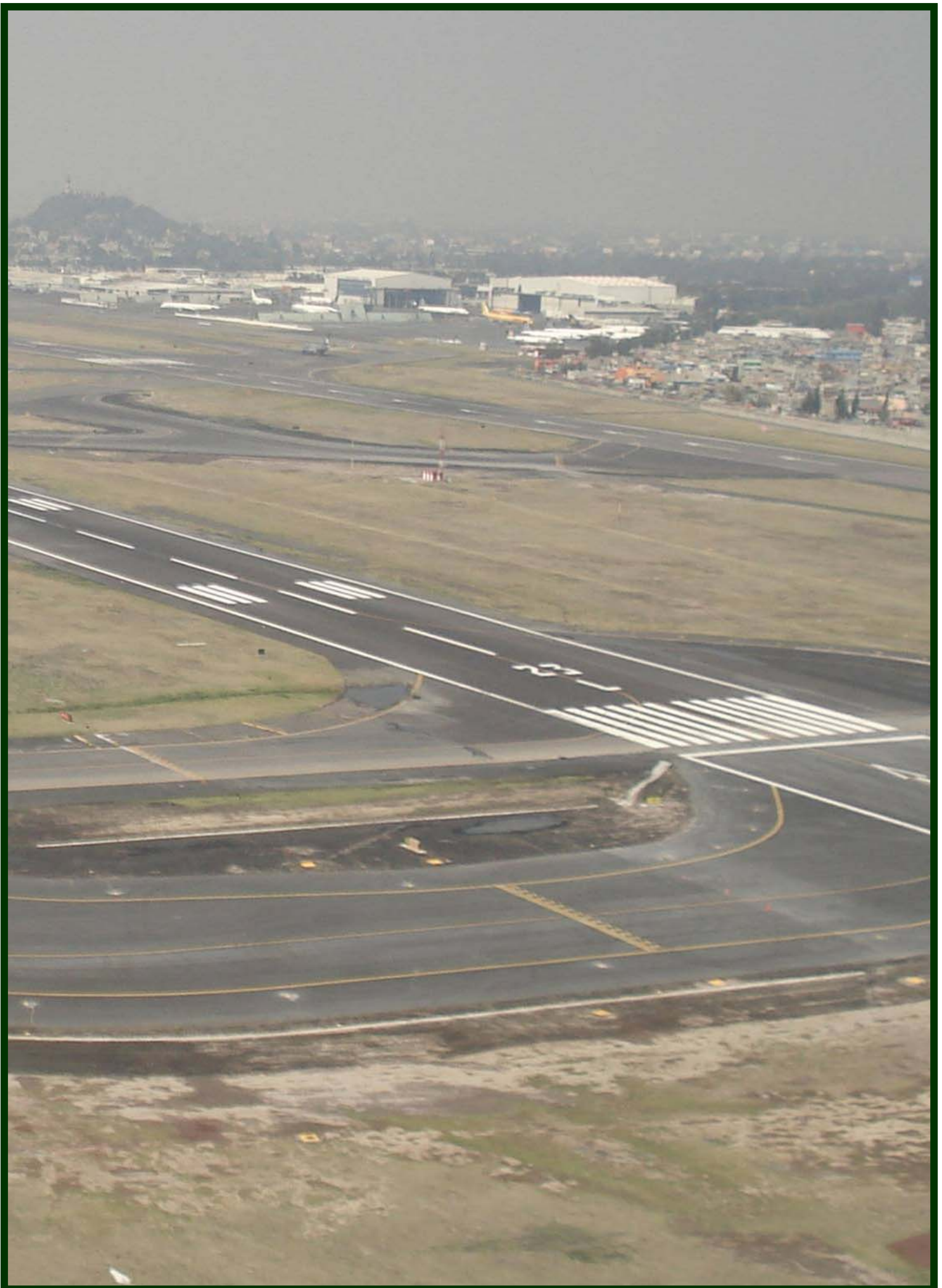
Aeropuerto Internacional de la Ciudad de México (AICM). Rehabilitación de pista 05 Derecha /23 Izquierda.
