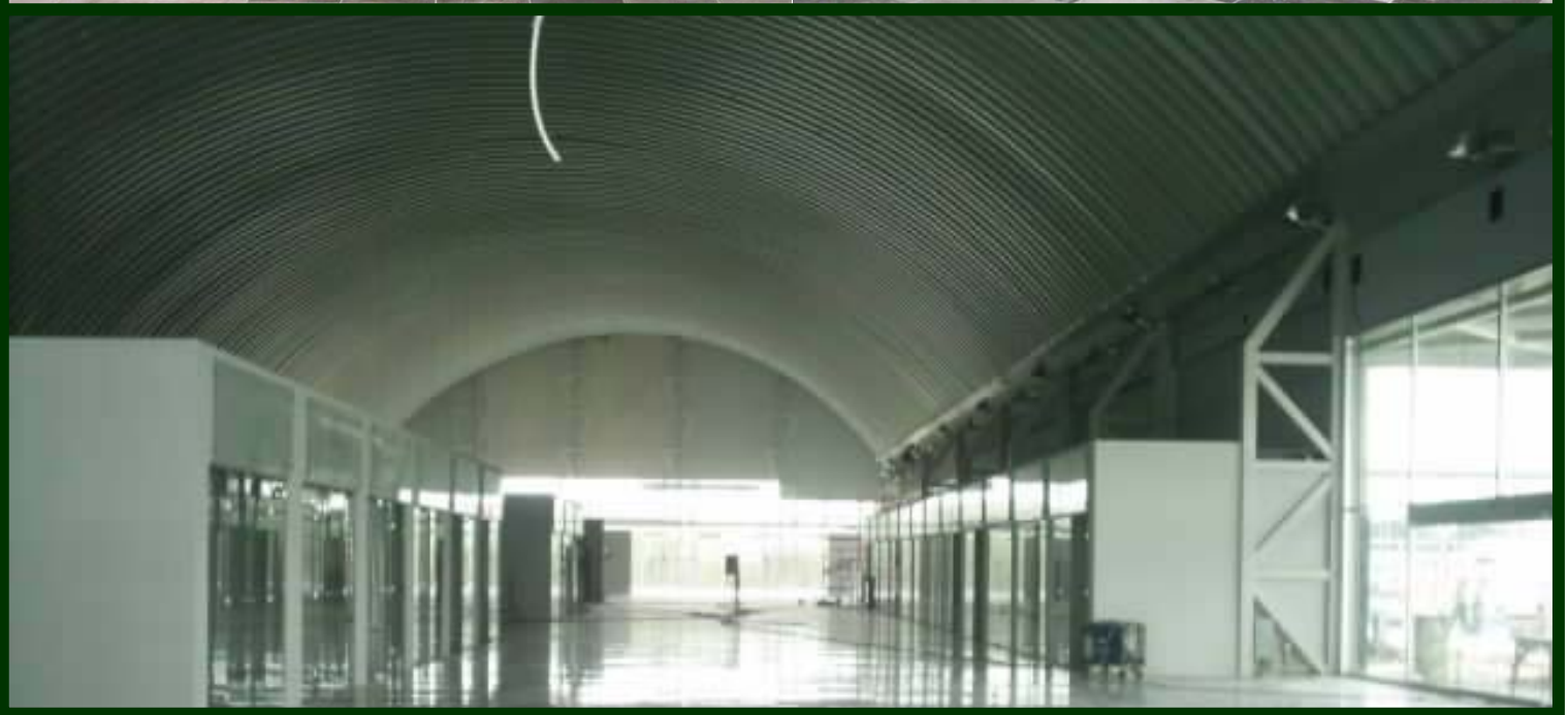
Aeropuerto de Toluca, Estado de México. Construcción del edificio de autoridades aeronáuticas. Ampliación y remodelación del edificio de pasajeros, 2da etapa.
