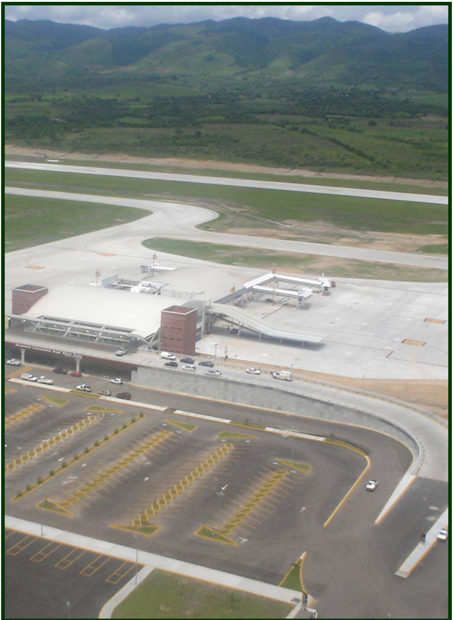
Aeropuerto Ángel Albino Corzo, Chiapas. Construcción de vialidades exteriores, vialidades de acceso, estacionamiento público y obras complementarias.
