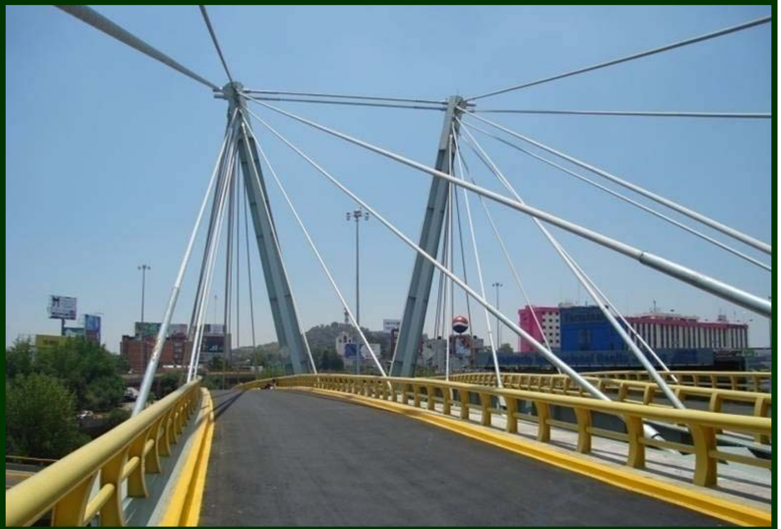
Aeropuerto Internacional de la Ciudad de México (AICM). Construcción del distribuidor vial 1 (2 a etapa), consistente en dos puentes atirantados.
