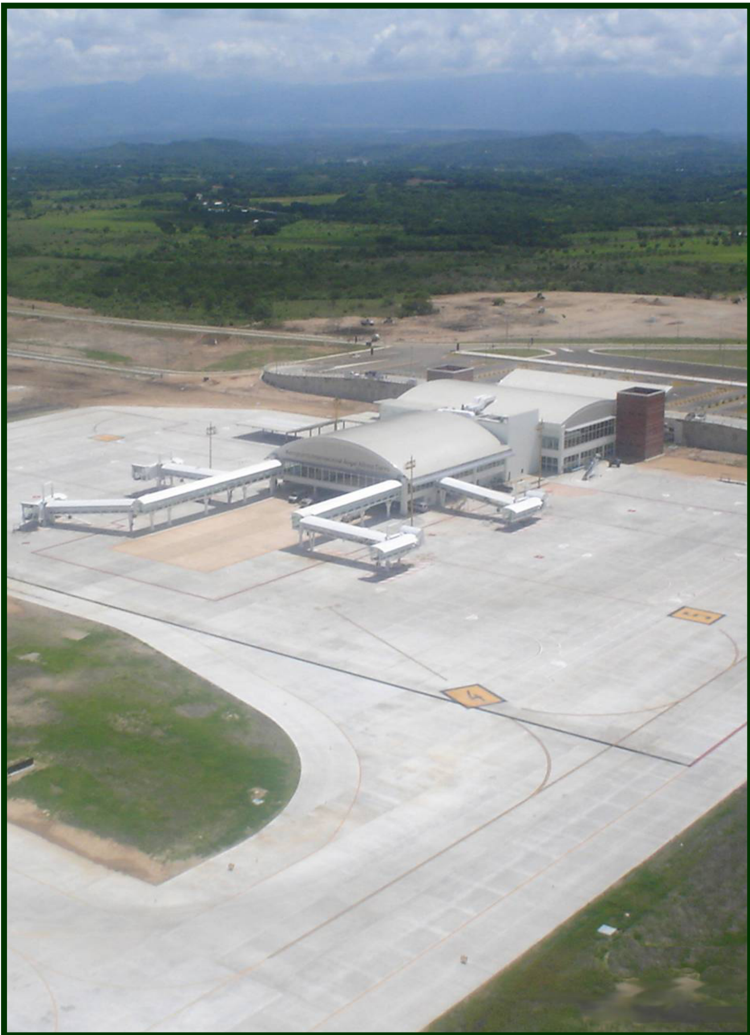
Aeropuerto Ángel Albino Corzo, Chiapas. Construcción de plataforma para instalaciones de la estación de combustibles y obras complementarias. (parte superior derecha)
