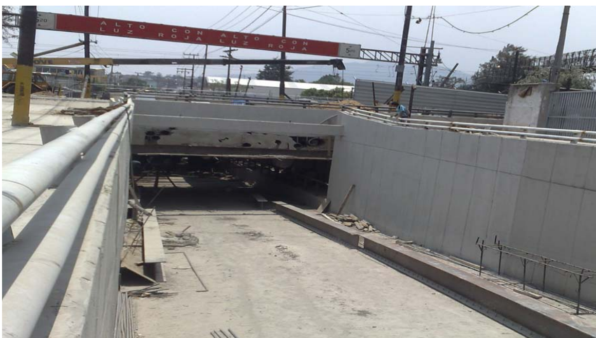
Construcción del puente vehicular deprimido "11 de Julio", Estado de México. (Tren Suburbano)
