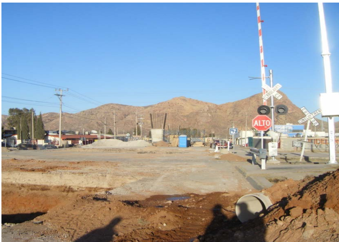
Paso a desnivel de ferrocarril en Avenida “Los Nogales” con la Avenida Venceremos, Chihuahua, Chihuahua. (Programa de Seguridad Ferroviaria)
