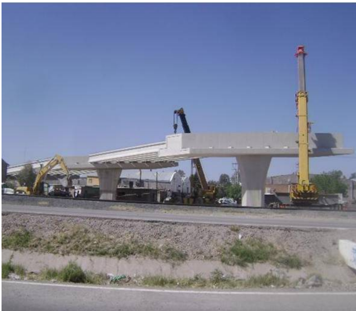
Construcción del paso superior vehicular en el cruce con las vías férreas kilómetro A-1514+740 en el municipio de Delicias, Chihuahua. (Programa de Seguridad Ferroviaria)
