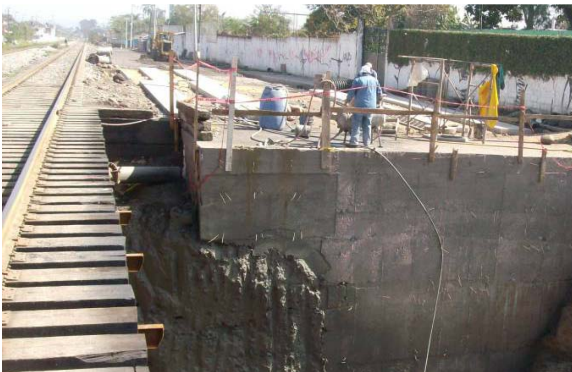
Kilómetro S-293+577, corredor Teotihuacán-Veracruz de la línea "S" del tramo Encinar-Veracruz, calle sur 21, Orizaba, Veracruz, trabajos de construcción de muro vista norte-sur en el sentido de la vía.
