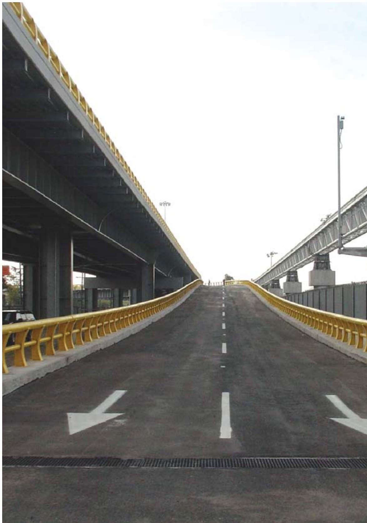
Aeropuerto Internacional Benito Juárez de la Ciudad de México (AICM). Construcción del Distribuidor Vial D2 y la vialidad a desnivel sobre Calle 47 y Economía de Viaducto Río de la Piedad a Eje 1 Norte para la Nueva T2
