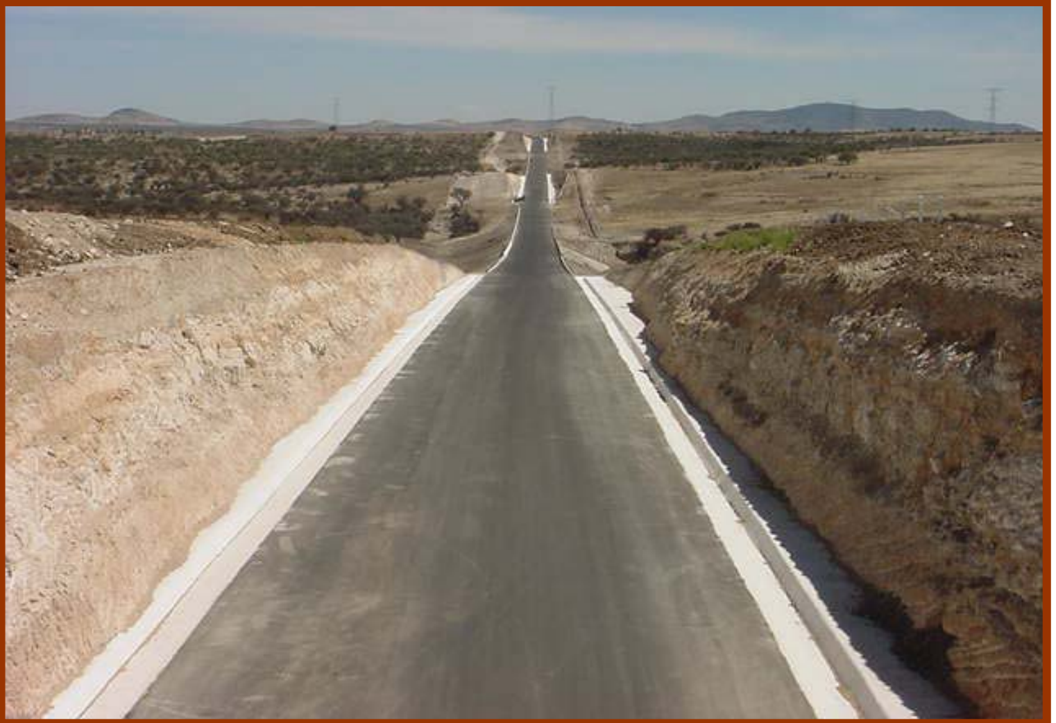
Libramiento de Aguascalientes, Ags.
