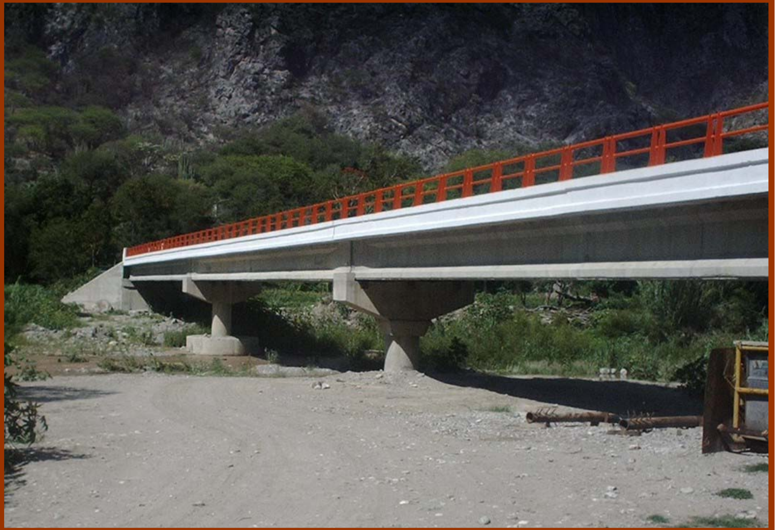
Puente San Pablo Tetlapayac, Hgo.
