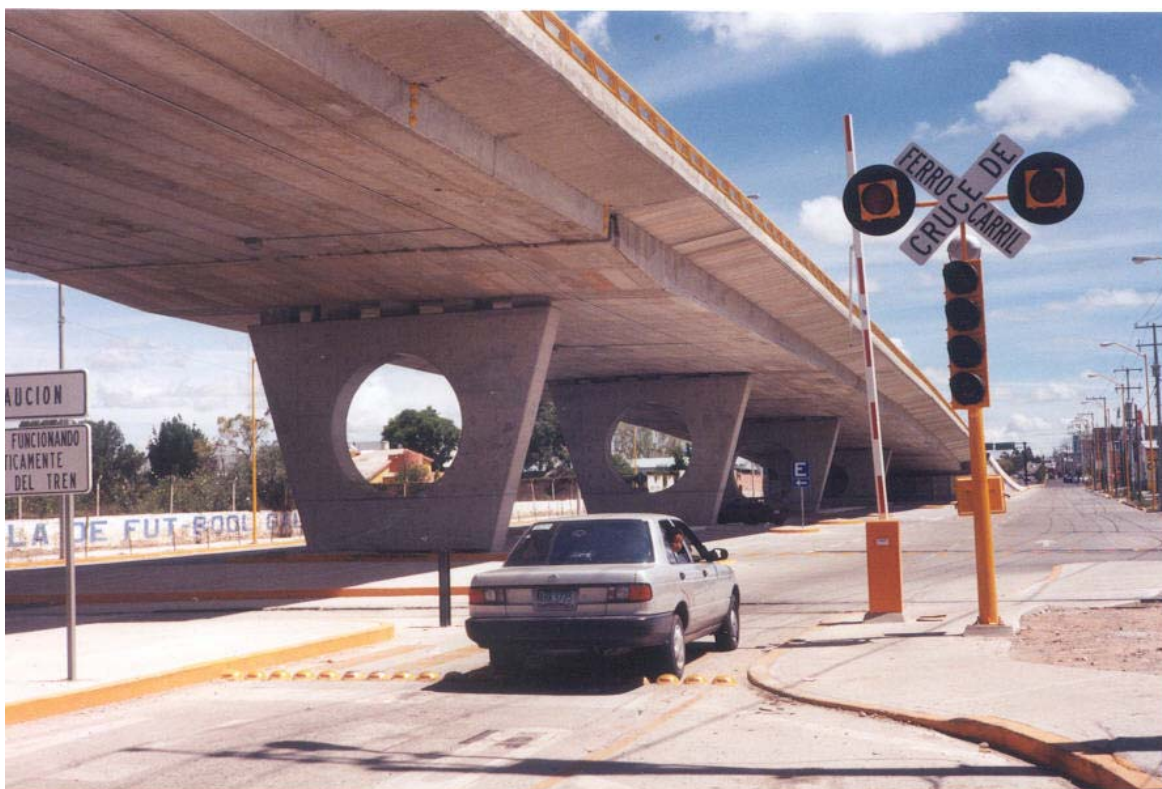
Paso a desnivel superior en Av. Aguascalientes en Aguascalientes, Ags.
