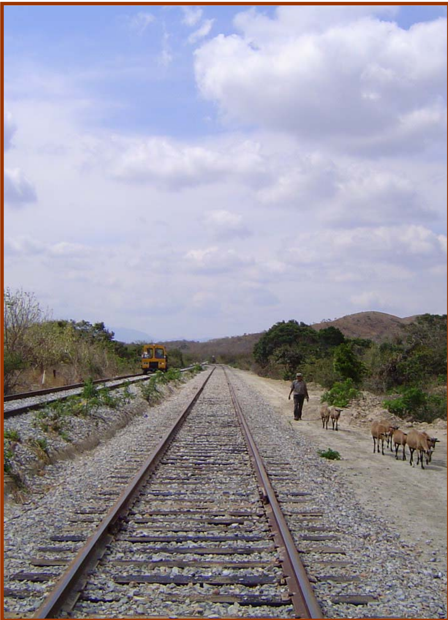
Ladero "Nizanda" en el km 237+600 en Oaxaca. Ferrocarril del Istmo de Tehuantepec (FIT)
