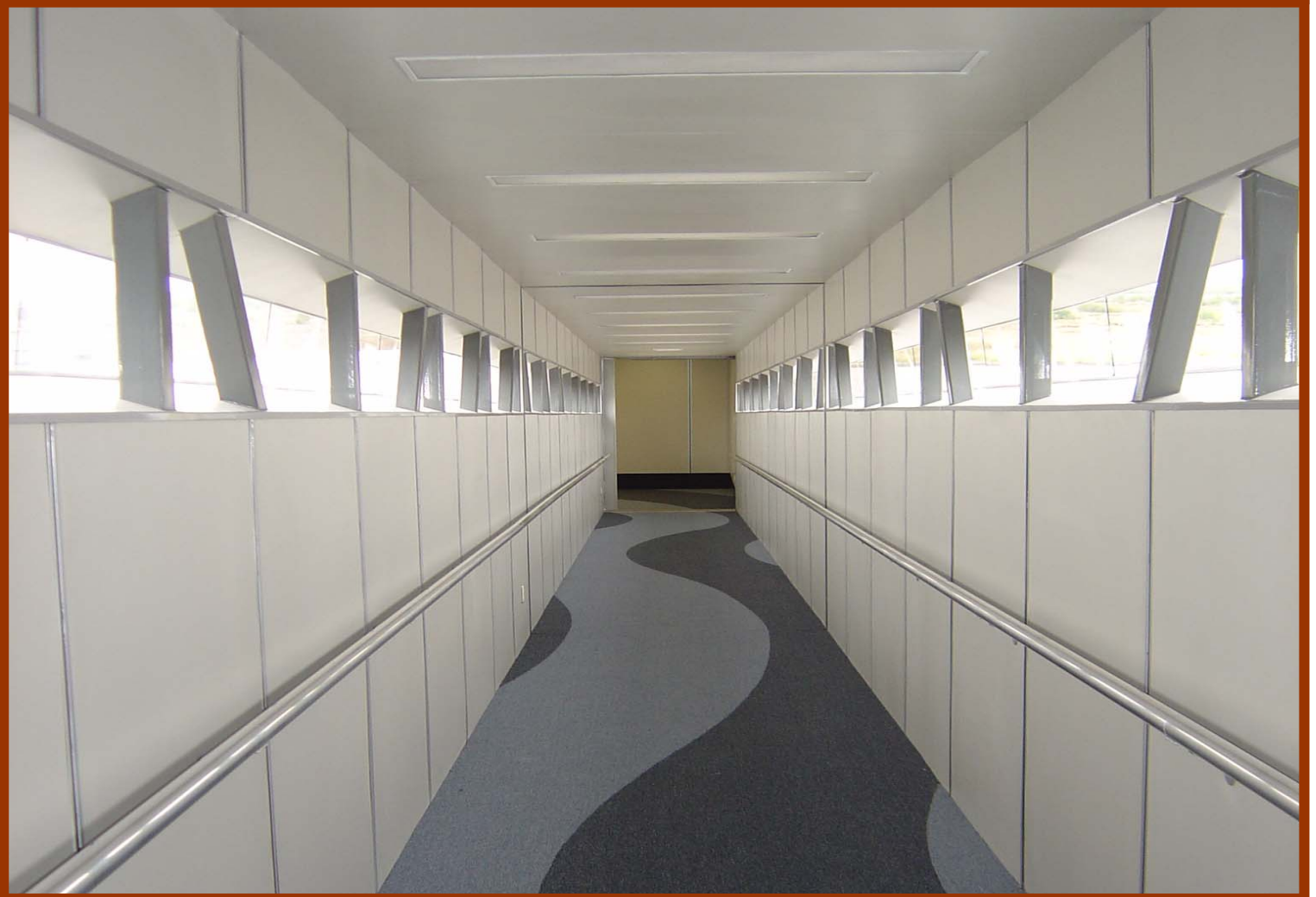
Instalación de aeropasillos, Ciudad Obregón, Son.
