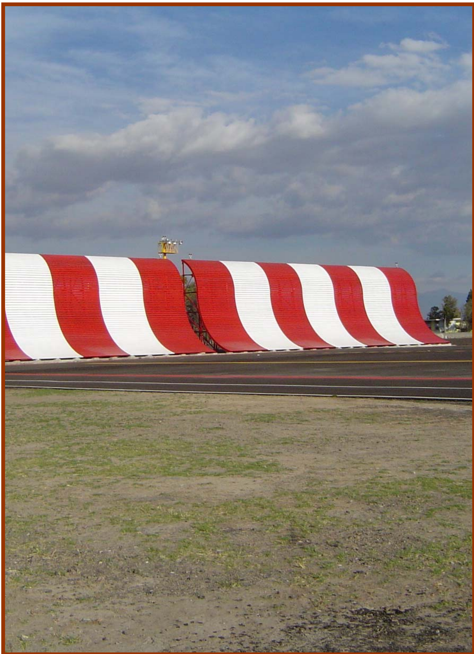
Plataforma para corrido de motores, Aeropuerto Internacional de la Ciudad de México (AICM)
