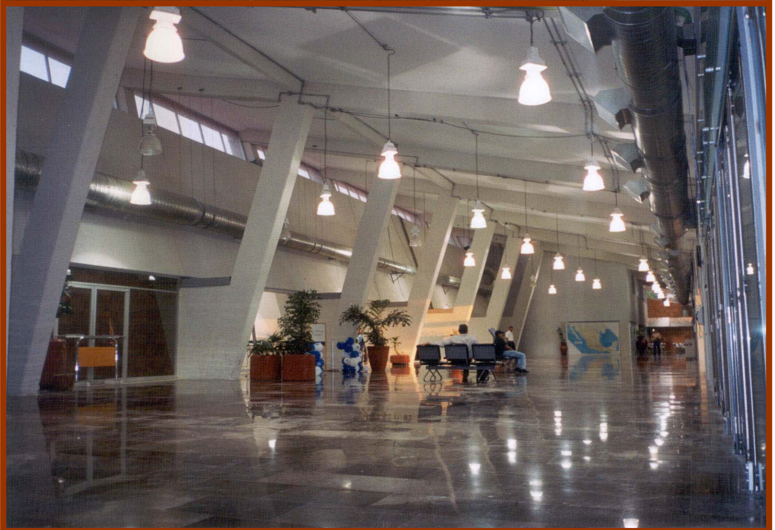
Tercera etapa de ampliación y remodelación (fachada y ambulatorio) del aeropuerto de Cd. del Carmen, Cam.
