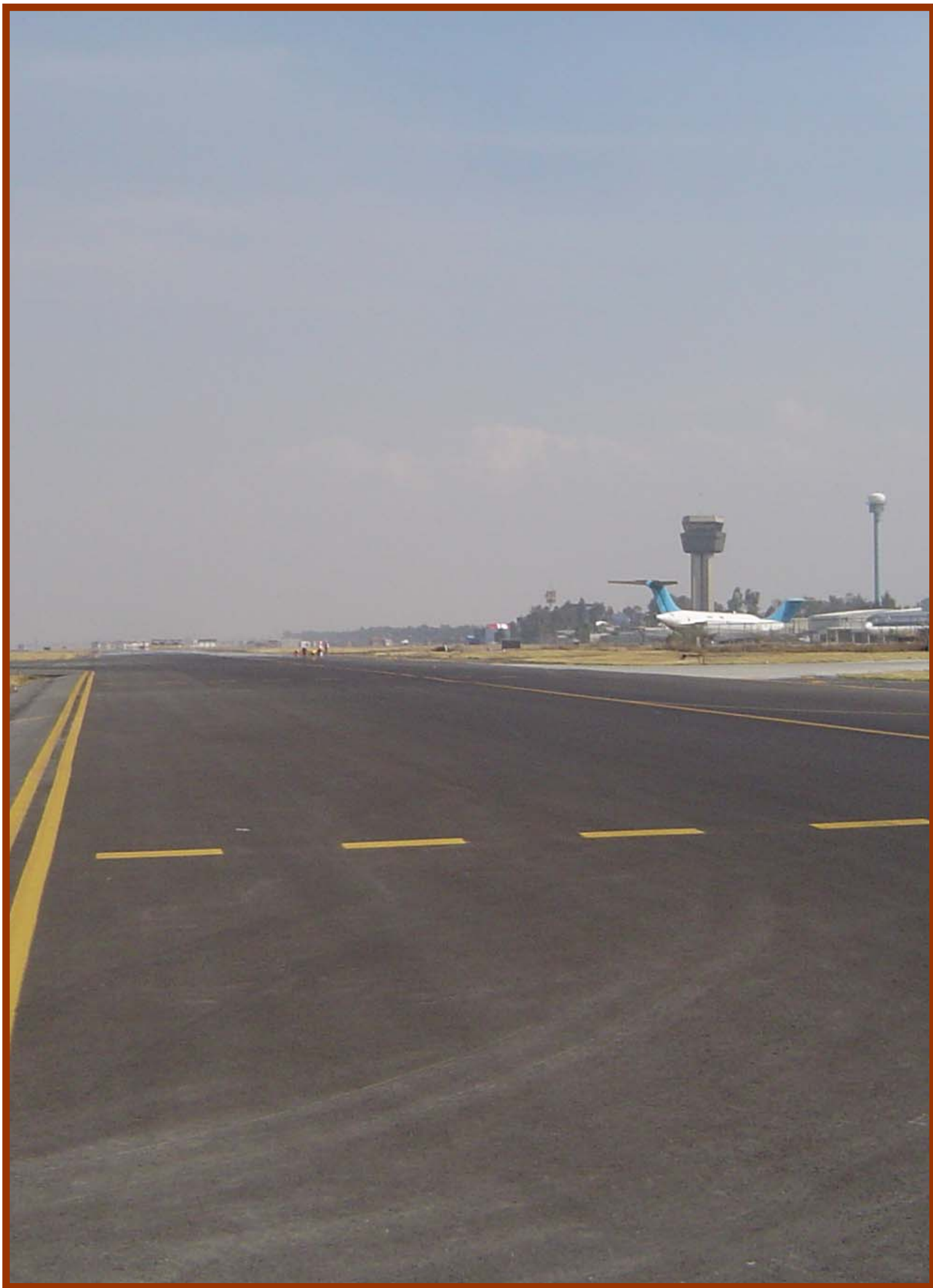
Rehabilitación del rodaje eco, Aeropuerto Internacional de la Ciudad de México (AICM)
