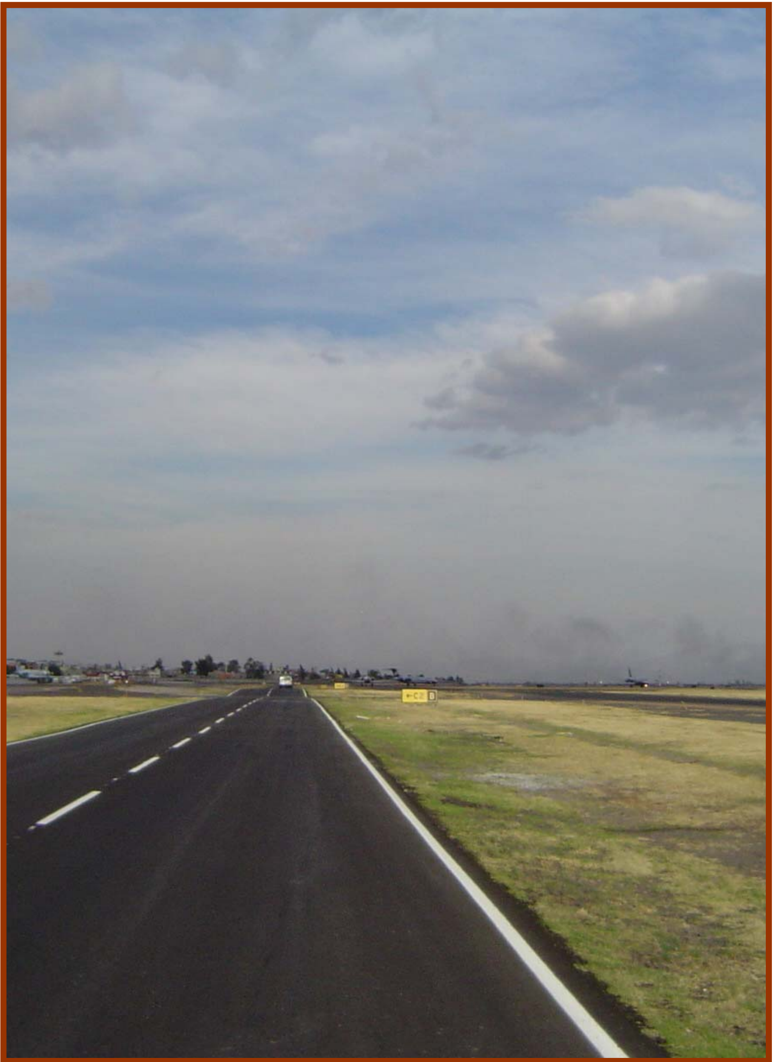
Rehabilitación de camino perimetral, Aeropuerto Internacional de la Ciudad de México (AICM)
