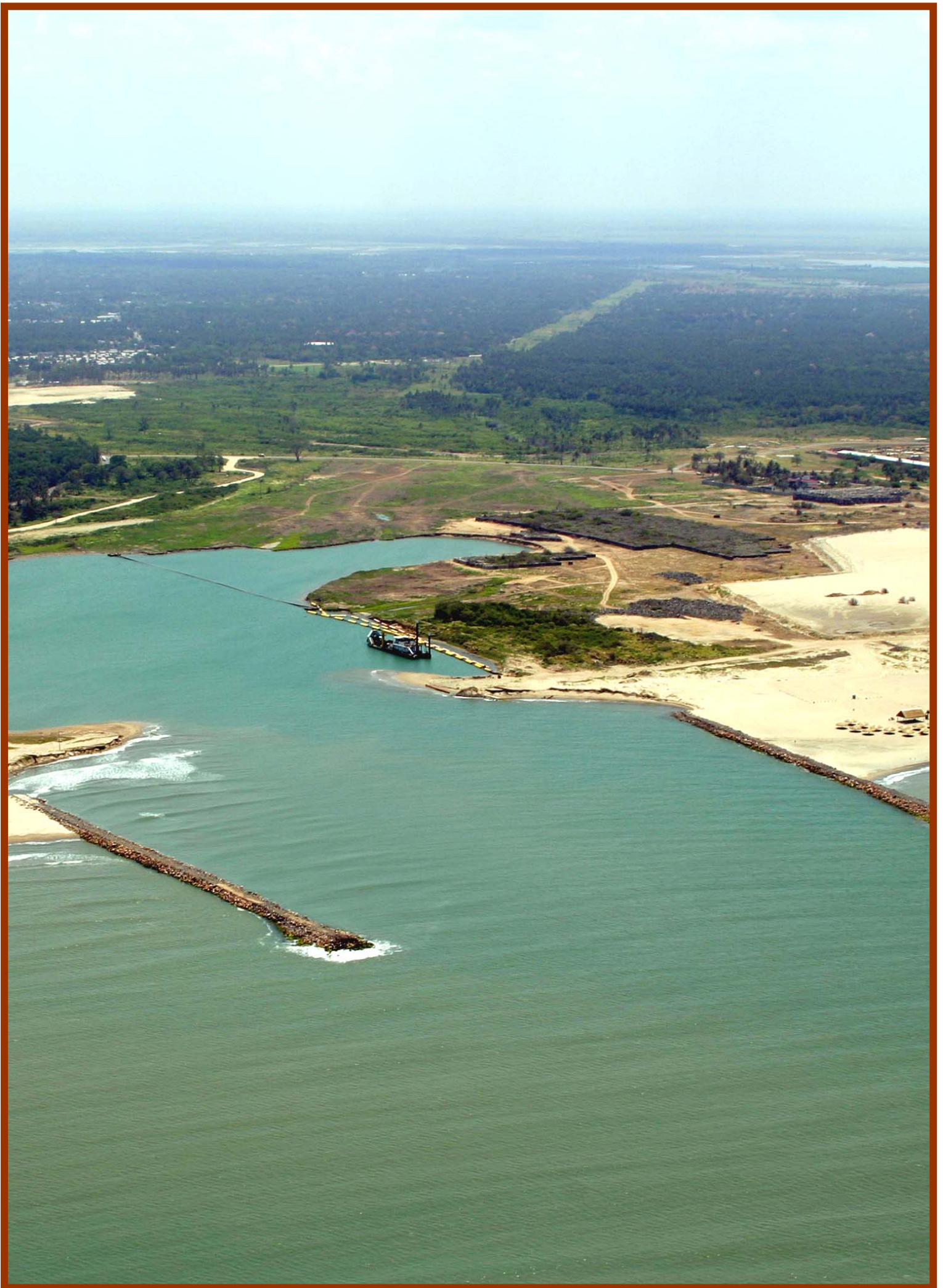
Dragado en canal de acceso y dársena en Dos Bocas, Tab.
