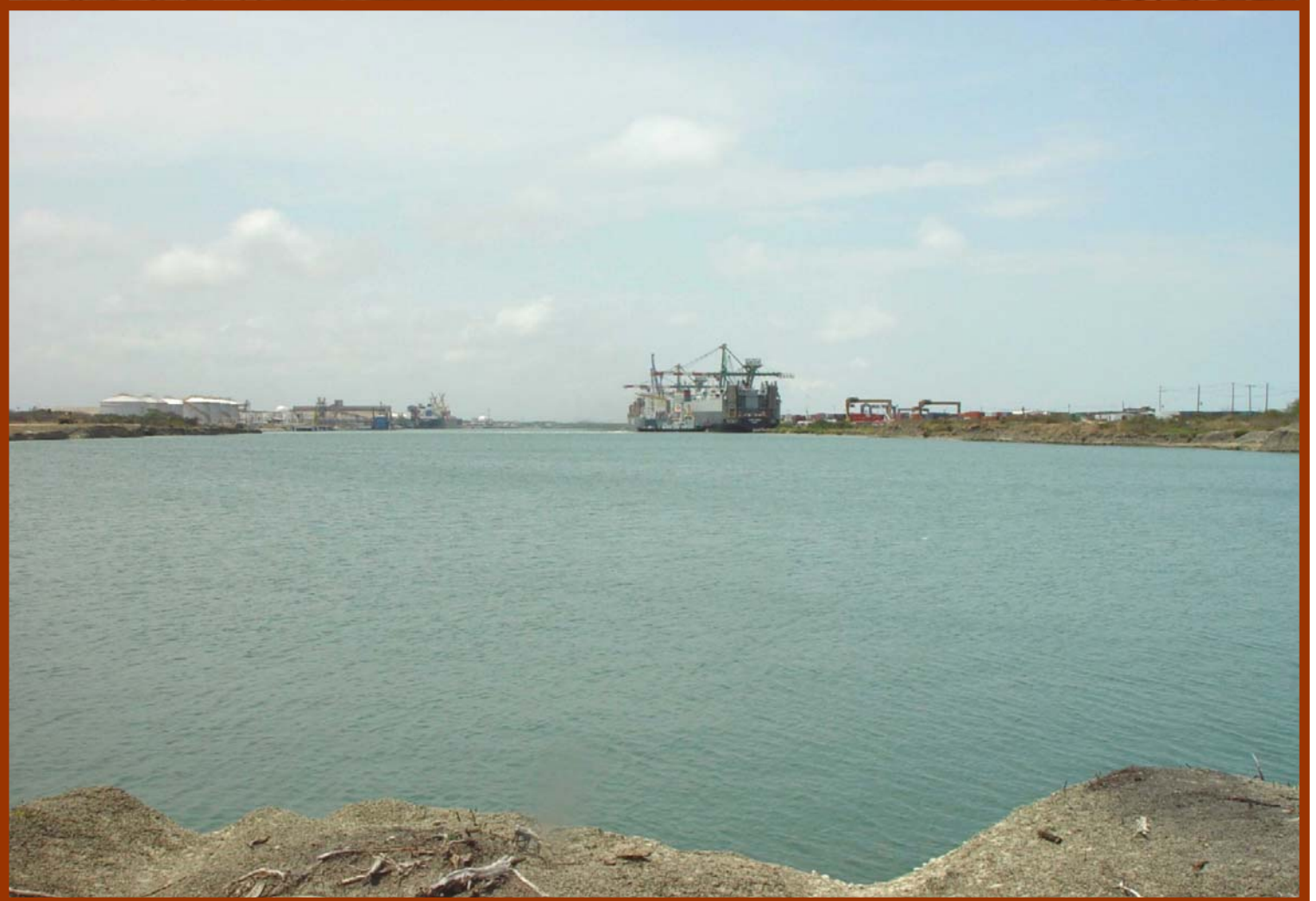
Dragado en canal de acceso y dársena en Altamira, Tamps.
