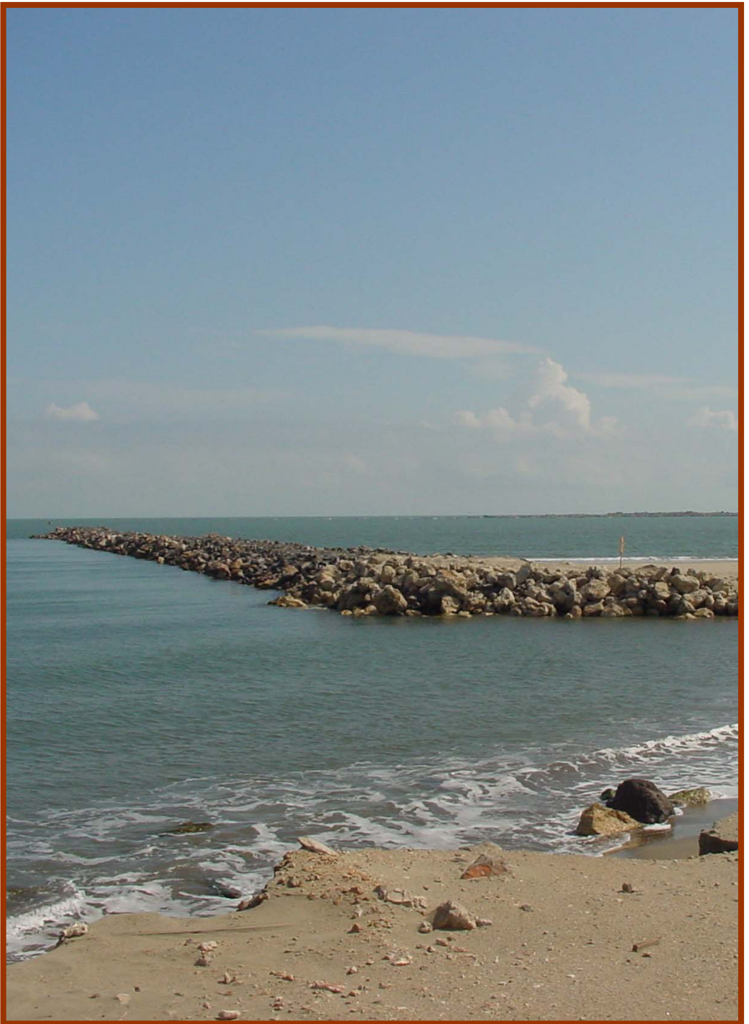
Construcción de espigones de protección en Dos Bocas, Tab.
