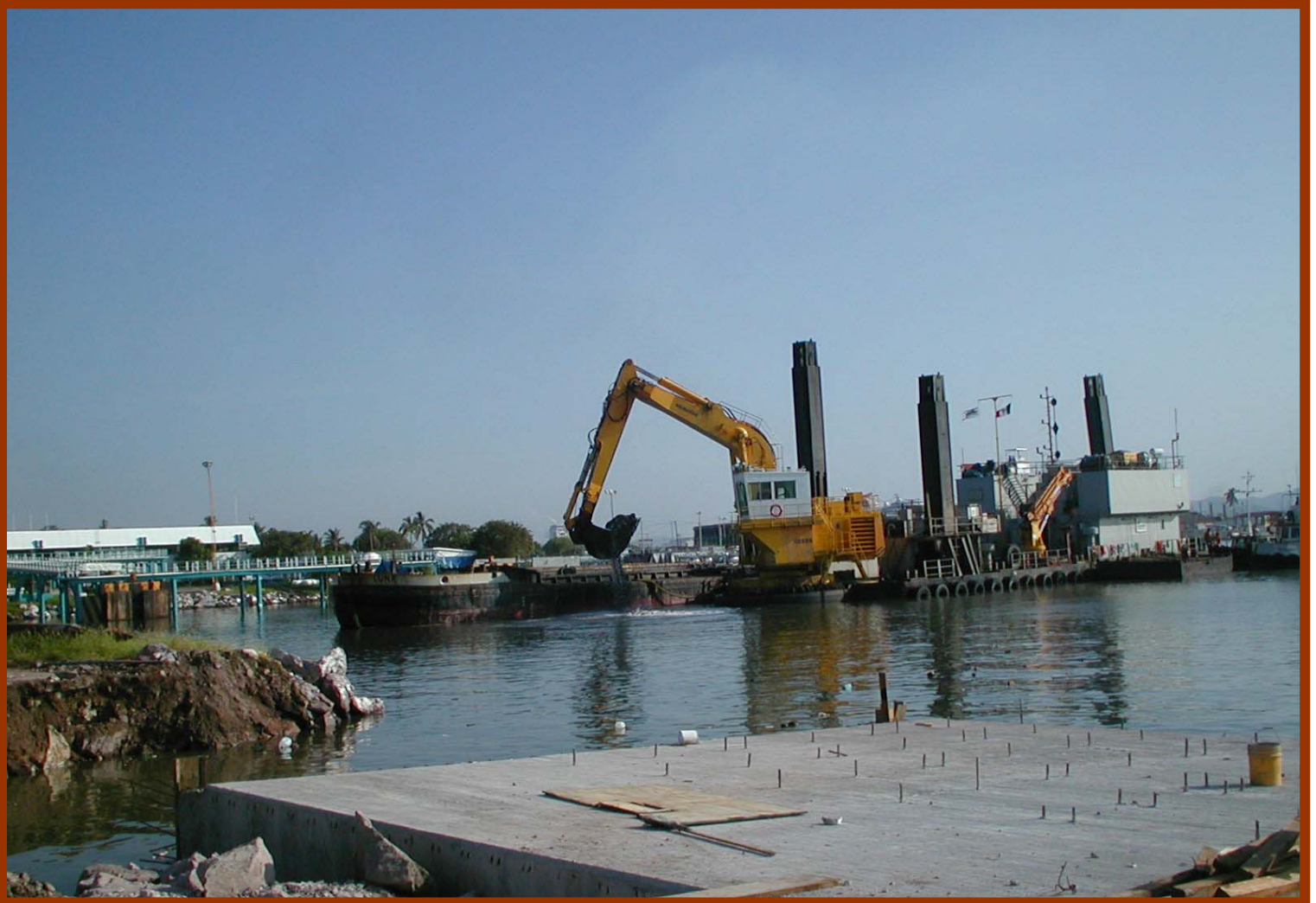
Dragado en dársenas, canal y paramentos en Mazatlán, Sin.
