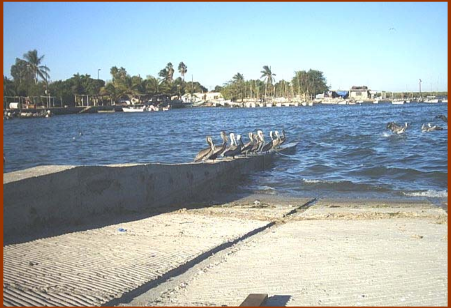
Construcción de rampa de botado en Yávaros, Son.
