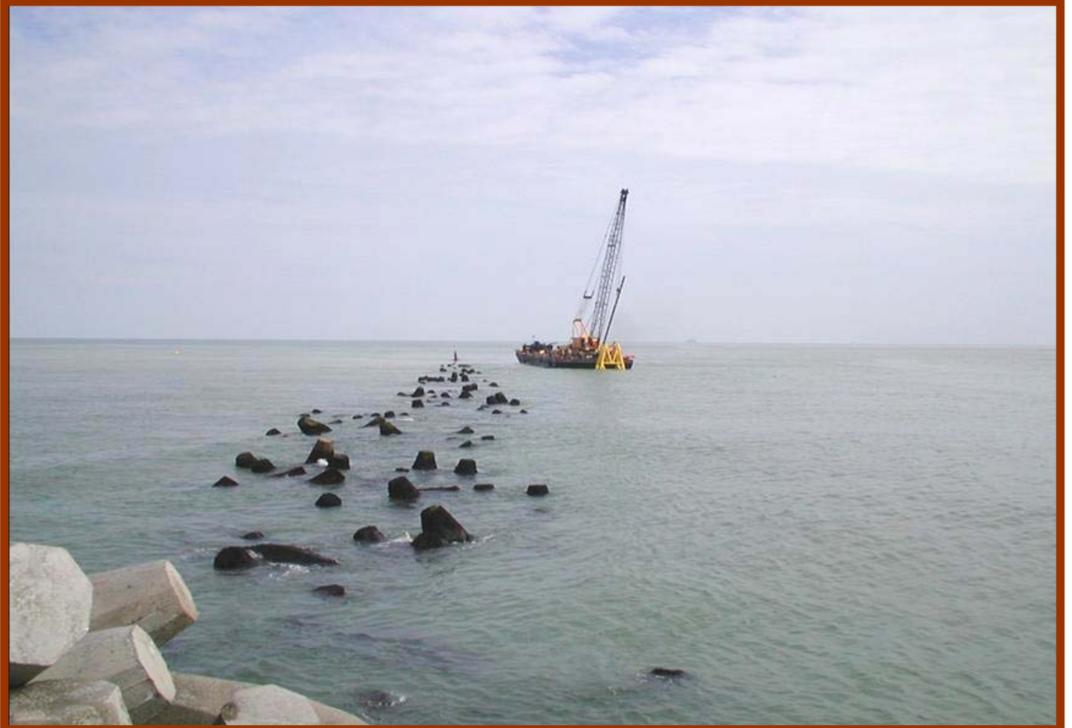
Construcción de estructura para señalamiento marítimo en Tuxpan, Ver.
