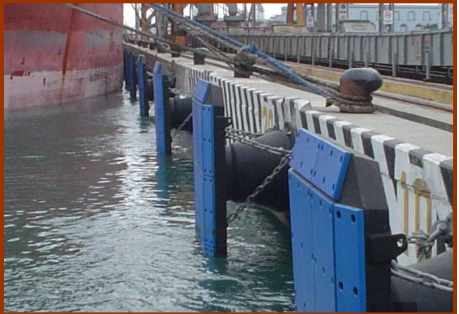
Colocación de defensas en muelles en Veracruz, Ver.
