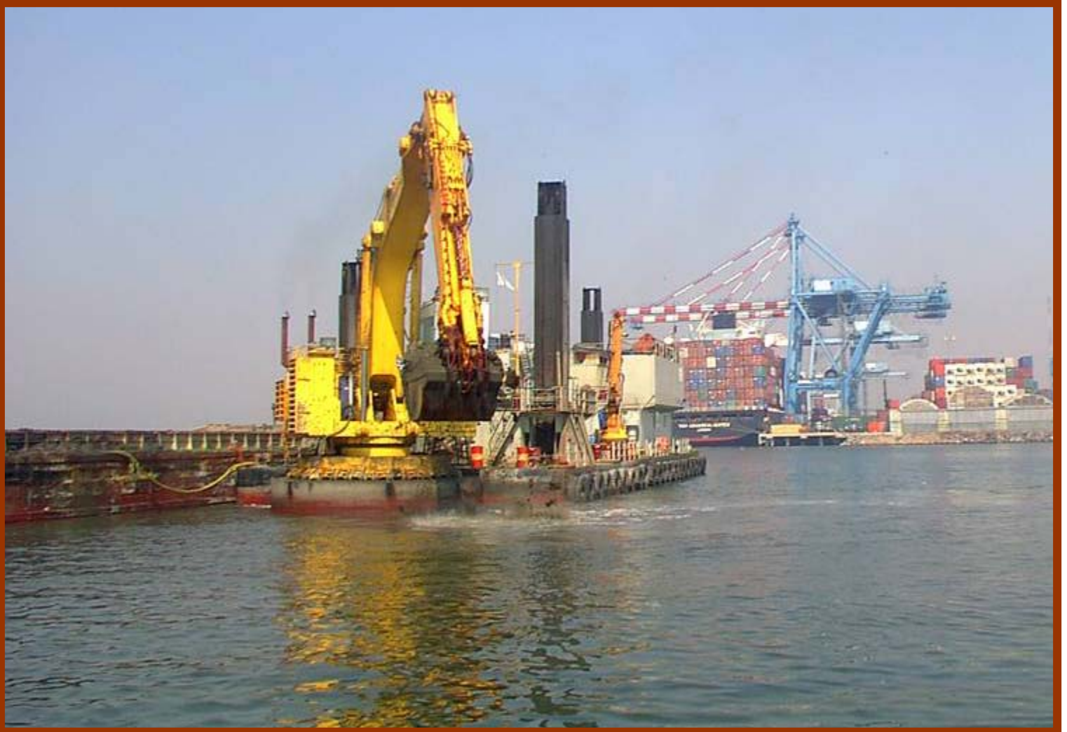
Dragado en canales y dársenas en Manzanillo, Col.
