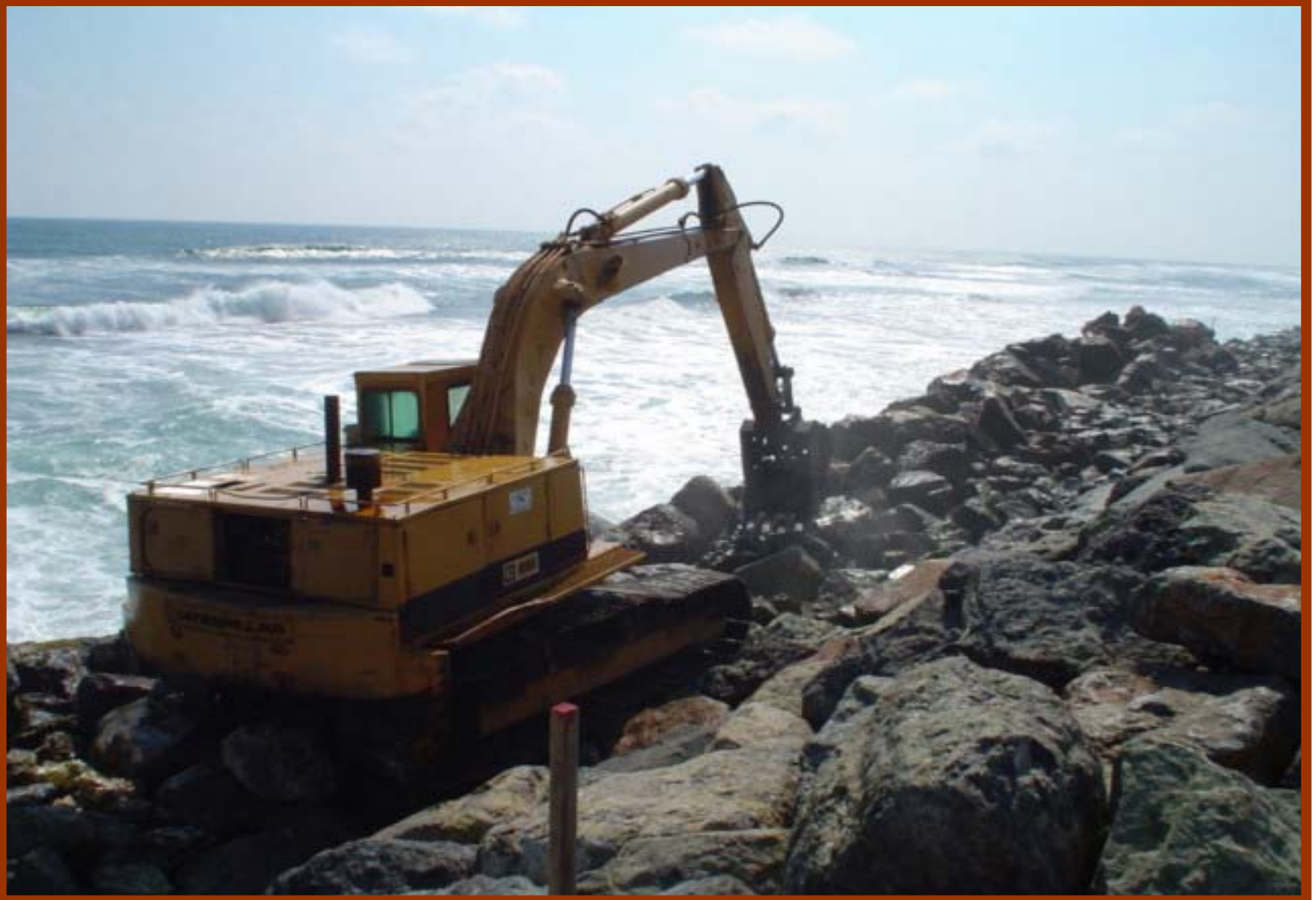
Reparación y construcción de protección marginal en Lázaro Cárdenas, Mich.
