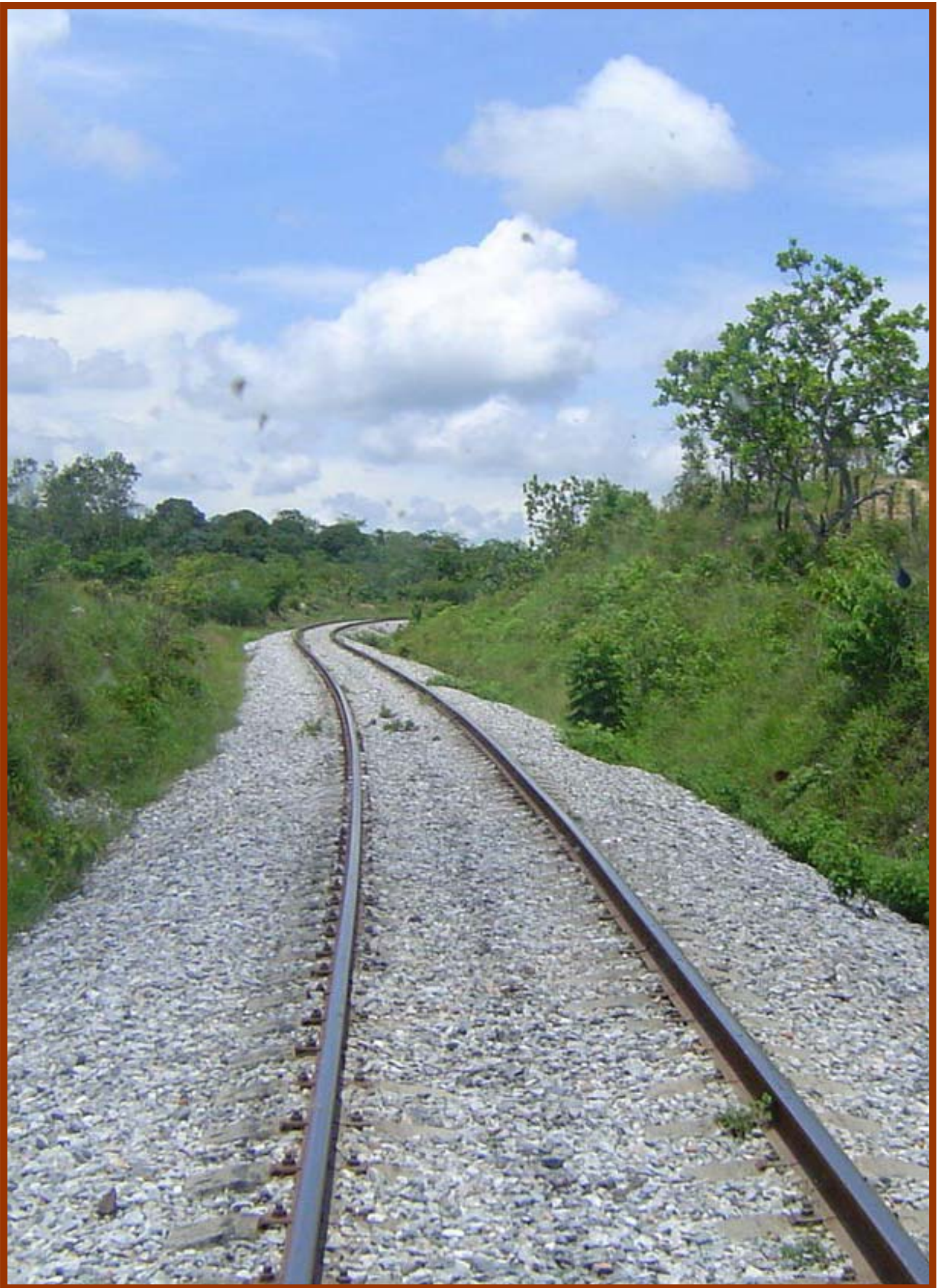
Vía férrea en el km-173+000, Matías Romero, Oax. Ferrocarril del Istmo de Tehuantepec
