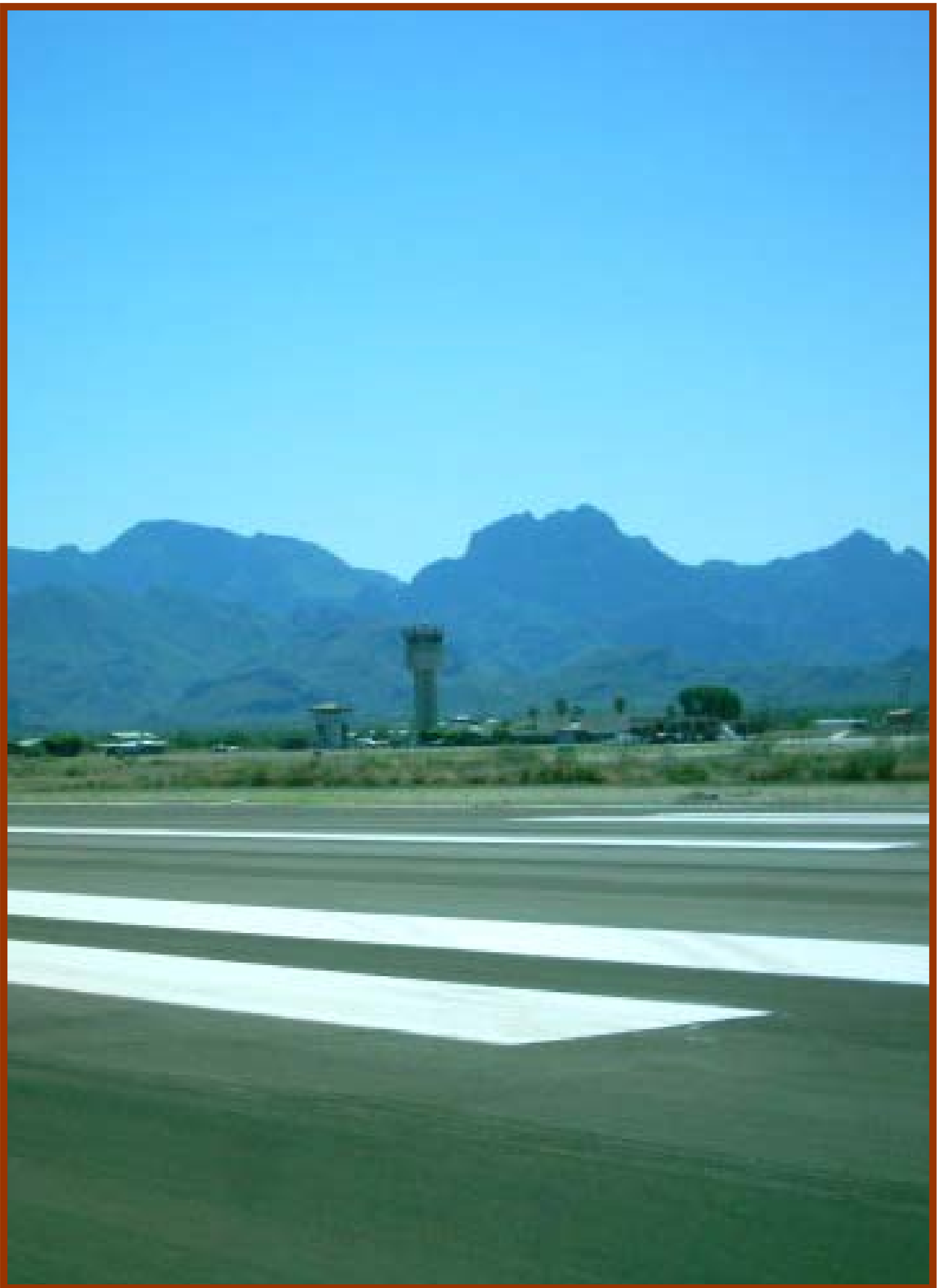
Mortero asfáltico en pista 16–34 y rodajes, bacheo superficial en plataformas y aplicación de sello de protección, Aeropuerto de Loreto, B.C.S.
