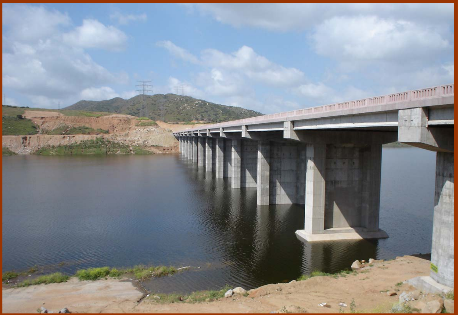
Puente Abelardo L. Rodríguez, B.C.
