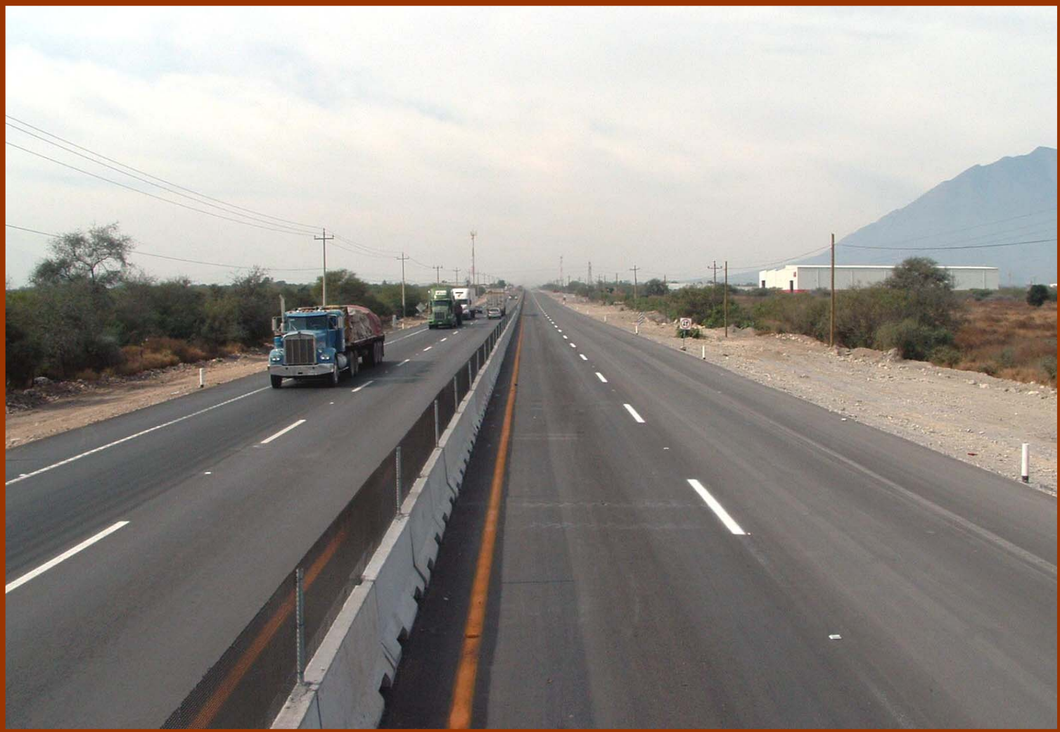
Libramiento Noroeste de Monterrey, N.L.
