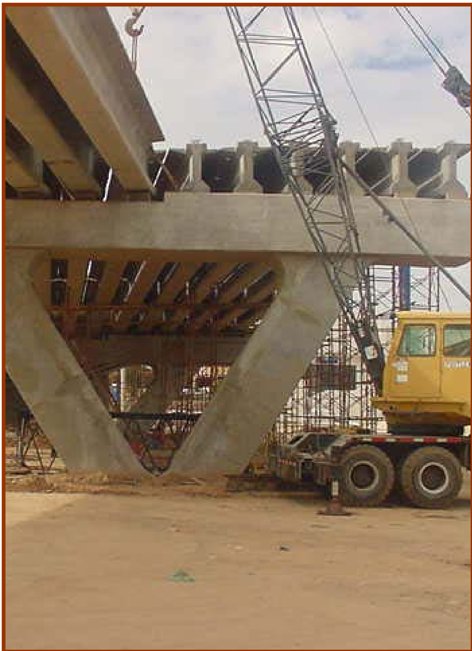
Construcción del paso a desnivel superior "El Greco" en Nogales, Son.
