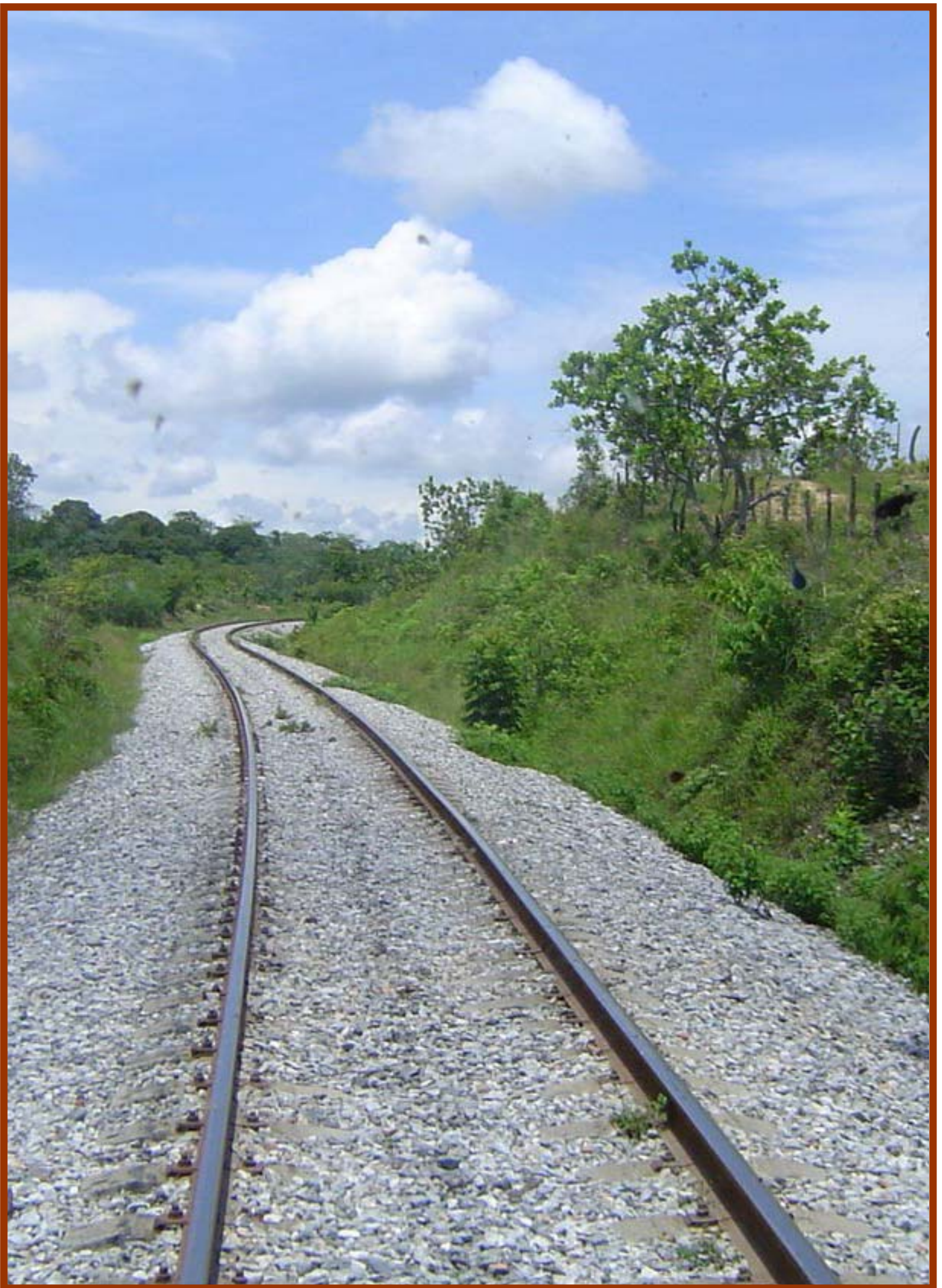
Vía férrea en el km Z-173+000, Matías Romero en Oaxaca. Ferrocarril del Istmo de Tehuantepec (FIT)
