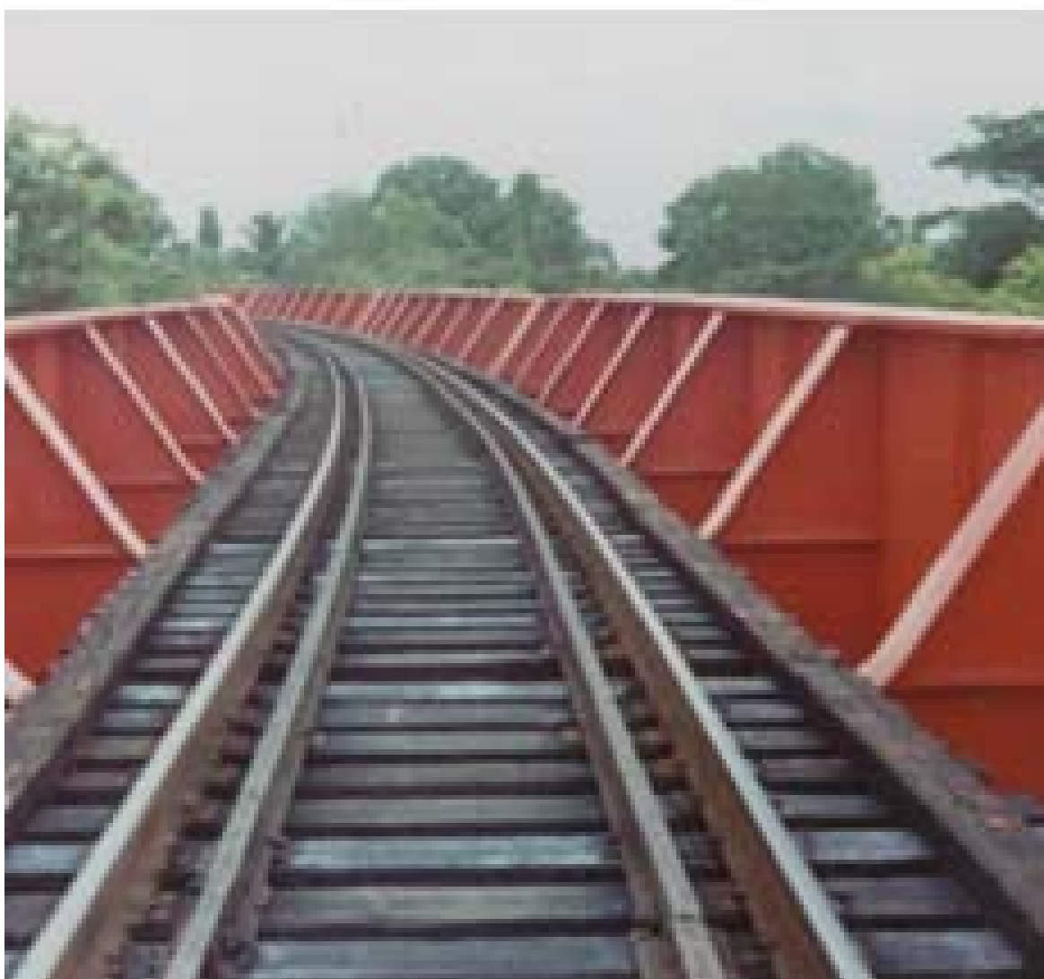
Trabajos de protección anticorrosiva en el puente Km Z-127+670, Jesús Carranza, Ver. Ferrocarril del Istmo de Tehuantepec. (FIT)
