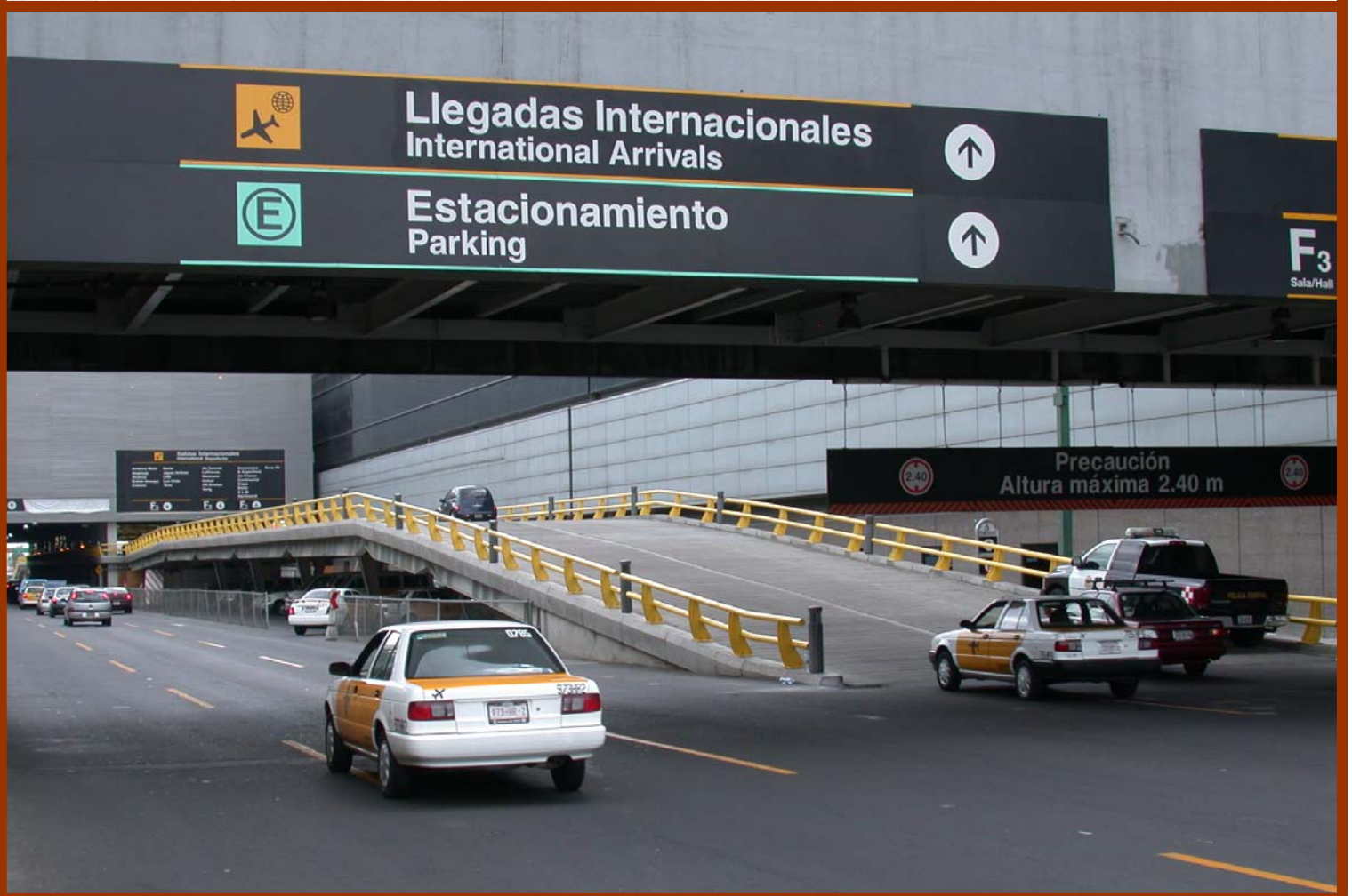
Acceso y señalización de las salas F1, F2, F3 y construcción de puente vehicular, Aeropuerto Internacional de la Ciudad de México (AICM)
