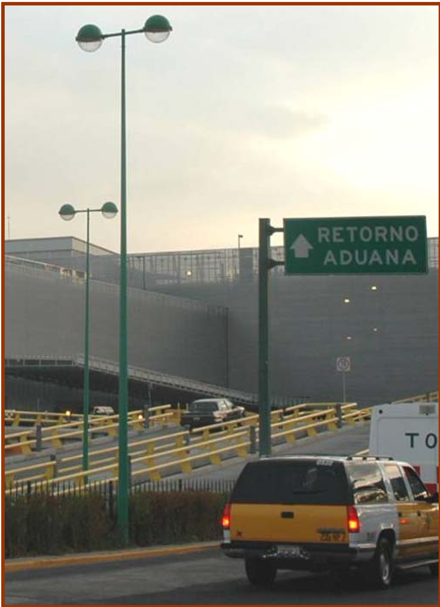
Rampa de acceso al estacionamiento del Área Internacional, Aeropuerto Internacional de la Ciudad de México (AICM)
