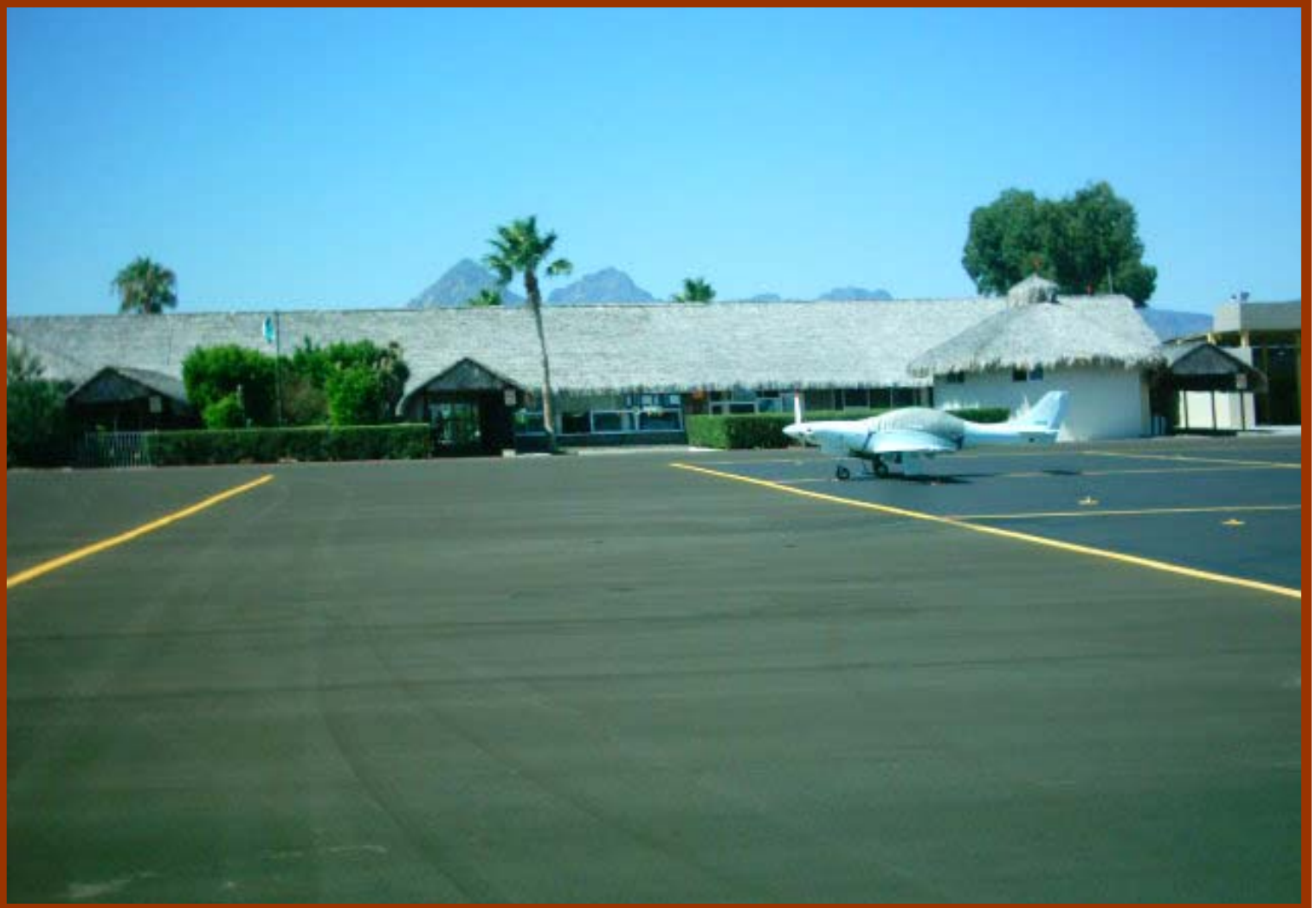
Reencarpetado y construcción de márgenes laterales en pista 10-28, rodaje y plataforma comercial, Aeropuerto de Loreto, B.C.S.
