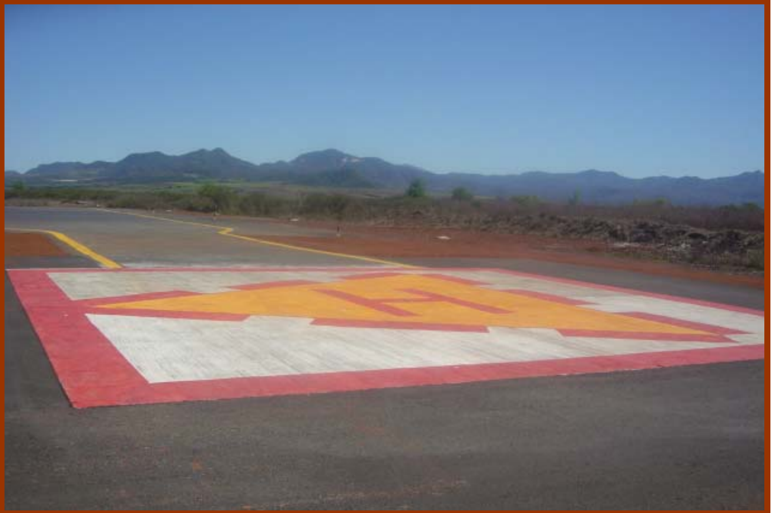
Reencarpelado de pista 02-20 y reconstrucción de la plataforma de aviación general, Aeropuerto de Tepic, Nay.
