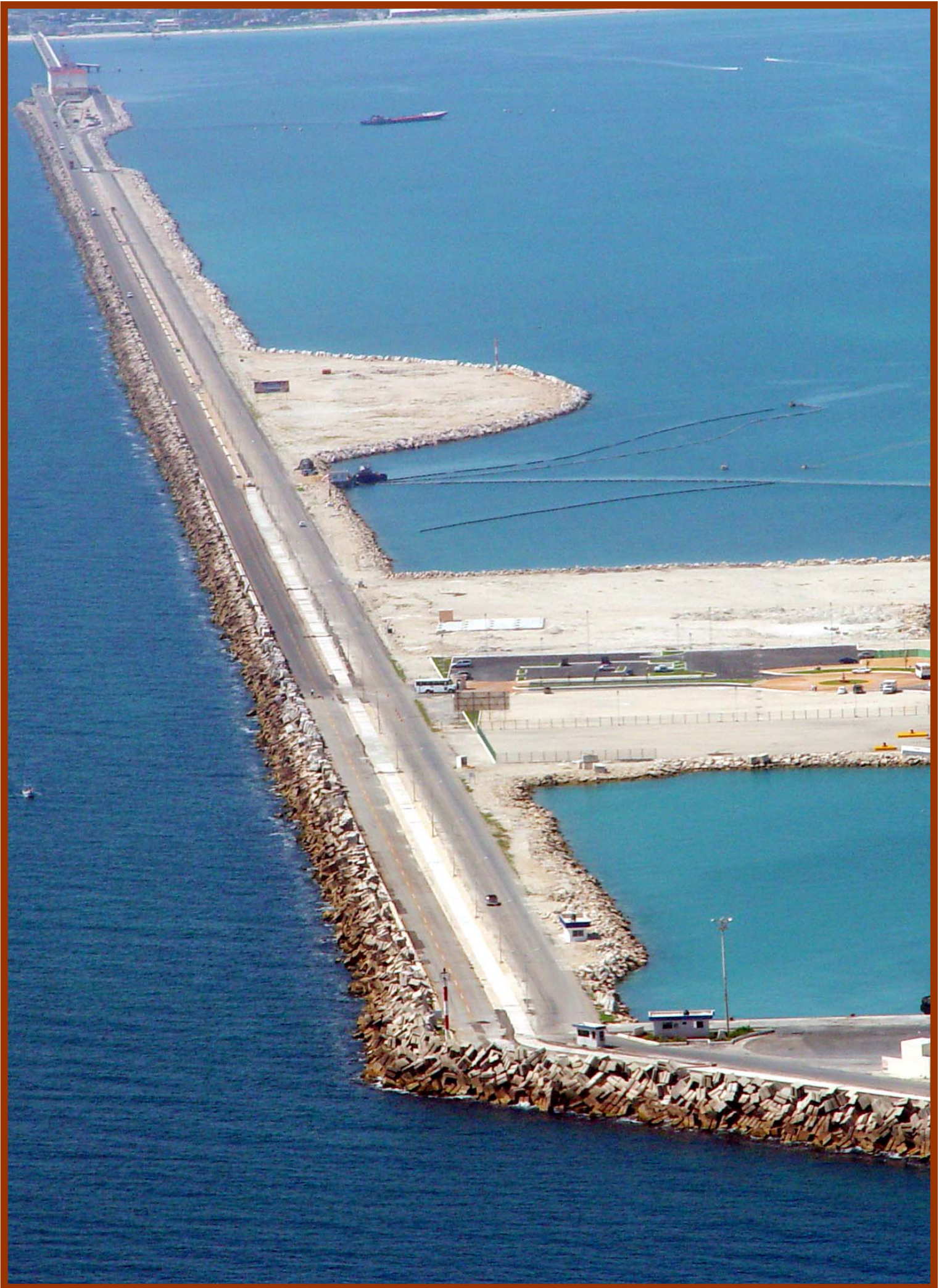
Pavimentación y construcción de casetas en el kilómetro 3+200 del viaducto, Puerto Progreso, Yuc.
