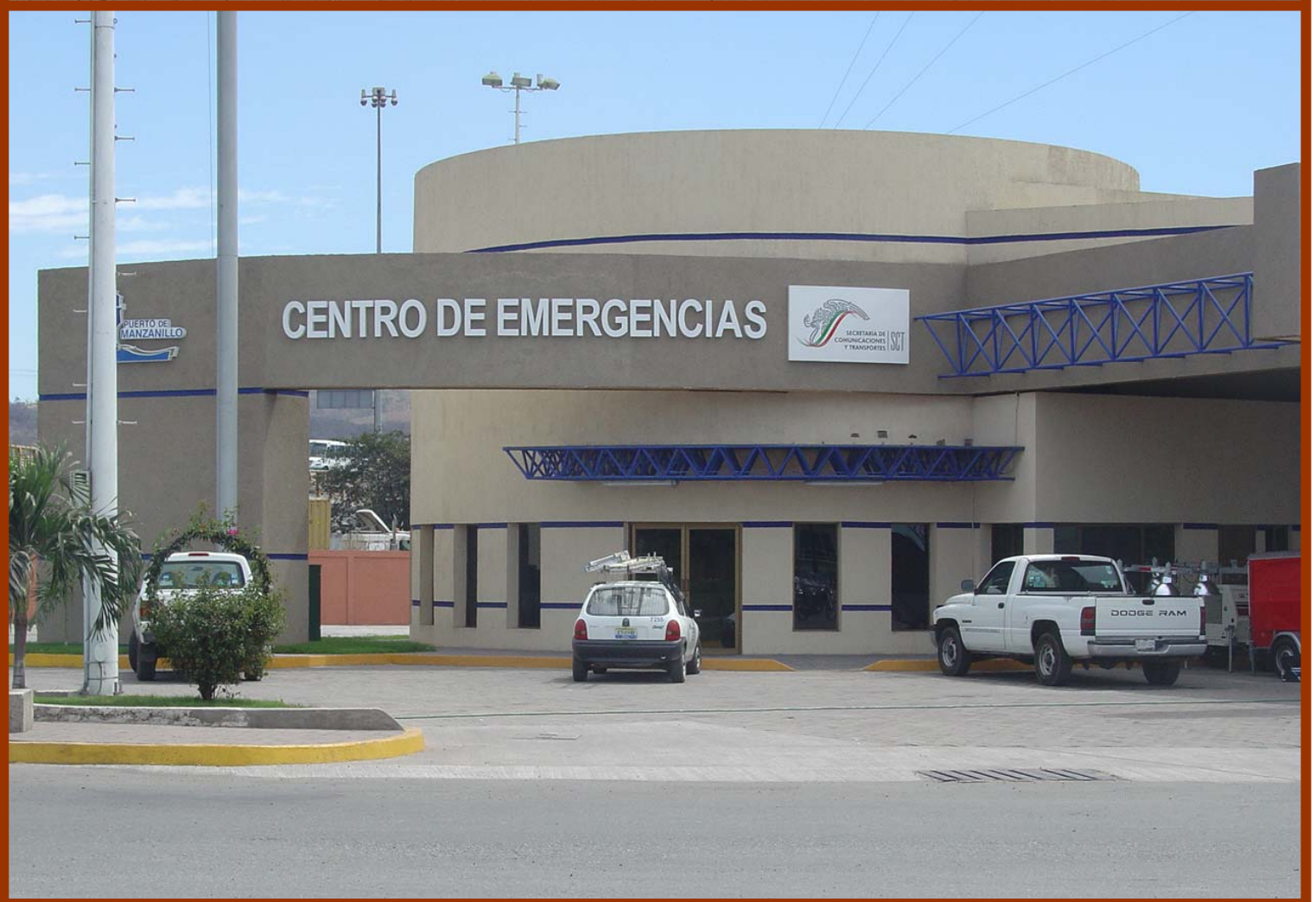
Construcción del Centro de Emergencias, Manzanillo, Col.
