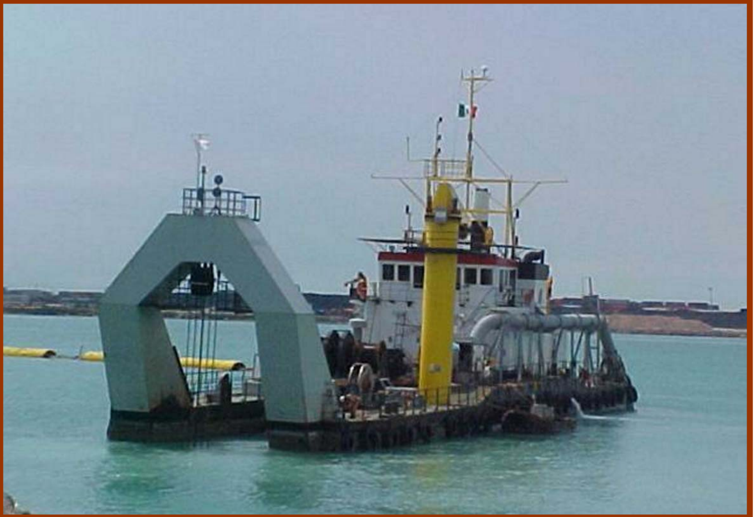
Dragado en canales de navegación, Altamira, Tamps.
