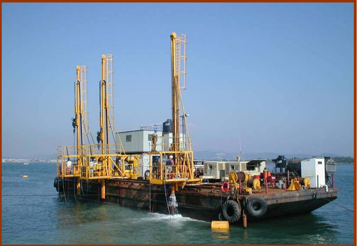
Dragado en dársena, Mazatlán, Sin.
