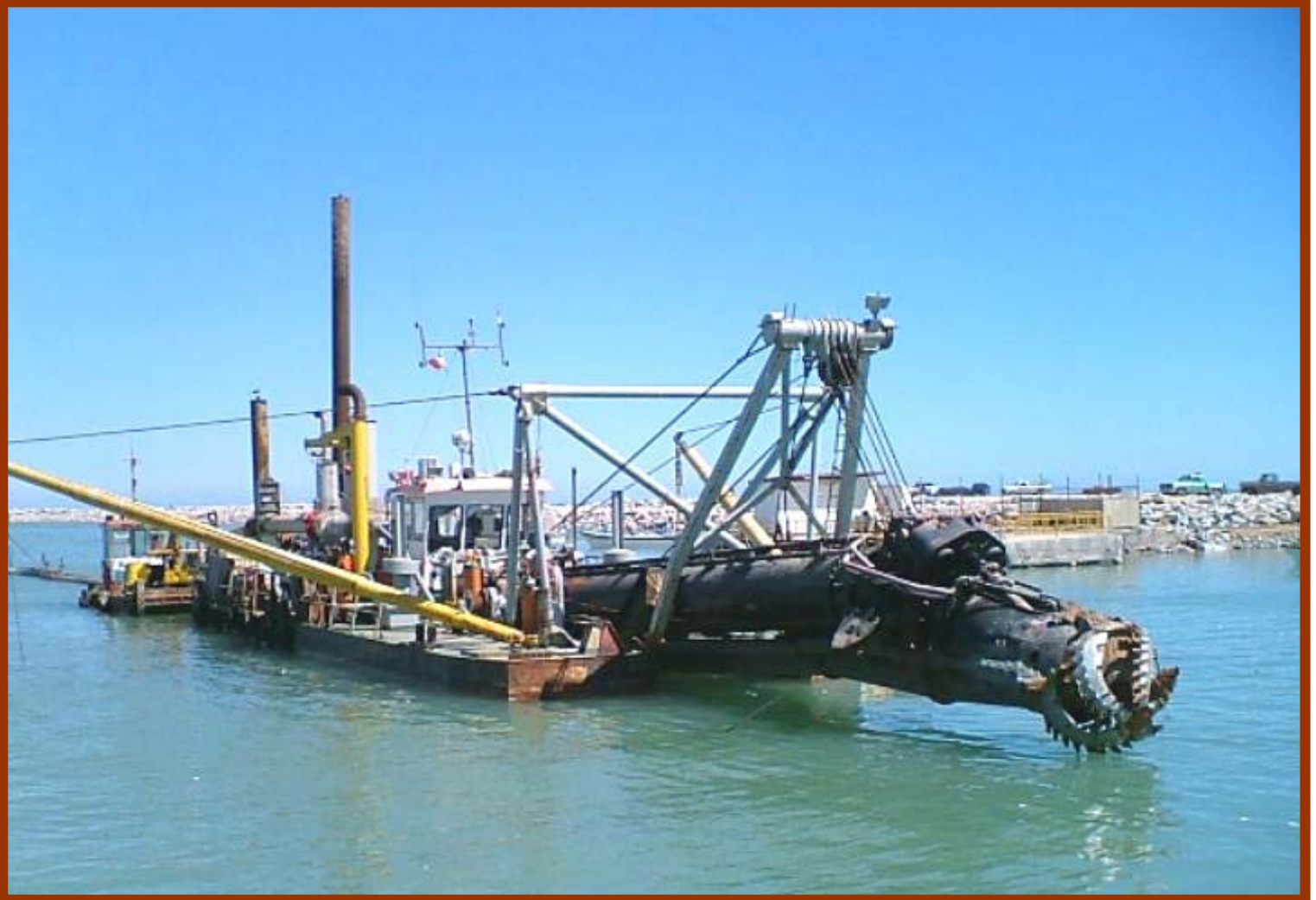
Dragado en el canal de navegación y dársena, San Felipe, B.C.
