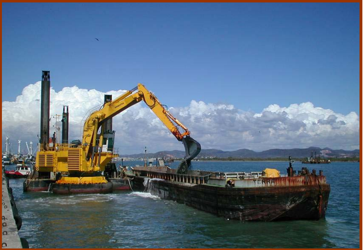
Dragado en dársena, Mazatlán, Sin.
