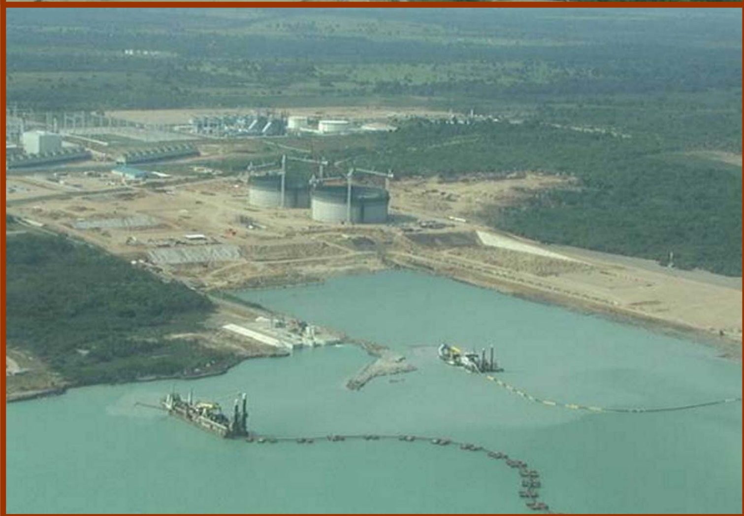
Dragado en canales de navegación, Altamira, Tamps.
