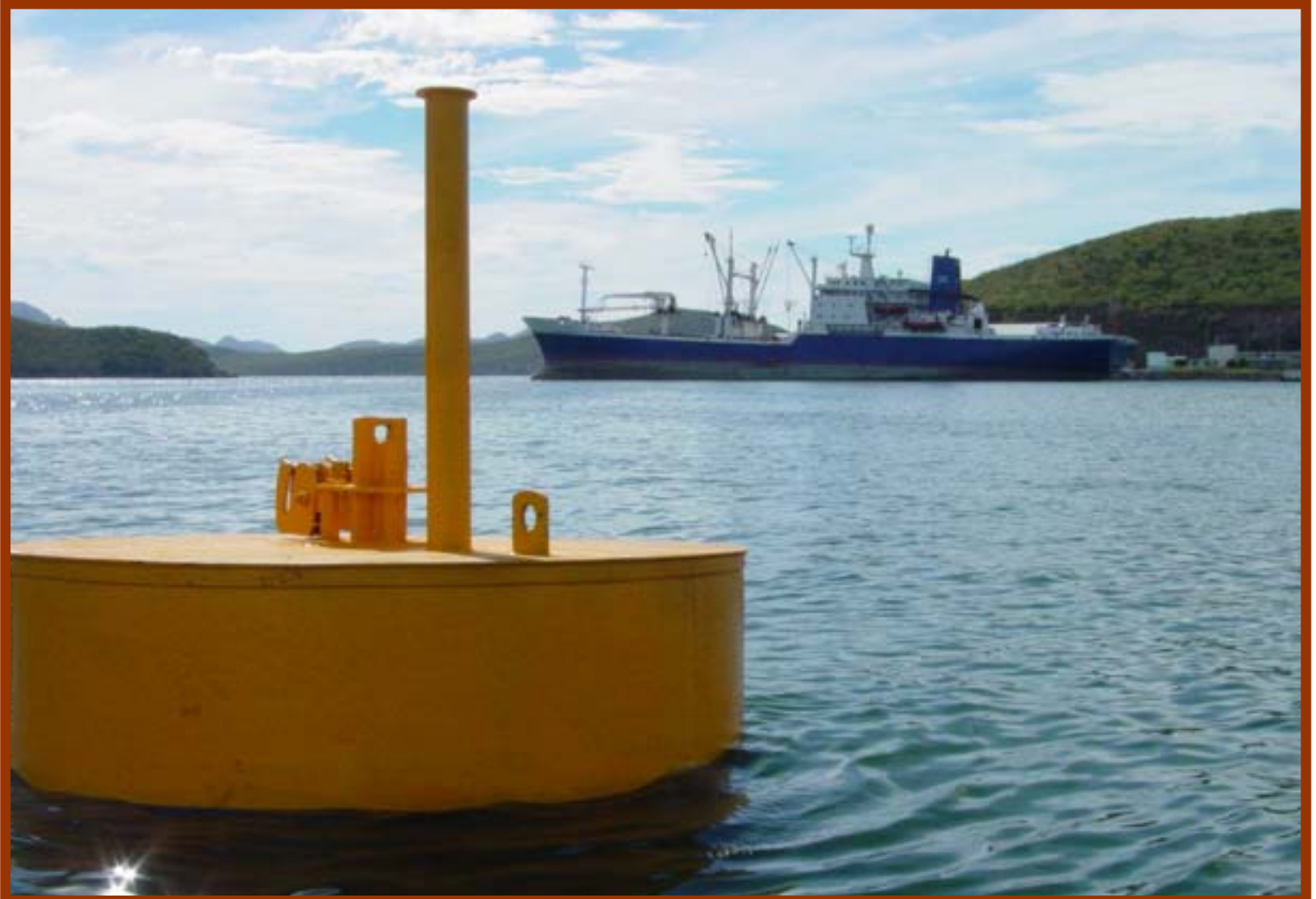
Construcción de boya de amarre, Topolobampo, Sin.
