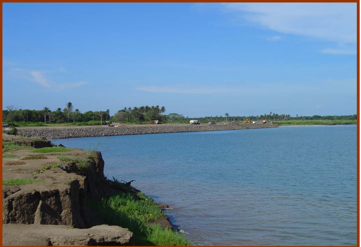
Construcción de patio y nivelación de terrenos, Dos Bocas, Tab.
