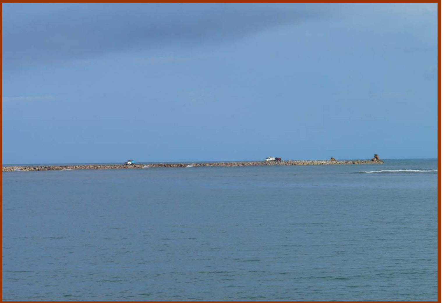
Construcción de espigón norponiente, Dos Bocas, Tab.
