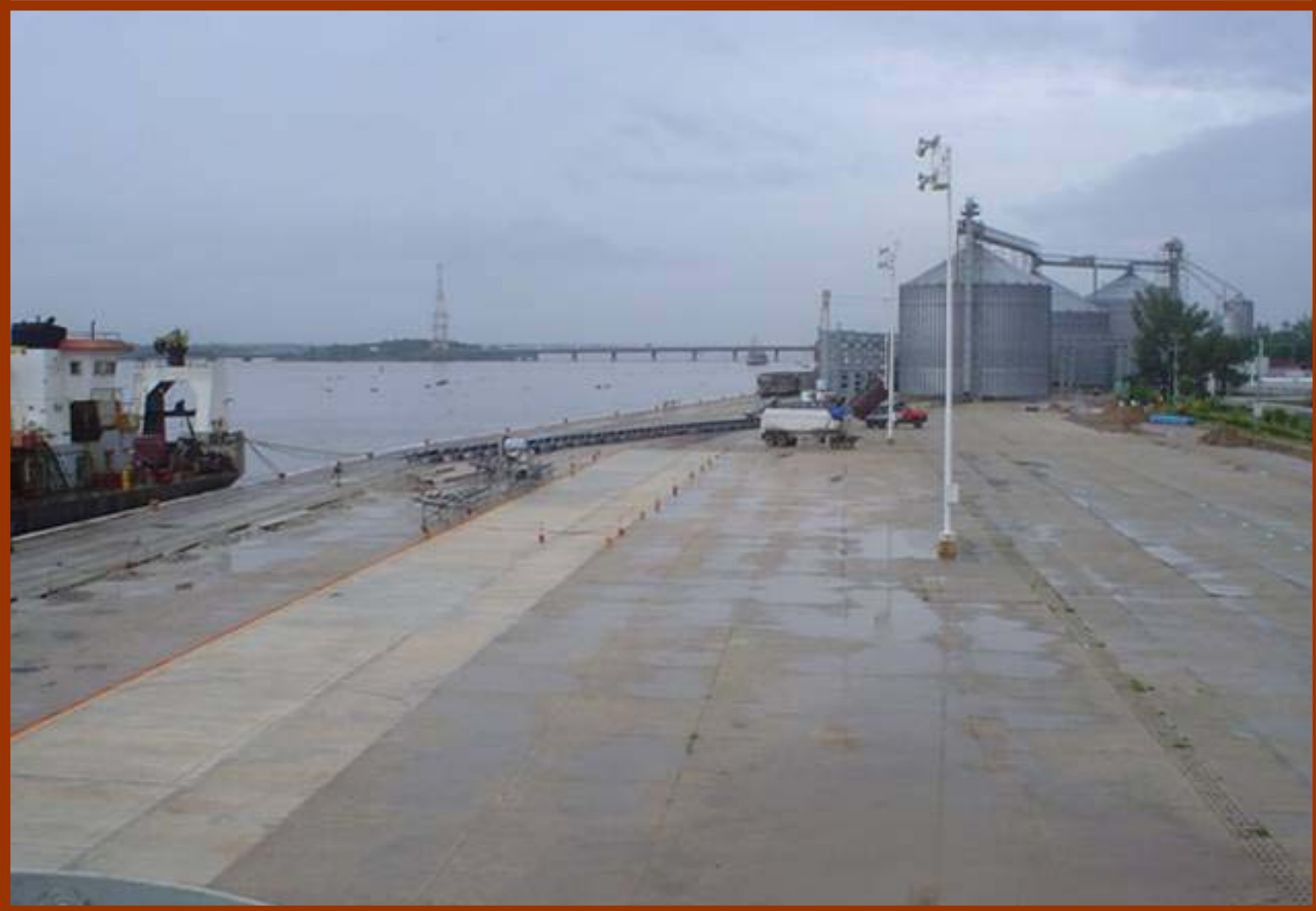
Prolongación del muelle de cabotaje y tablestacado en muelles 7 y 8, Coatzacoalcos, Ver.
