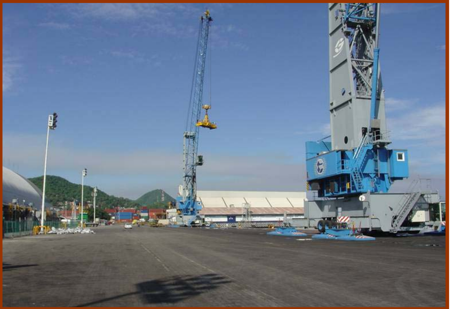
Construcción de patio, Manzanillo, Col.
