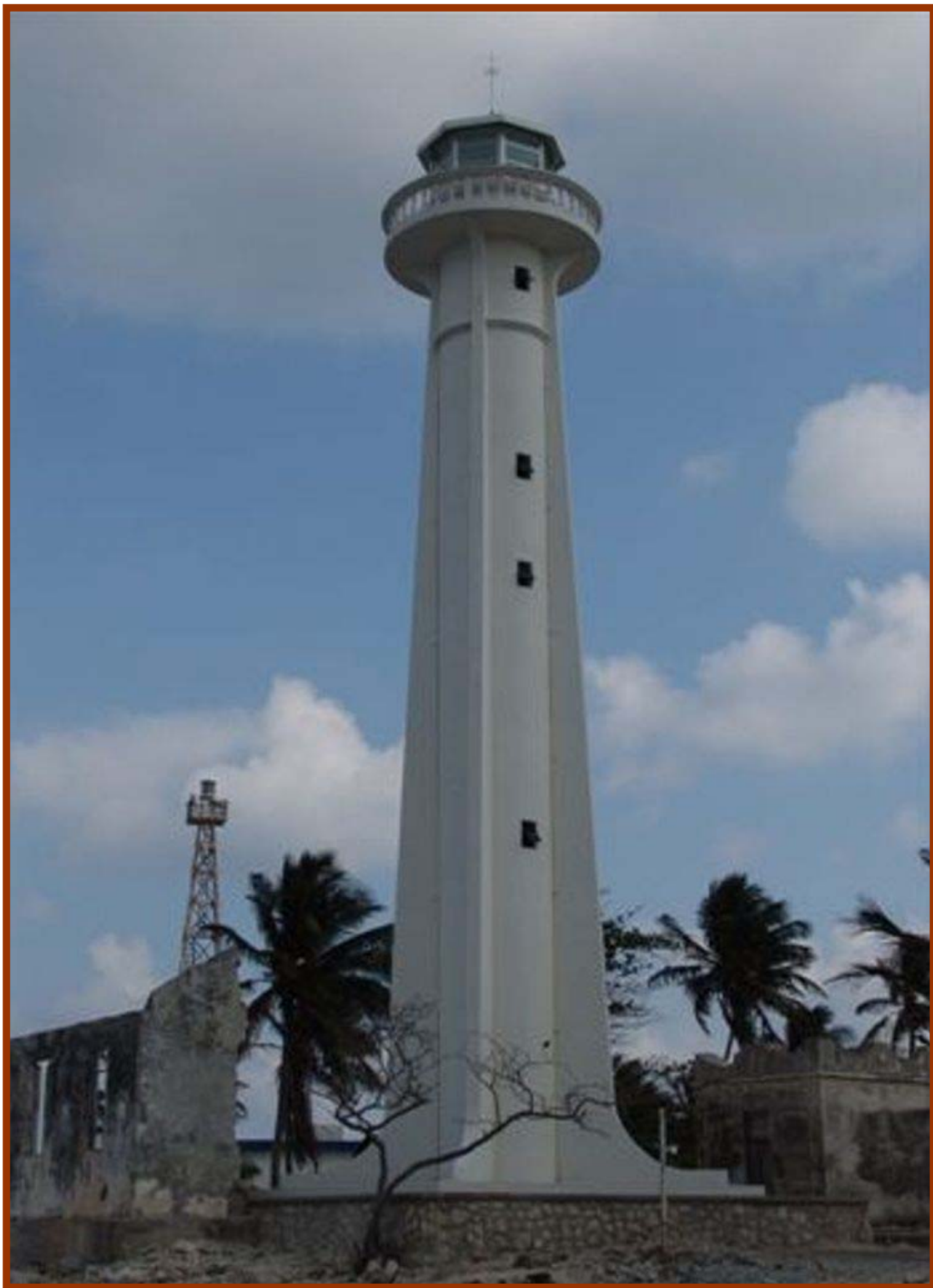
Construcción de faro en Punta Herrero, Majahual, Q.Roo
