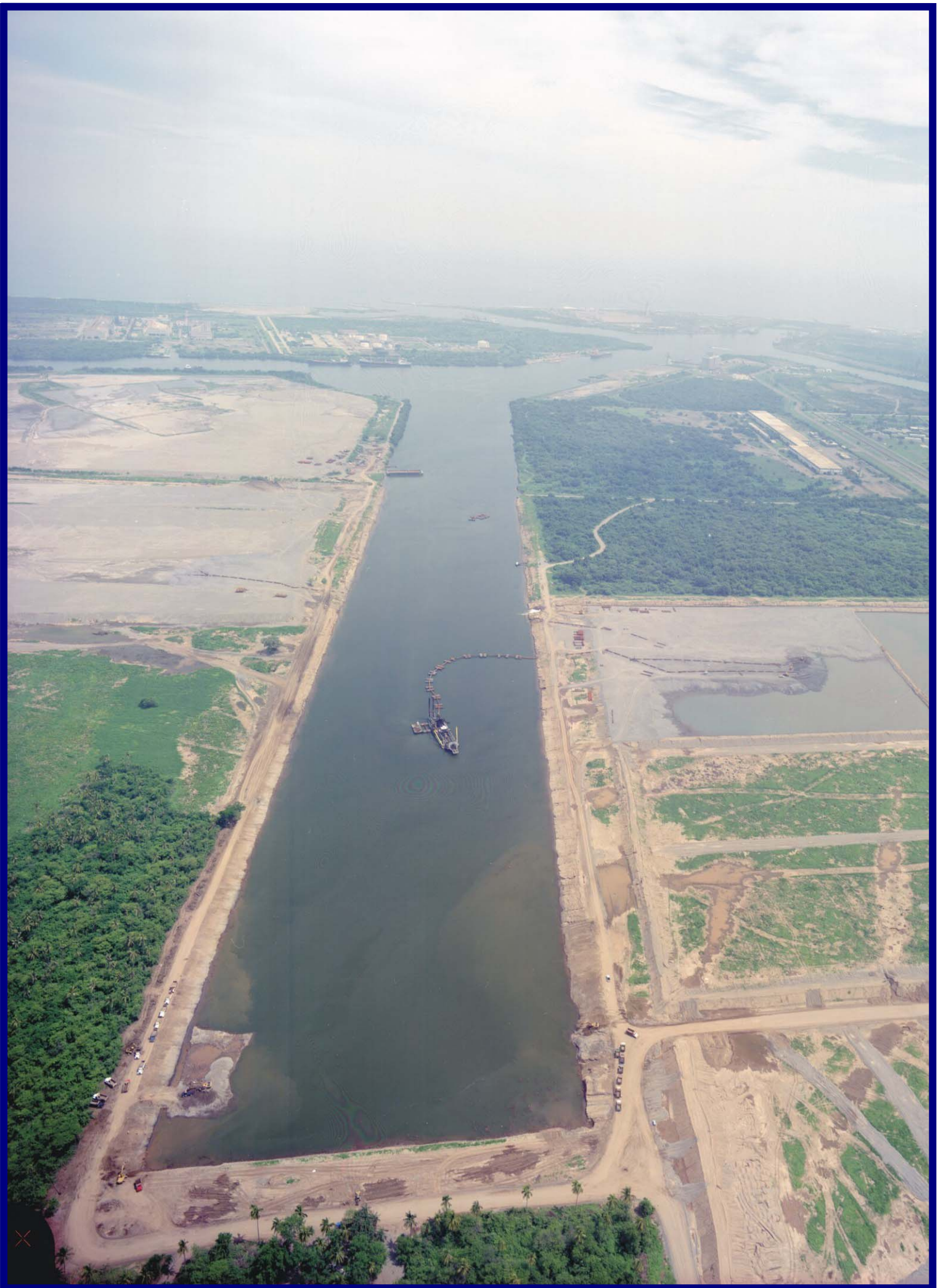
Dragado de canal interior, Lázaro Cárdenas, Mich.
