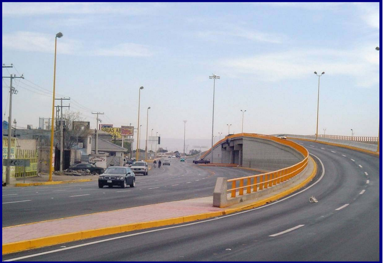
Carretera: Saltillo - Torreón Coah. Tramo: Paso a desnivel Periférico - El Tajito
