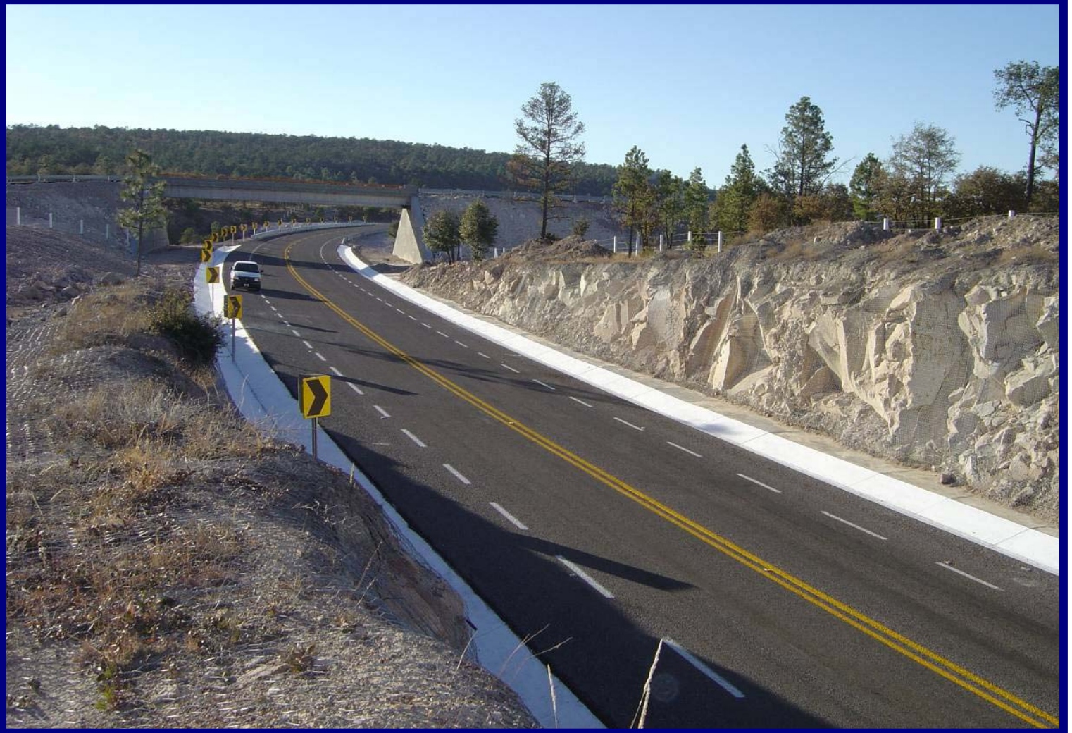
Carretera: Durango - Mazatlán, Dgo. Tramo: Puente Nevarías - Entronque Otinapa
