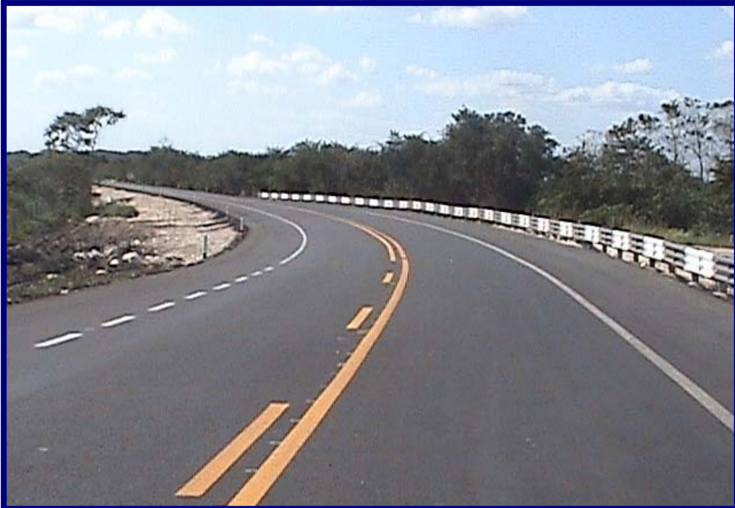
Carretera: Escárcega - Chetumal, Cam. Tramo: Escárcega - Xpujil
