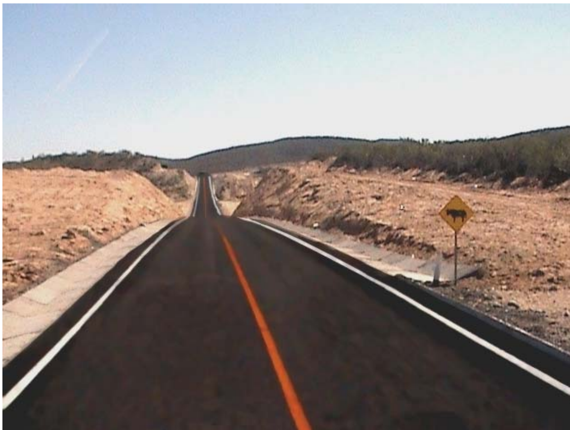
Carretera: Costera del Golfo, B.C.S. Tramo: Los Barriles - El Cardonal
