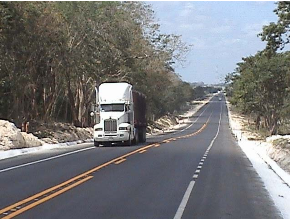
Carretera: Escárcega - Chetumal, Cam. Tramo: Escárcega - Xpujil
