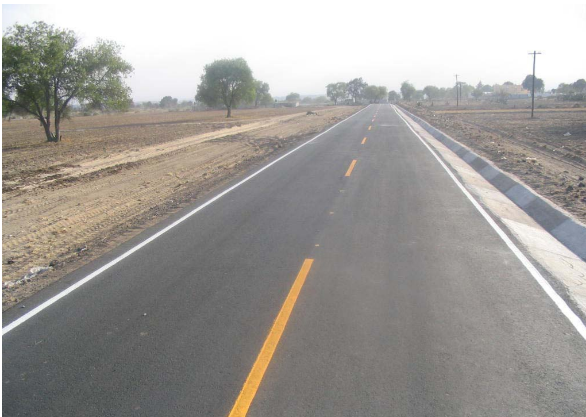
Camino Rural: Altzayanca - Santa Cruz Pocitos - Allende, Tlax.
