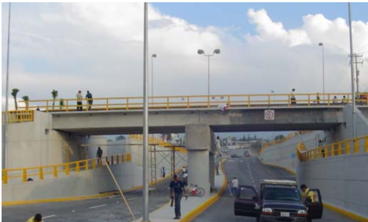
Programa de Convivencia Urbano-Ferrovial. Paso a desnivel inferior vehicular “El Landín” en Saltillo, Coah.
