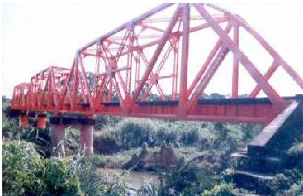
Ferrocarril del Istmo de Tehuantepec (FIT). Trabajos de protección anticorrosiva en el puente de la línea Z km 157+47, ubicado a la altura de la estación ferroviaria Tolosita, Oax.
