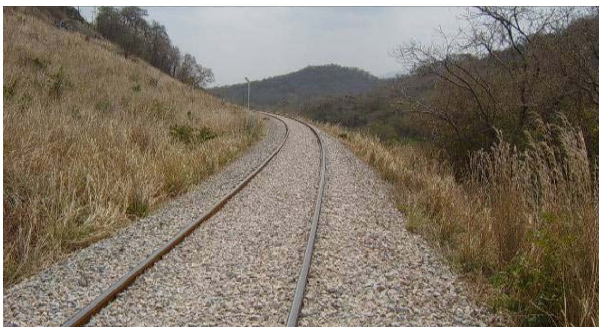
Ferrocarril del Istmo de Tehuantepec (FIT). Conservación mecanizada de vía, línea Z km 220+014 en Almoloya, Oax.
