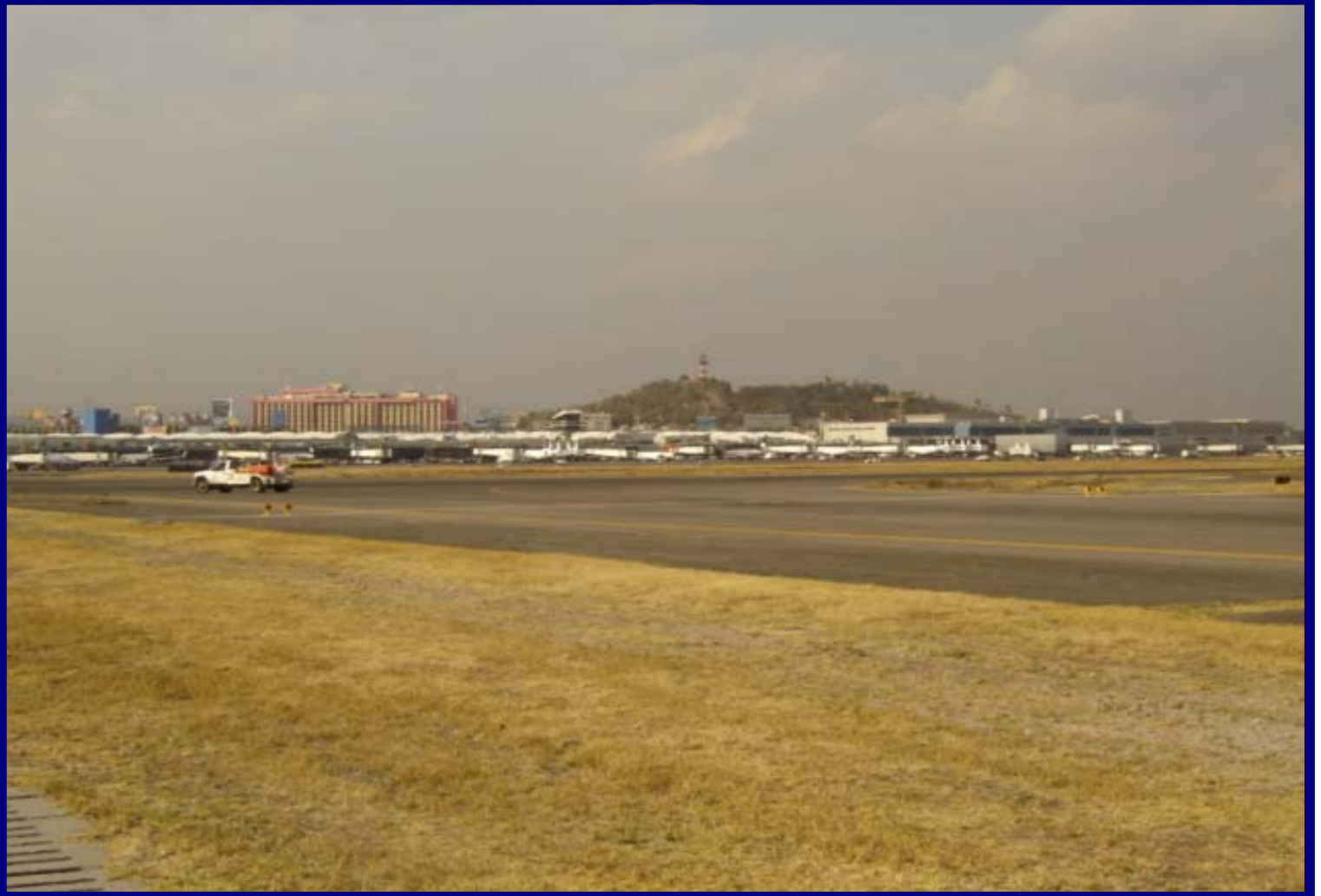
Aeropuerto Internacional de la Ciudad de México (AICM). Instalación de sistema de barras de parada en E205D.
