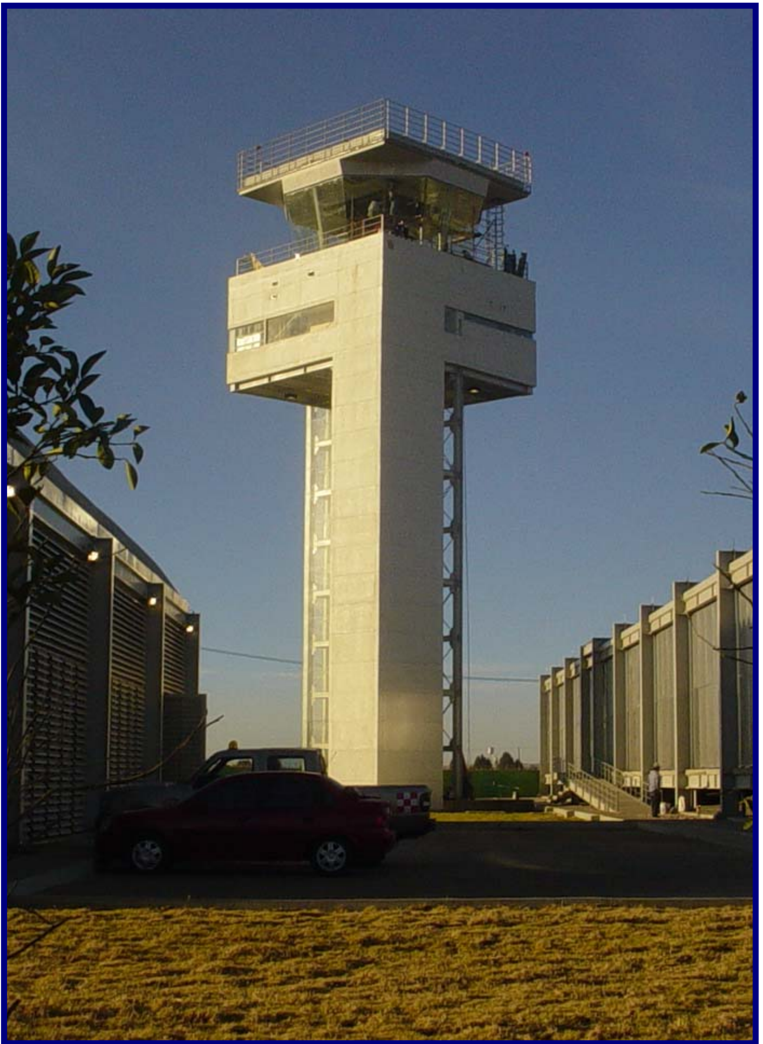
Aeropuerto de Toluca, Edo. de Méx. Construcción de la nueva torre de control.
