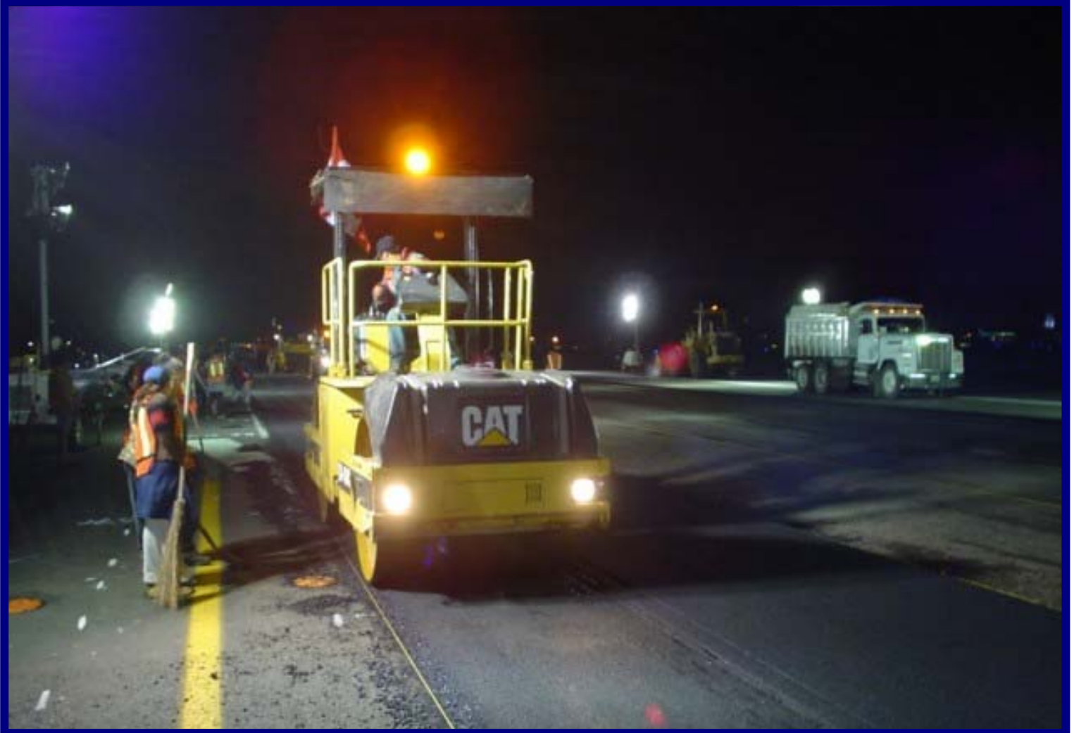
Aeropuerto Internacional de la Ciudad de México (AICM). Rehabilitación de la pista 05 Izquierda / 23 Derecha.
