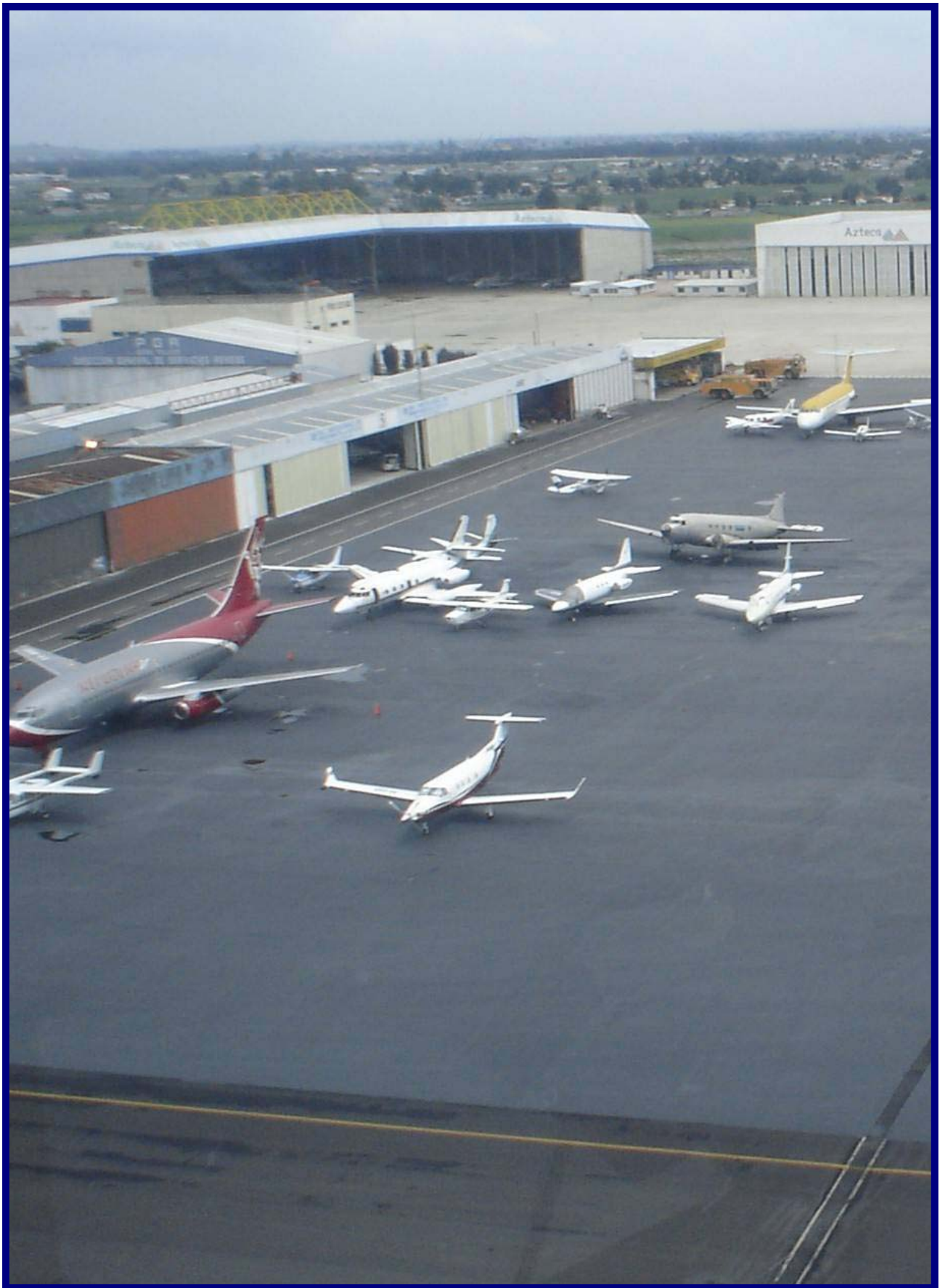
Aeropuerto de Toluca, Edo. de Méx. Rehabilitación y ampliación de la plataforma general.
