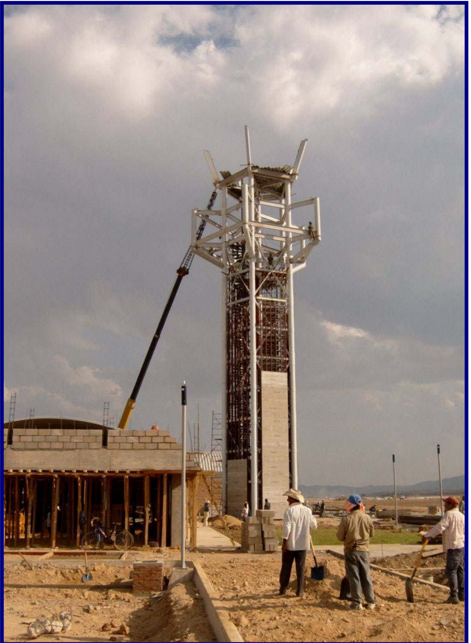
Aeropuerto Ángel Albino Corzo, Tuxtla Gutiérrez, Chis. Construcción de la primera etapa de la torre de control.
