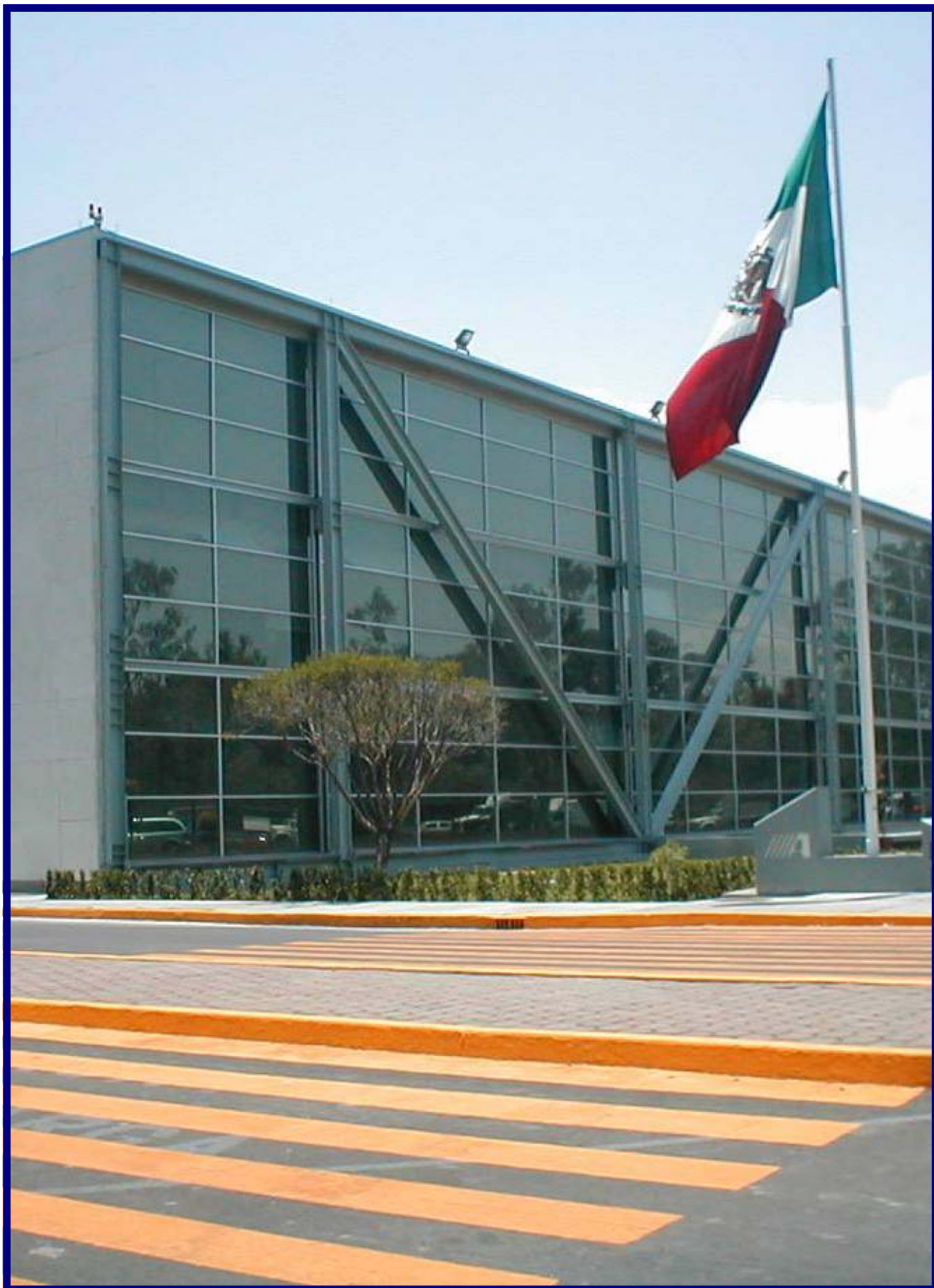
Construcción del edificio de Oficinas Generales en el conjunto de ASA, para reubicación de Servicios a la Navegación en el Espacio Aéreo Mexicano (SENEAM).
