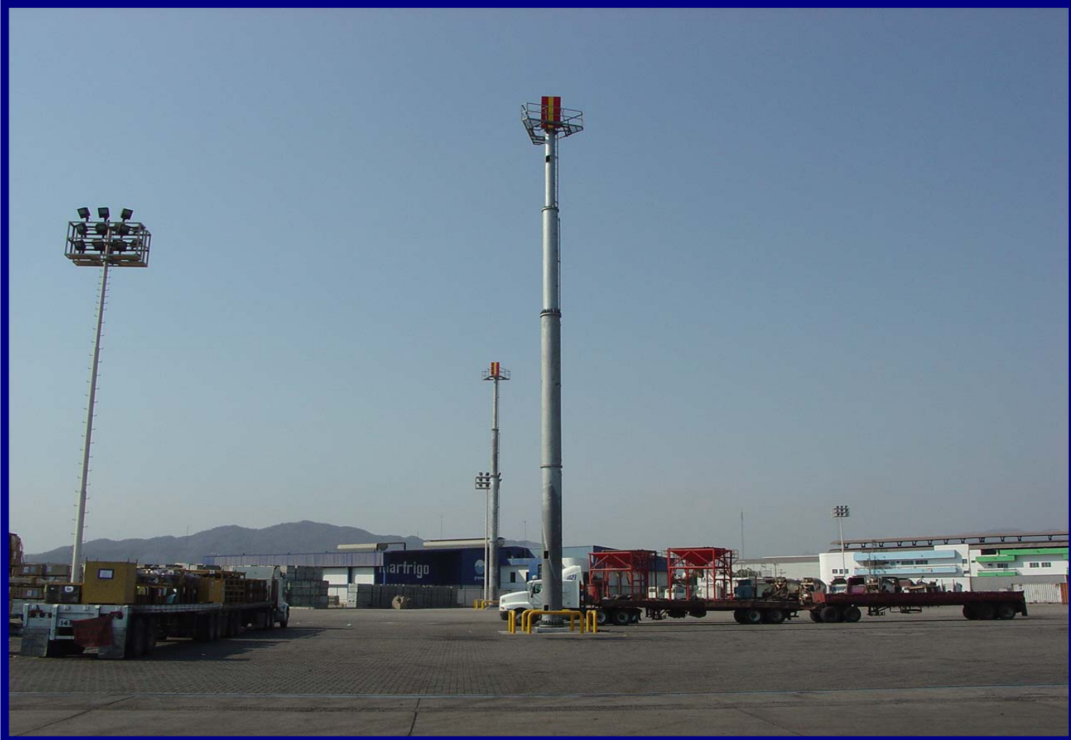
Construcción de balizas de enfilación, Manzanillo, Col.
