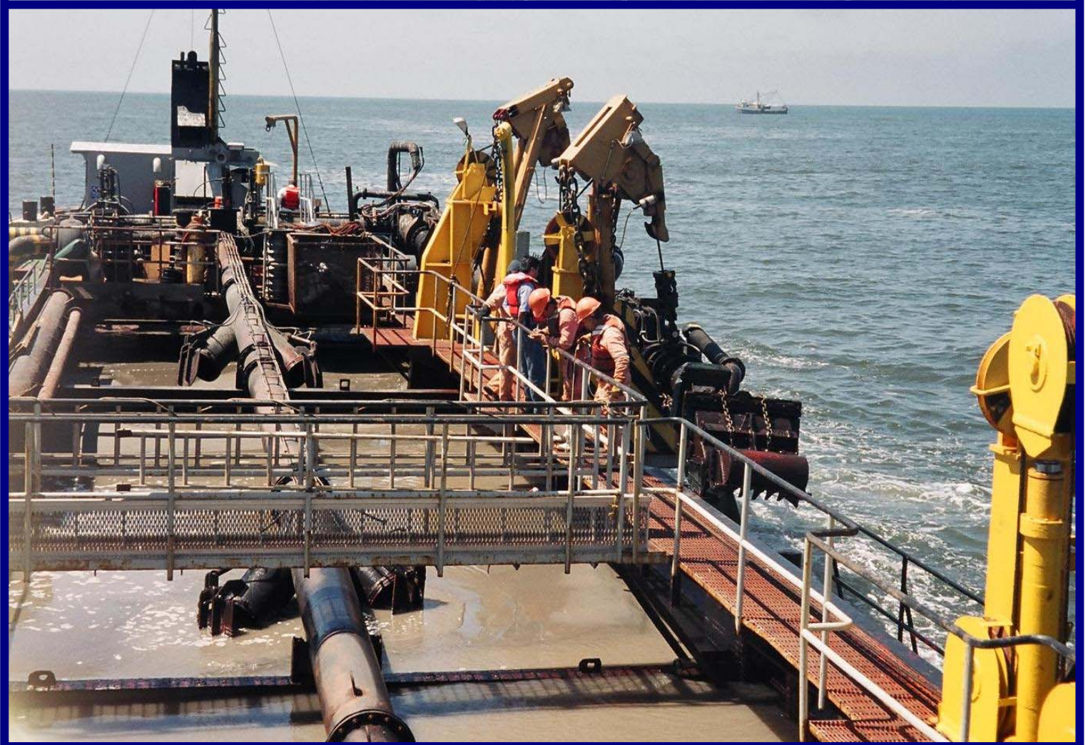
Dragado de canal de acceso, Altata, Sin.
