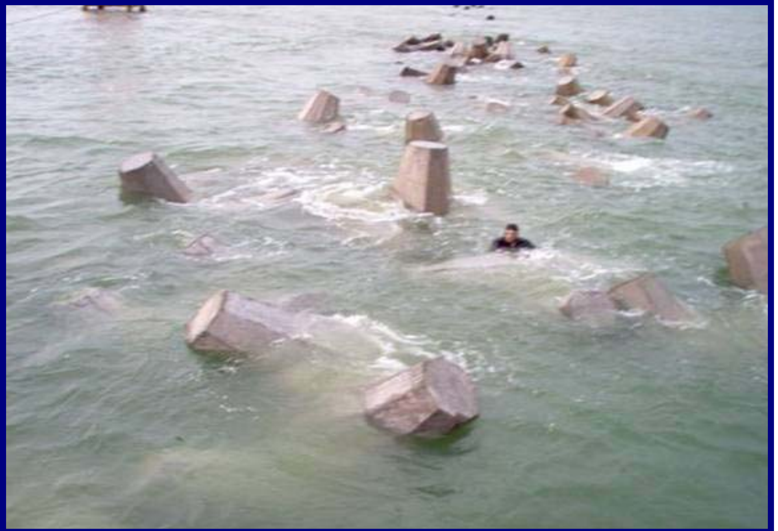
Prolongación de la escollera norte, Tuxpan, Ver.
