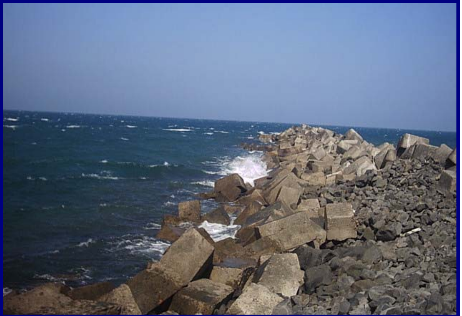
Rehabilitación de obras de protección, Alvarado, Ver.
