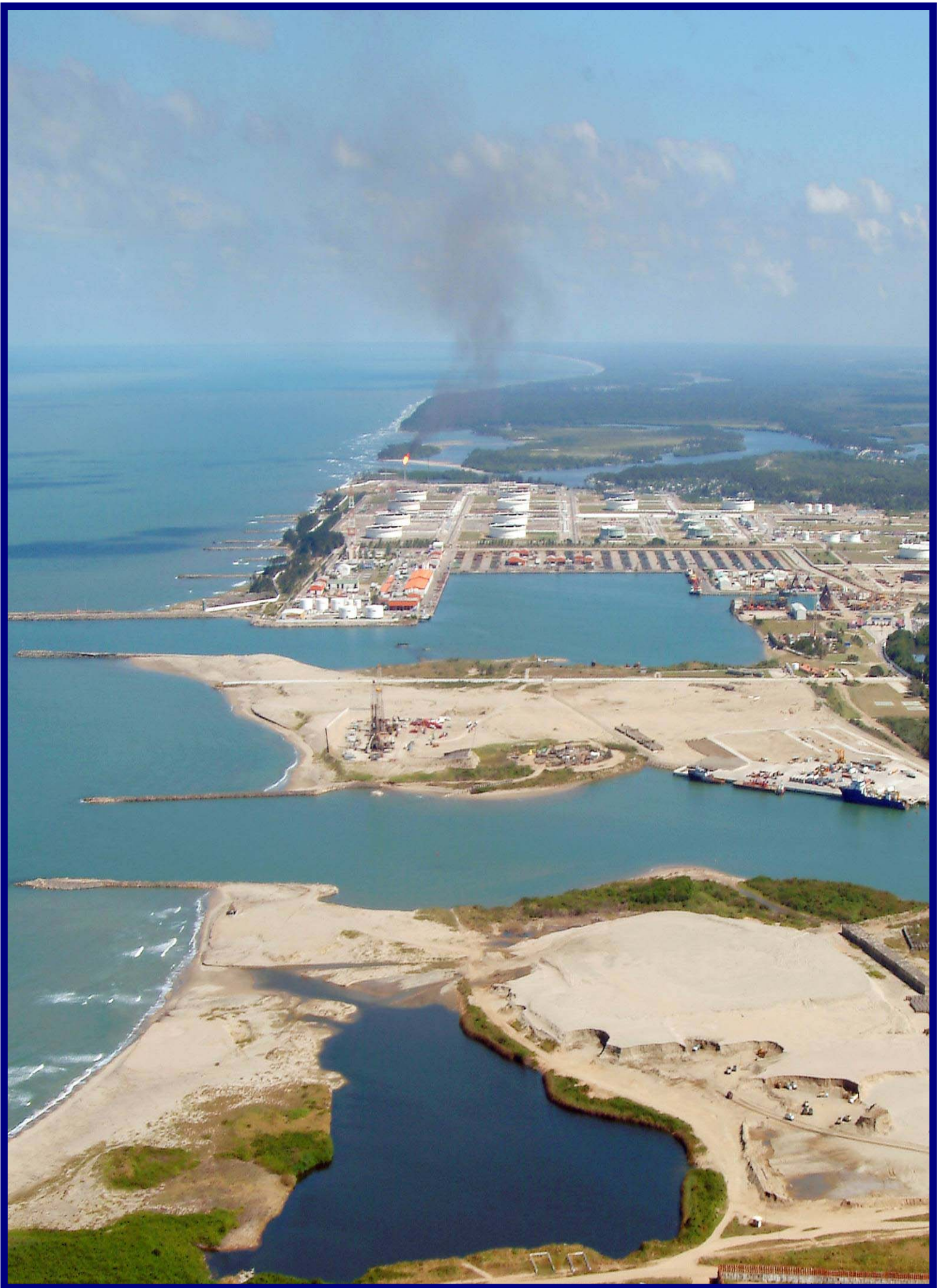
Construcción de muelle y espigones, Dos Bocas, Tab.
