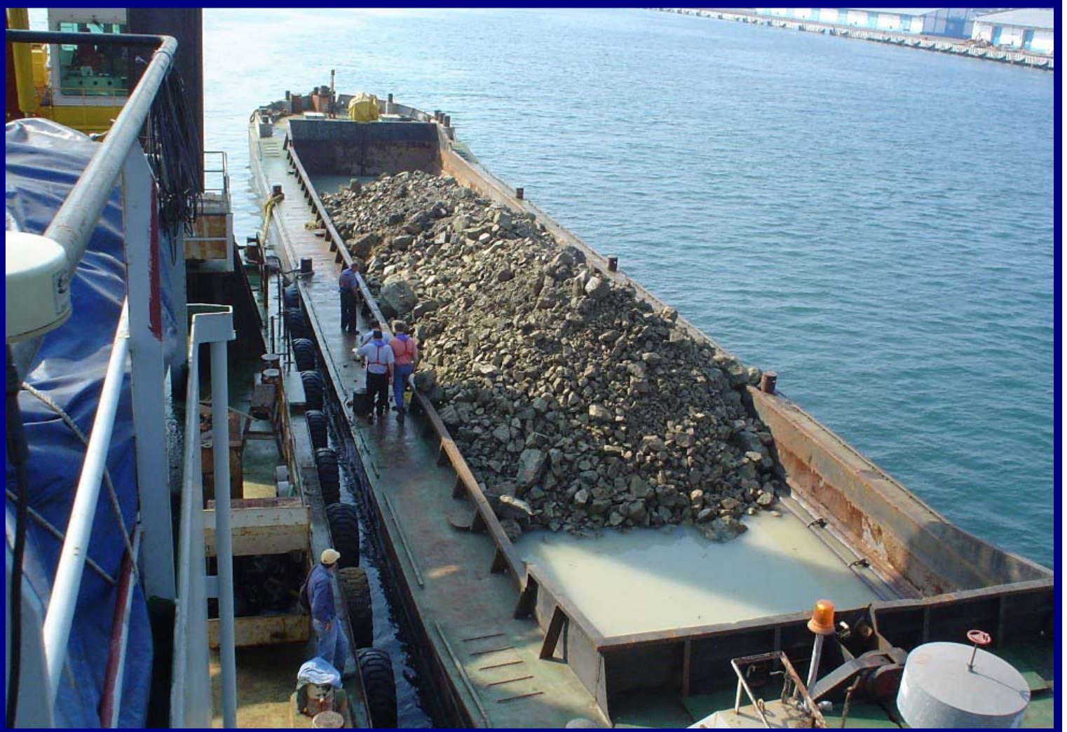
Dragado del manto rocoso en dársena de ciaboga, Mazatlán, Sin.
