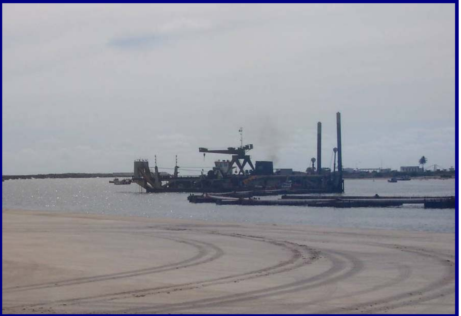
Dragado de canales de acceso y dársena fiscal, Puerto Chiapas, Chis.
