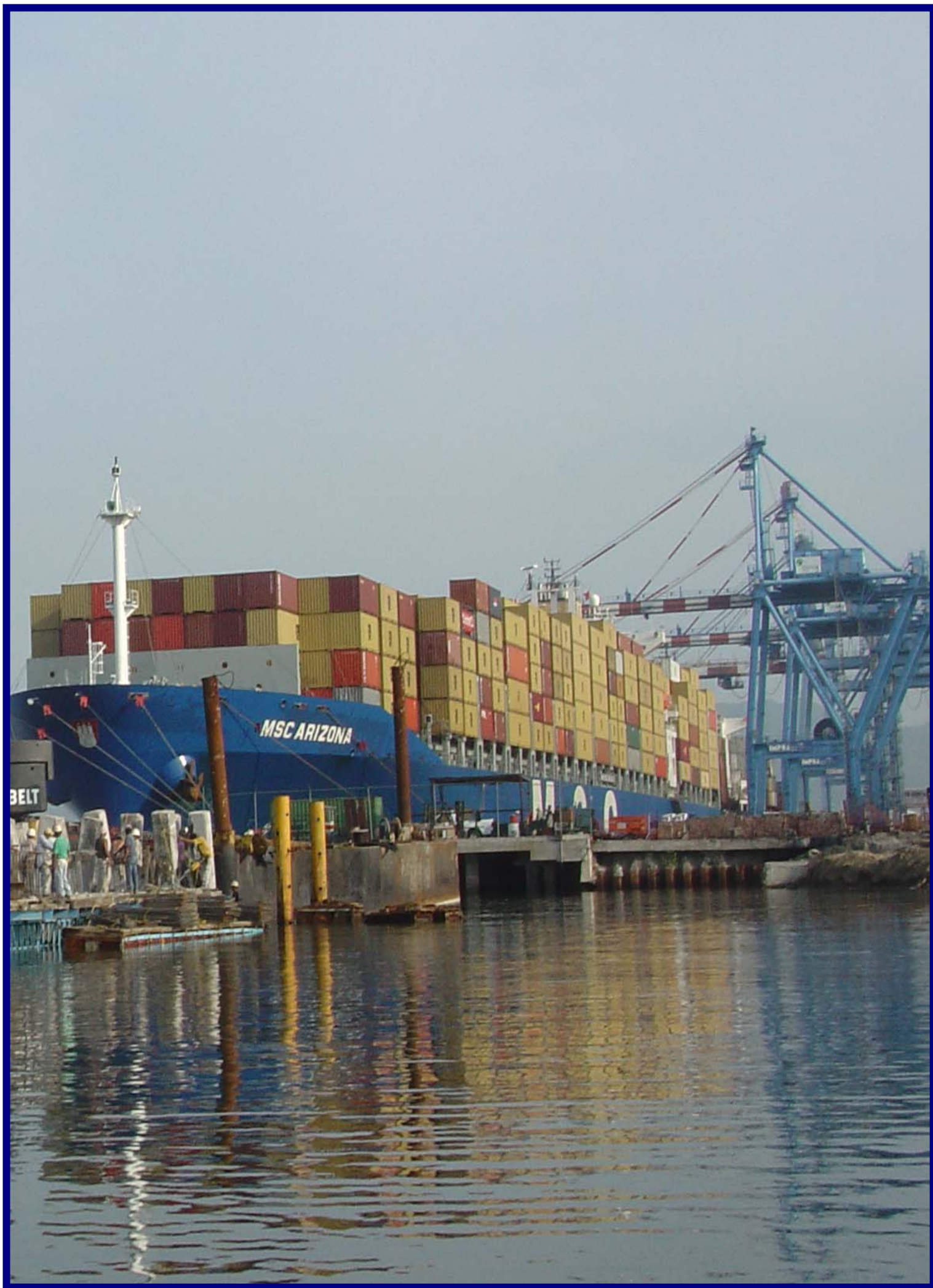
Construcción de posición de atraque número 11, Manzanillo, Col.
