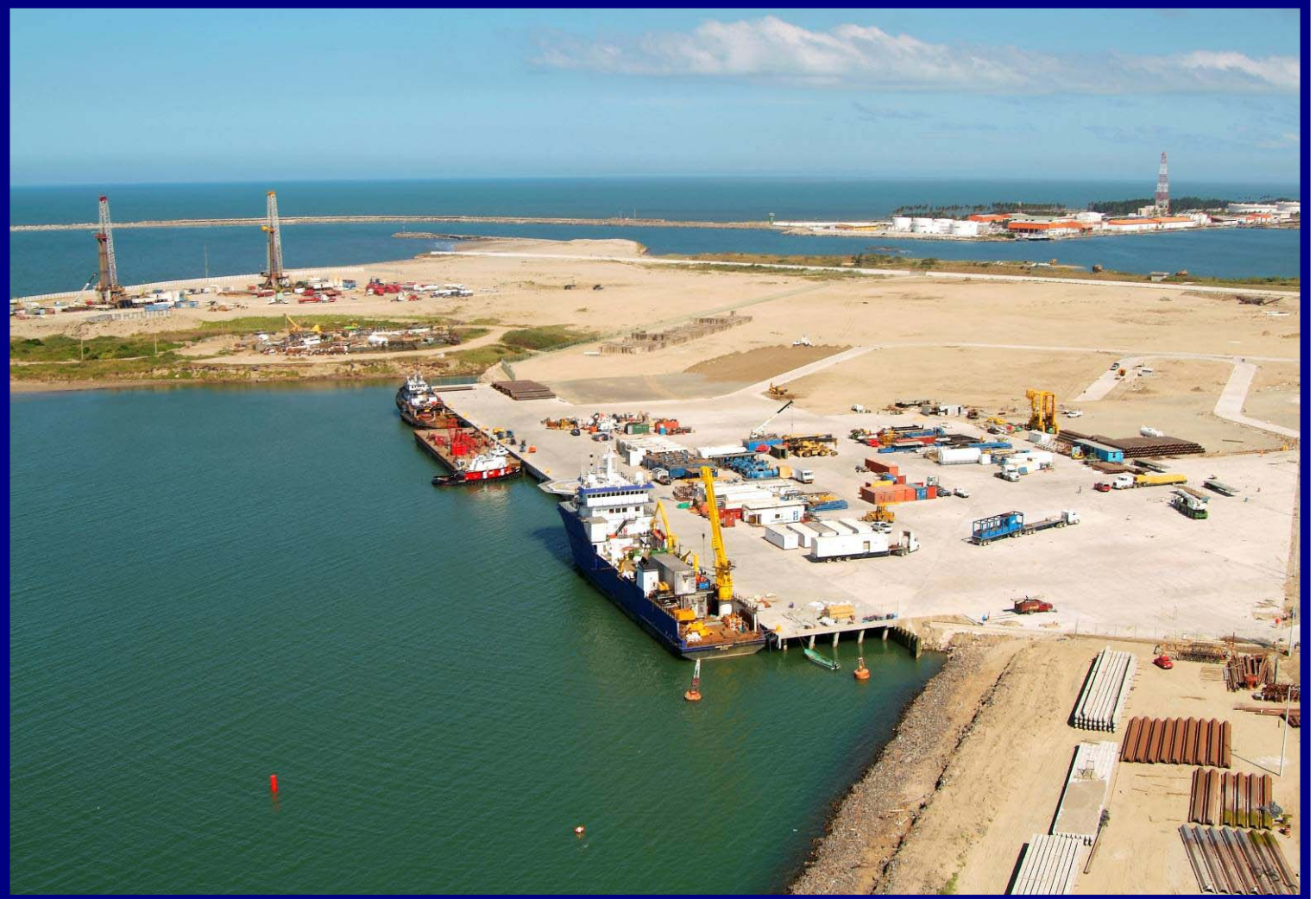
Construcción de muelle y espigones, Dos Bocas, Tab.
