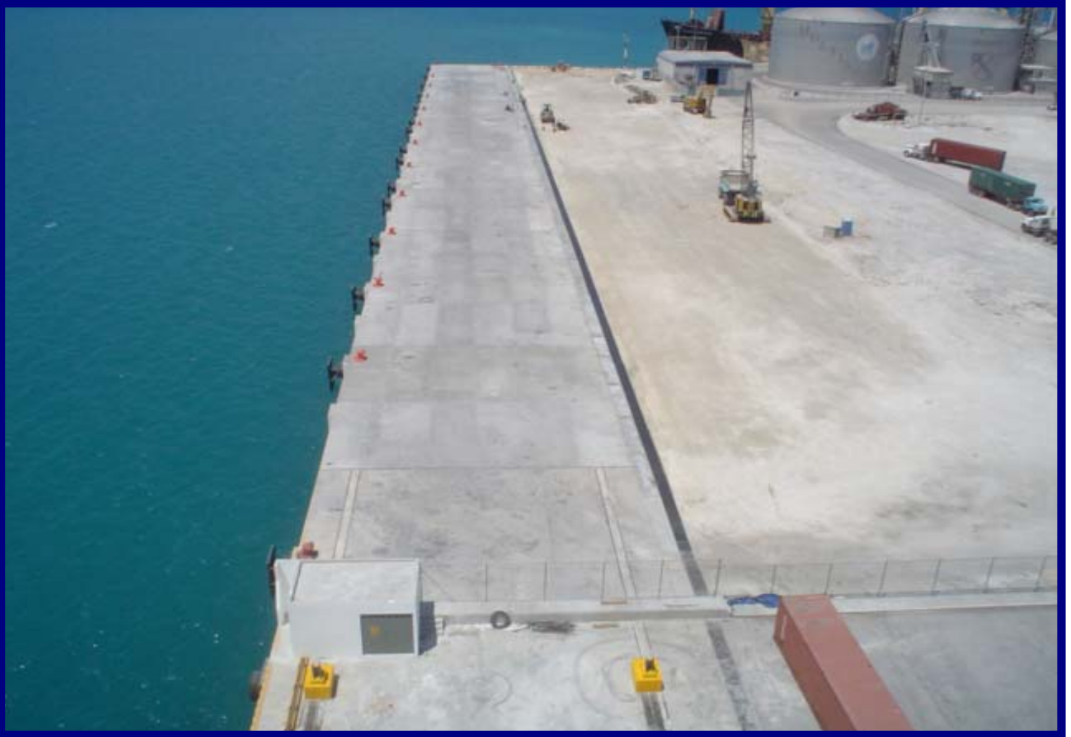
Construcción de muelle en la posición de atraque número 7, Progreso, Yuc.
