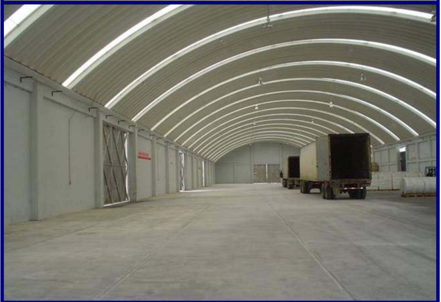
Ampliación de la bodega número 4, Coatzacoalcos, Ver.
