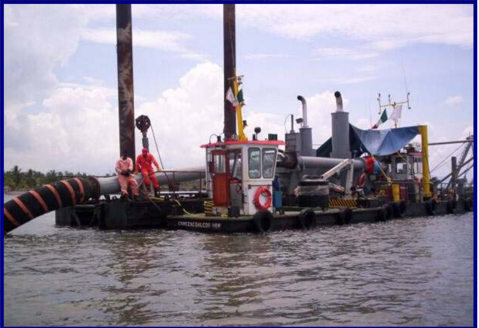
Dragado de canal de acceso y dársena de pesca, San Blas, Nay.
