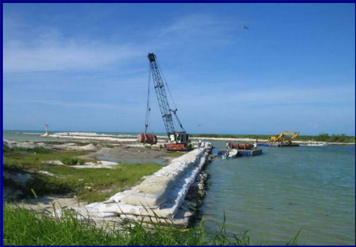
Dragado de canal de acceso, El Cuyo, Yuc.
