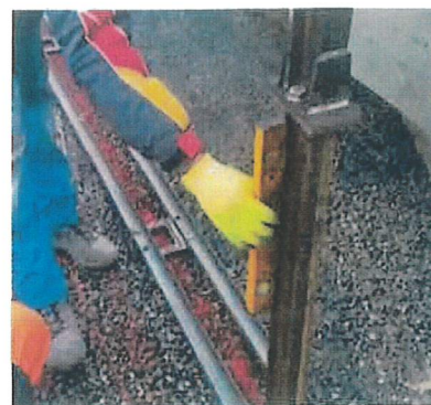
Fig. 10: Comprobación con el nivel de burbuja
