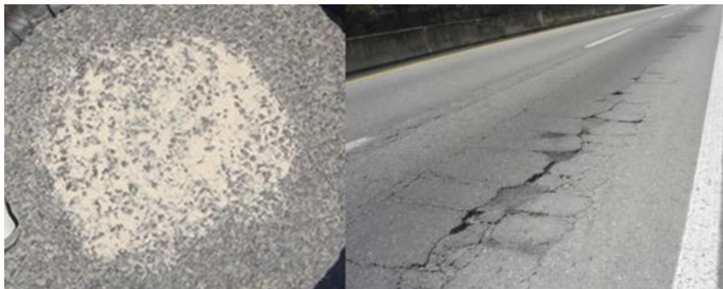
Figura 6. CÍRCULO DE ARENA para medición de Macrotextura y Deterioros
