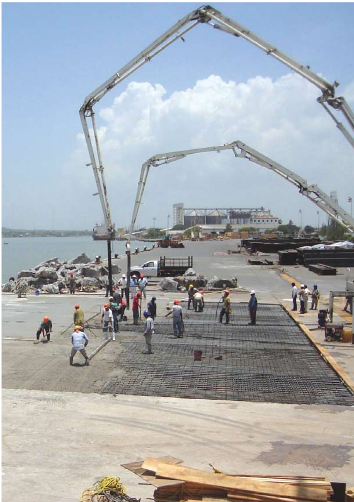
Reforzamiento de muelles 10 y 11, Tampico, Tamps.
