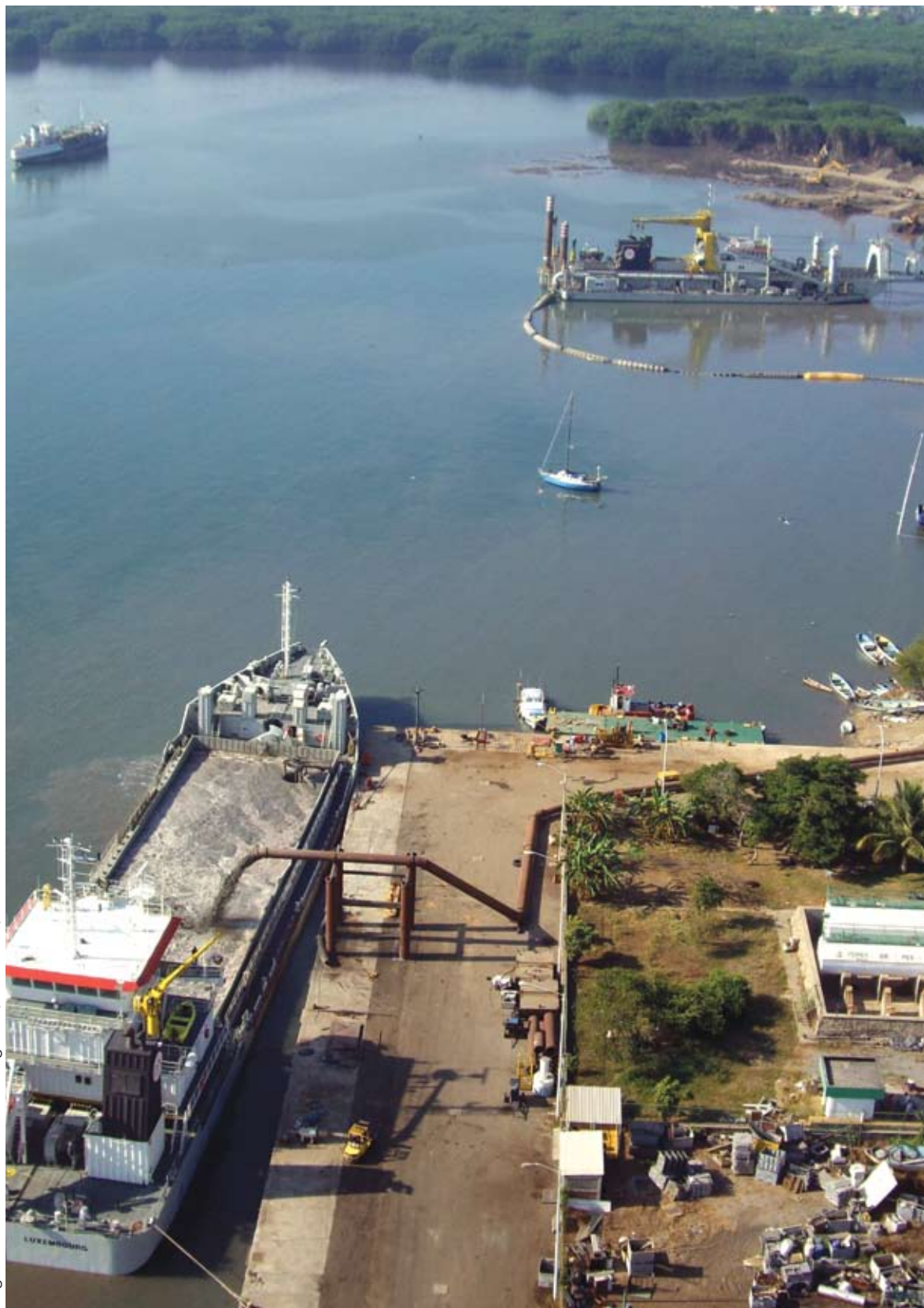
Dragado en el canal norte de navegación, Manzanillo, Col.
