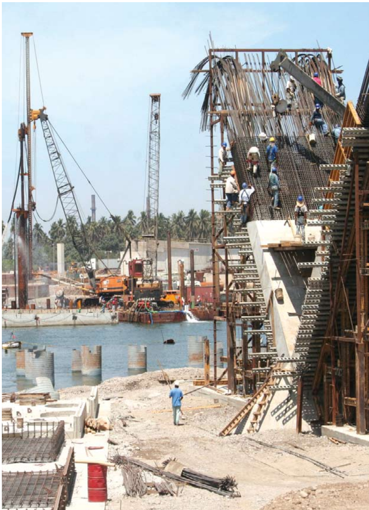
Construcción del puente "Albatros", Lázaro Cárdenas, Mich.
