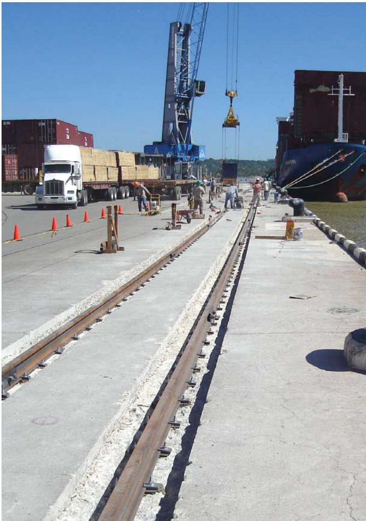
Reconstrucción de vías dentro del Recinto Portuario, Tampico, Tamps.
