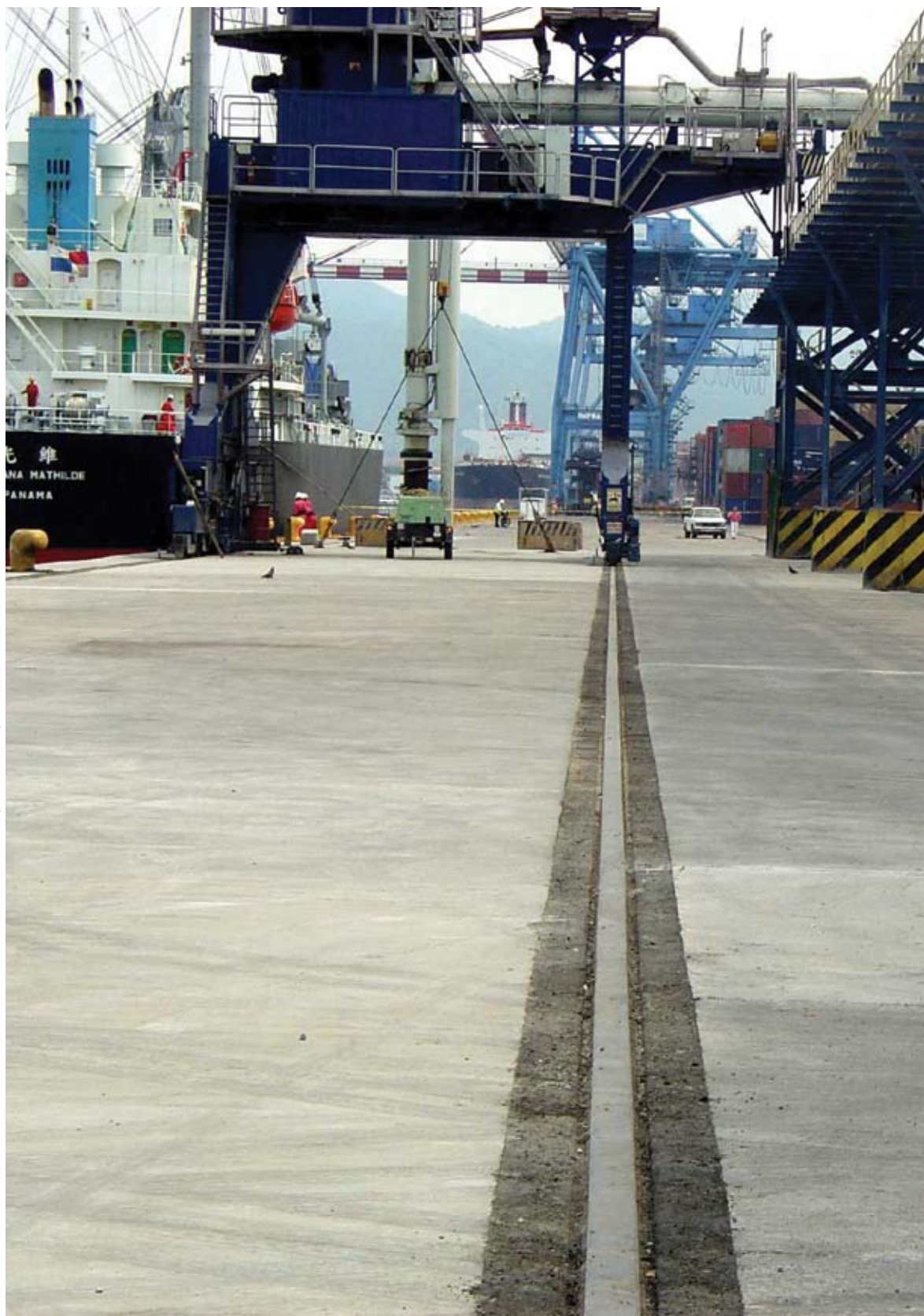
Reconstrucción de losa de rodamiento en los muelles de la Banda "C", Manzanillo, Col.
